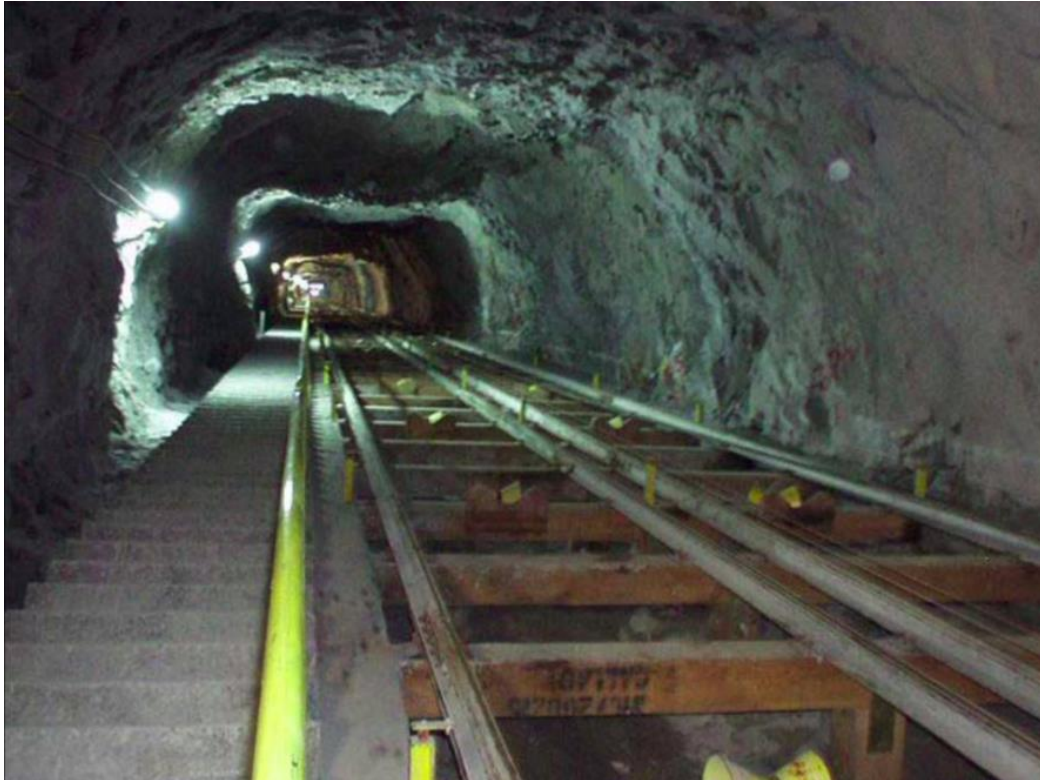
Figura 4: Pique inclinado en la mina Yauliyacu. Fuente, mina Yauliyacu.
