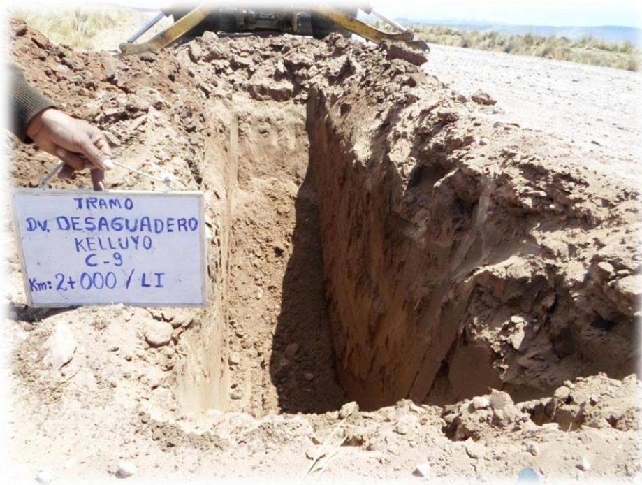
FOTO N°01: En la calicata N°9 se observa un suelo areno limosa de color pardo claro, al lado izquierdo de la carretera en la prog. 2+000.
