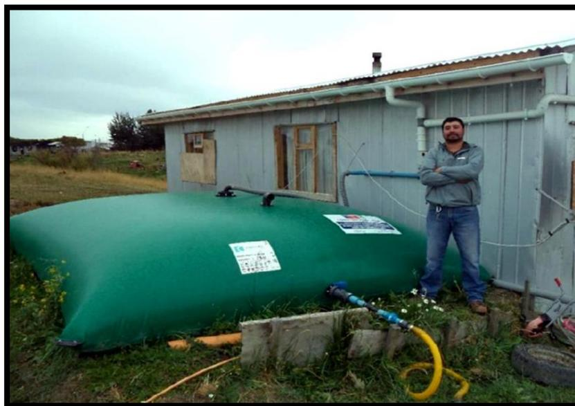
**FIGURA N° 5:** *Tanque de Almacenamiento de sistema flexible.*
