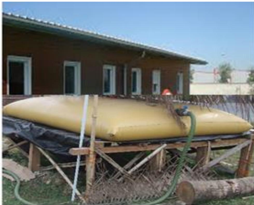
Figura 9: Tanque Flexible de Plástico en Vivienda Rural
