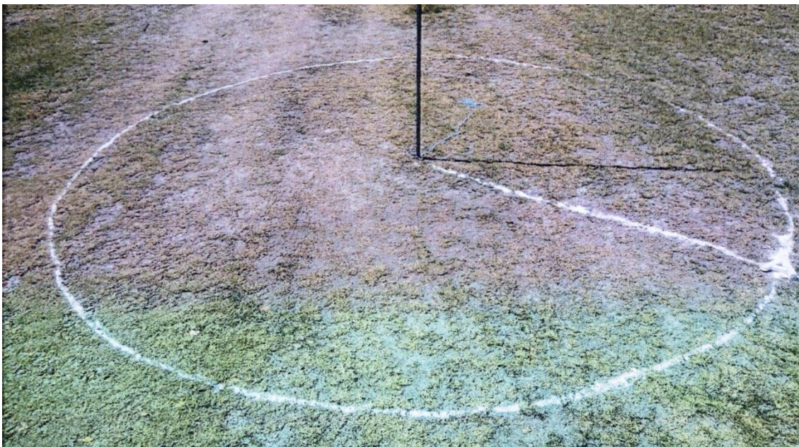
Figura 4.2. Trazado del círculo con el radio determinado por el punto A.
