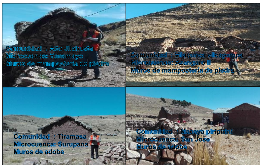
Figura 49. Material predominante en muros de viviendas del área rural Fuente: Elaborado por el equipo de trabajo
