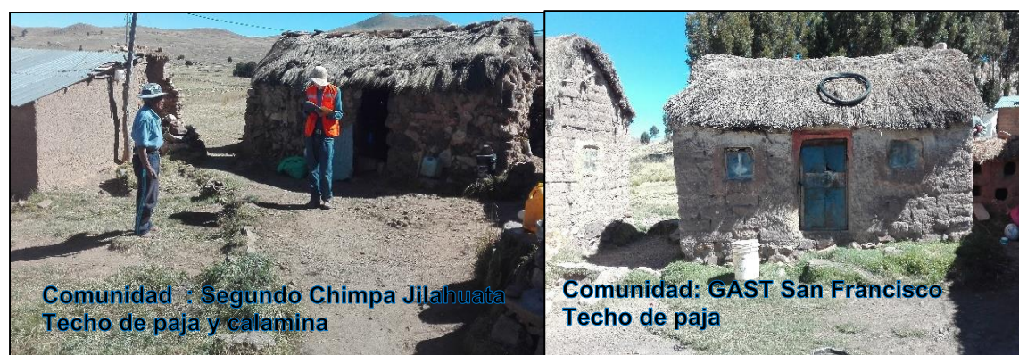
Figura 50. Material predominante en techos de viviendas del área rural Fuente: Elaborado por el equipo de trabajo
