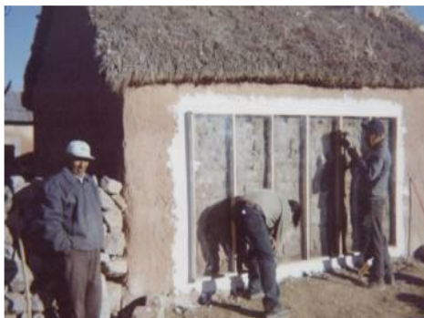
Figura 16. Sellado de aberturas de calentador solar
