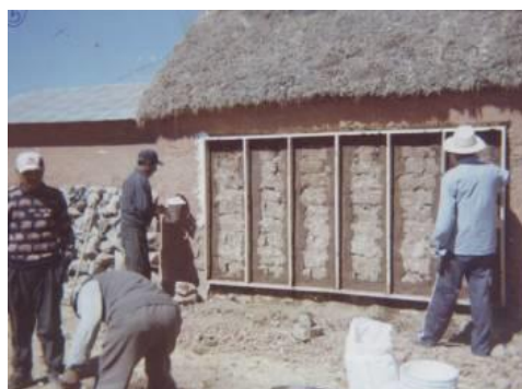
Figura 15. Colocación y fijación del calentador solar
