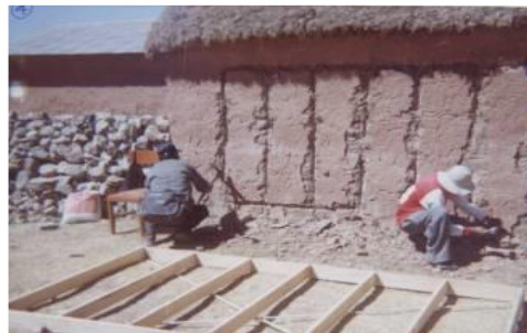
Figura 14. Trazo y colocación de calentador solar
