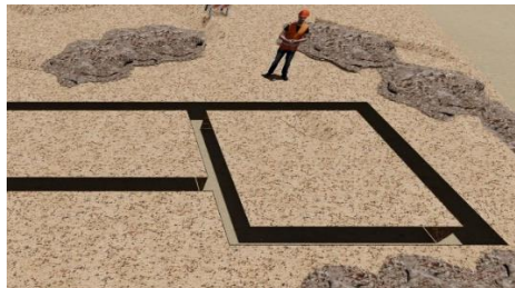
Figura 105. Excavación manual para cimiento corrido en vivienda de cinco personas Fuente: Elaborado por el equipo de trabajo
