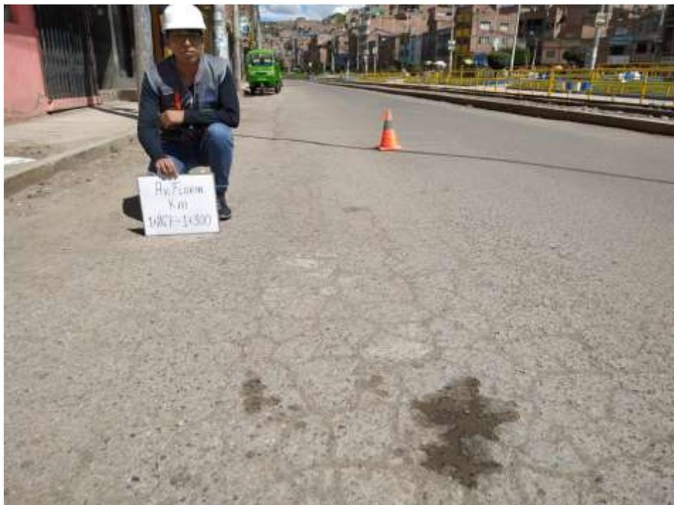
Fig. H.1 Falla Pulimiento de agregados en Pavimento Flexible.
