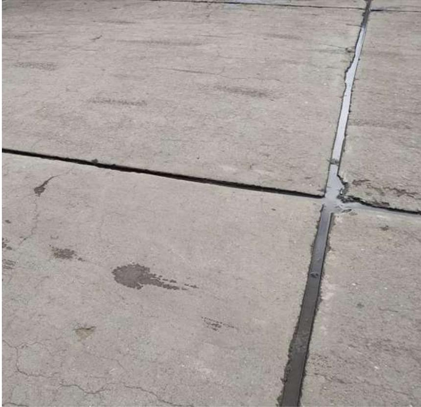
Fig. H.17 Falla Descascaramiento de esquina en Pavimento Rígido.
