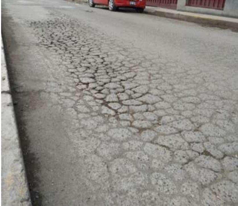
Fig. H.15 Falla Piel de Cocodrilo en Pavimento Flexible.
