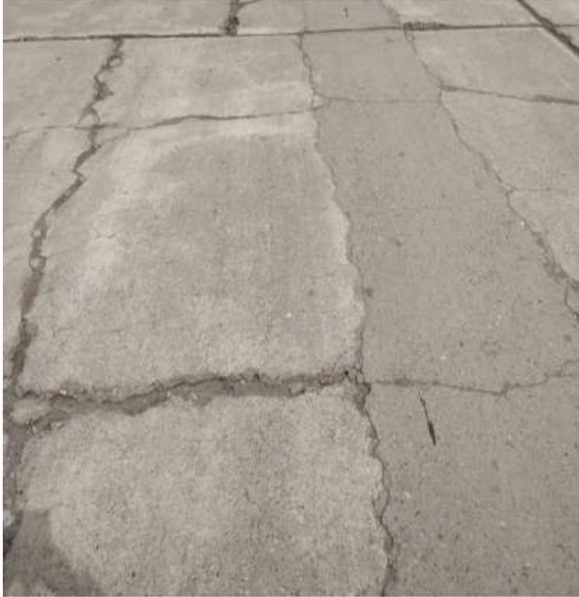
Fig. H.19 Falla Parcheo Grande en Pavimento Rígido.
