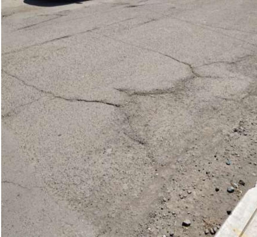
Fig. H.13 Falla Agrietamiento en Bloque en Pavimento Flexible.
