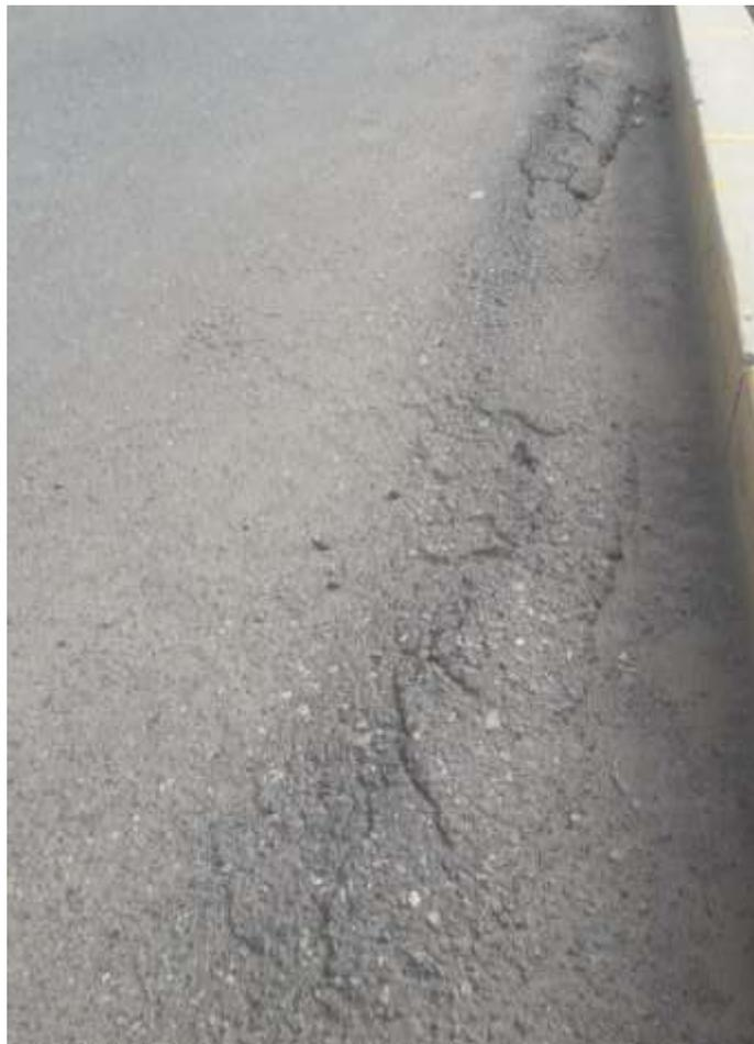
Fig. H.16 Falla Corrugación en Pavimento Flexible.
