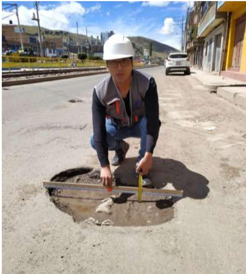
Fig. H.4 Falla Huevo en Pavimento Flexible.
