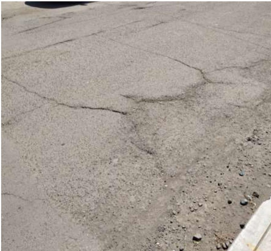
Fig. H.12 Falla Agrietamiento en Bloque en Pavimento Flexible.
