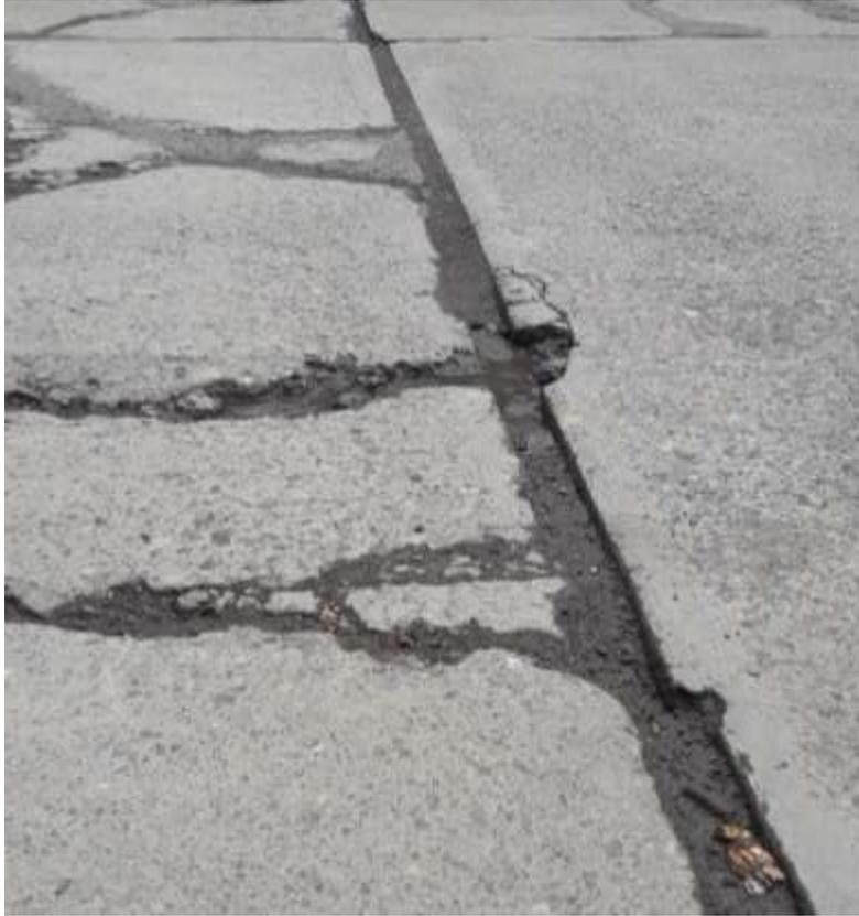
Fig. H.25 Falla Escala en Pavimento Rígido.
