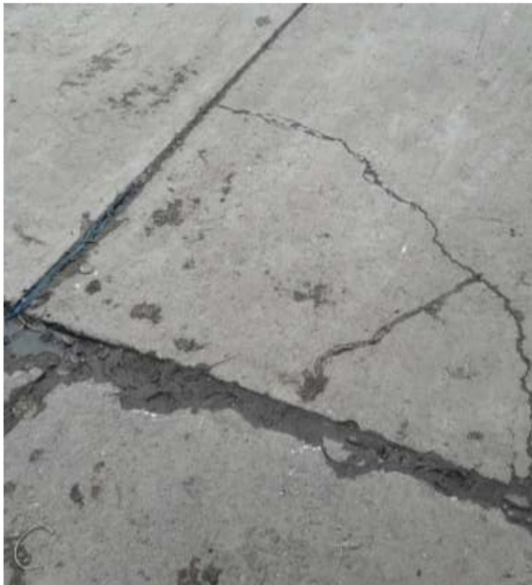
Fig. H.24 Falla Grieta de Esquina en Pavimento Rígido.
