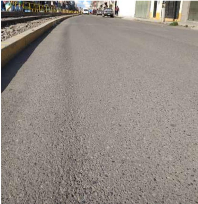
Fig. H.14 Falla Agrietamiento en Bloque en Pavimento Flexible.
