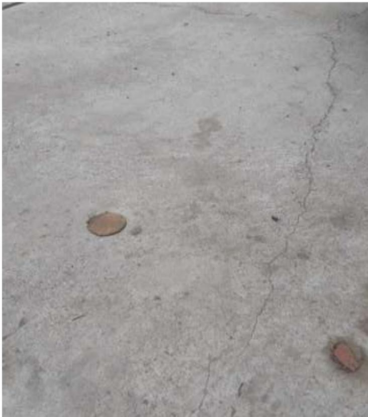
Fig. H.26 Falla Popouts en Pavimento Rígido.
