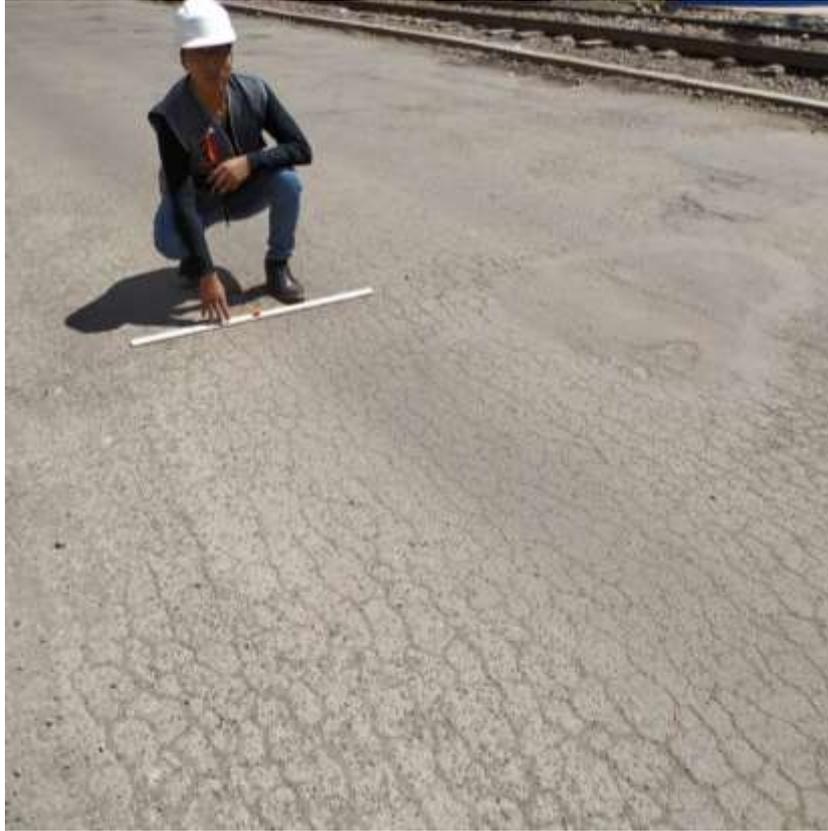
Fig. H.5 Falla Ahuellamiento y Piel de Cocodrilo en Pavimento Flexible.
