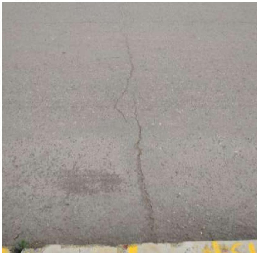
Fig. H.10 Falla Grieta Transversal en Pavimento Flexible.
