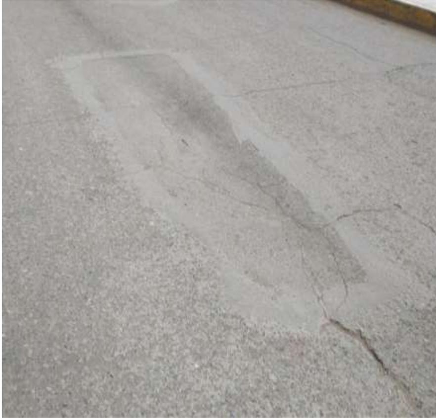
Fig. H.11 Falla Parcheo en Pavimento Flexible.
