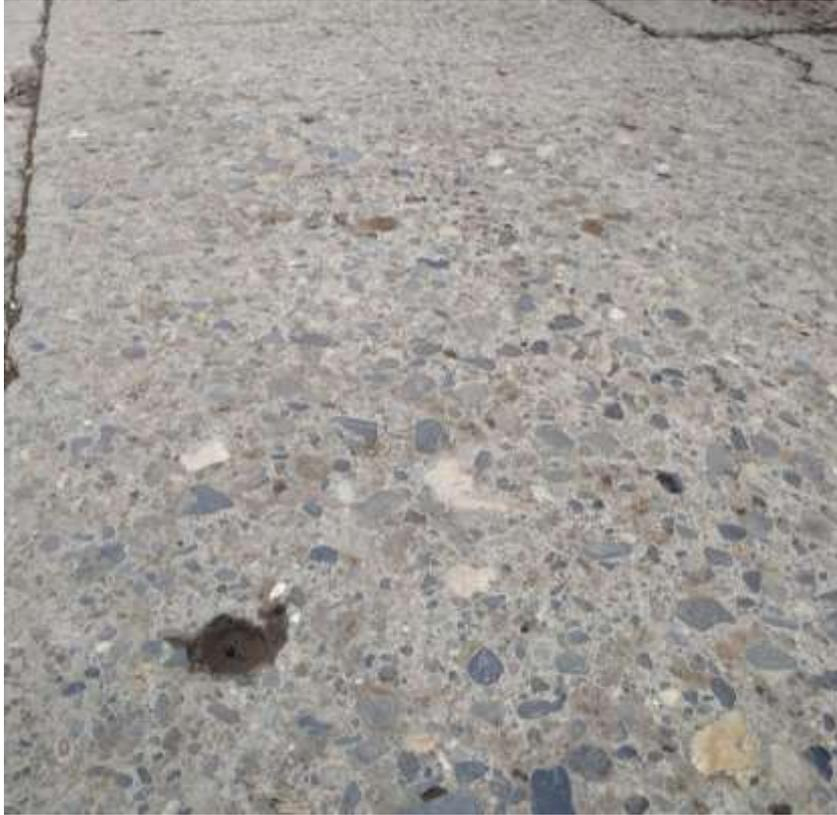
Fig. H.21 Falla Pulimientado de Agregados en Pavimento Rígido.
