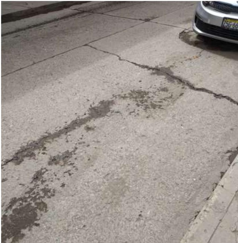
Fig. H.22 Falla Grieta Lineal en Pavimento Rígido.
