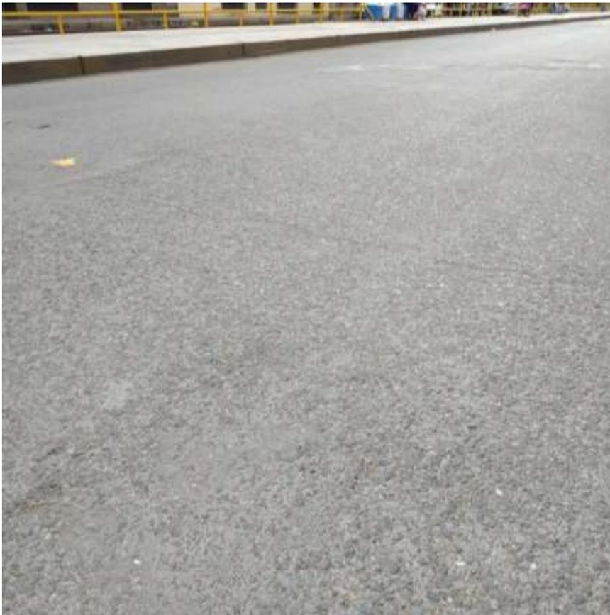
Fig. H.8 Falla Pulimiento de agregados en Pavimento Flexible.
