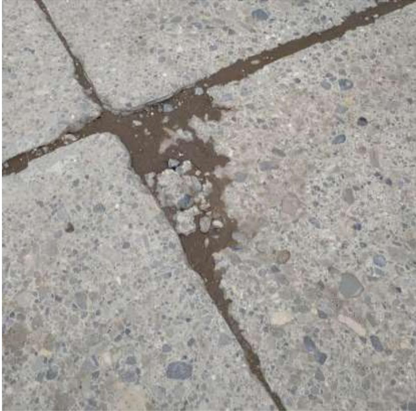
Fig. H.23 Falla Descascaramiento de Esquina en Pavimento Rígido.
