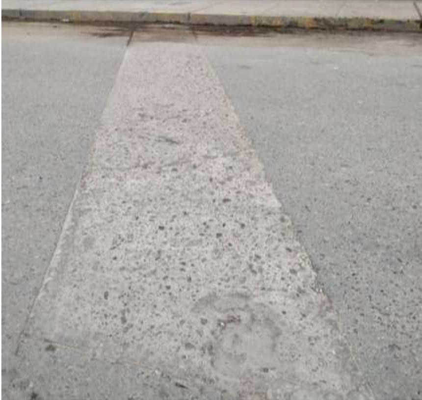
Fig. H.7 Falla Parcheo en Pavimento Flexible.
