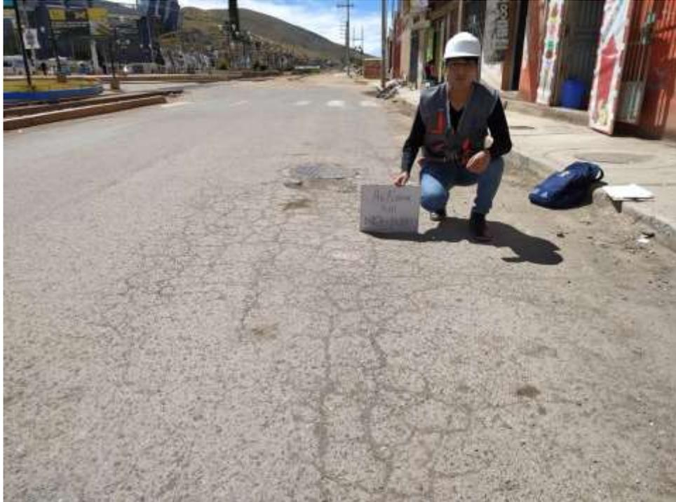
Fig. H.3 Falla Piel de Cocodrilo en Pavimento Flexible.
