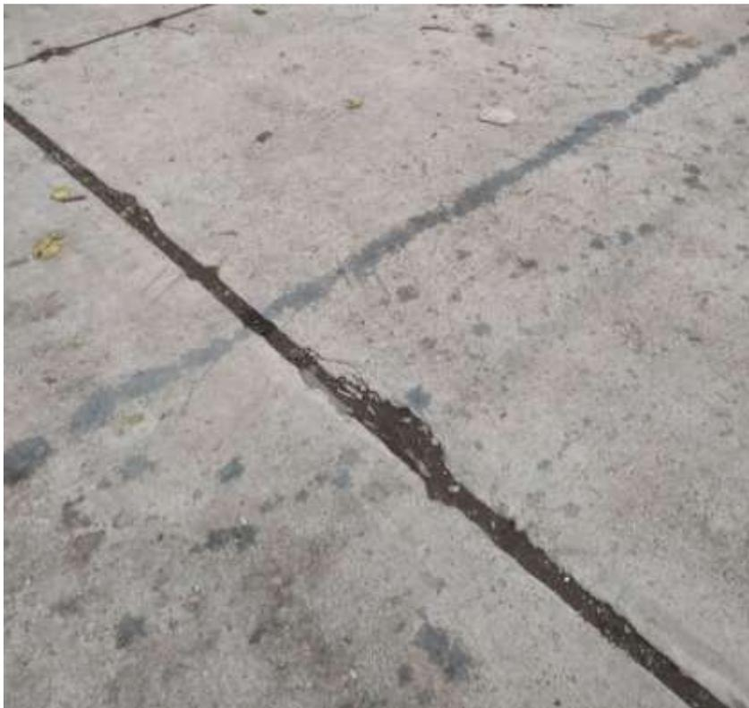
Fig. H.20 Falla Descascamiento de Junta en Pavimento Rígido.
