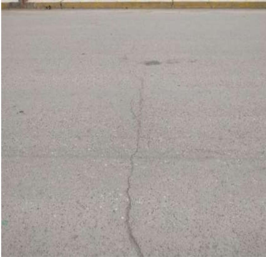
Fig. H.9 Falla Grieta Transversal en Pavimento Flexible.
