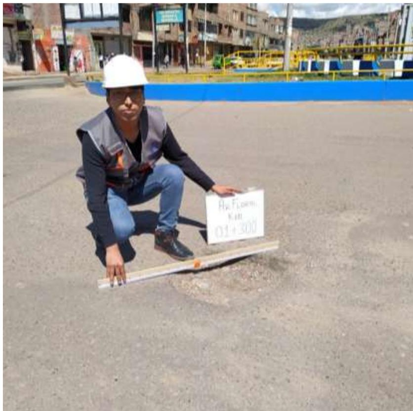
Fig. H.6 Falla Huevo en Pavimento Flexible.
