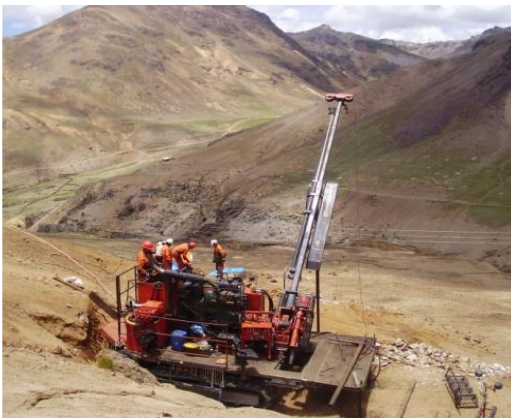
Figura N° 43: Instalación de equipo de Perforación diamantina en el Cerro Mamacocha.
