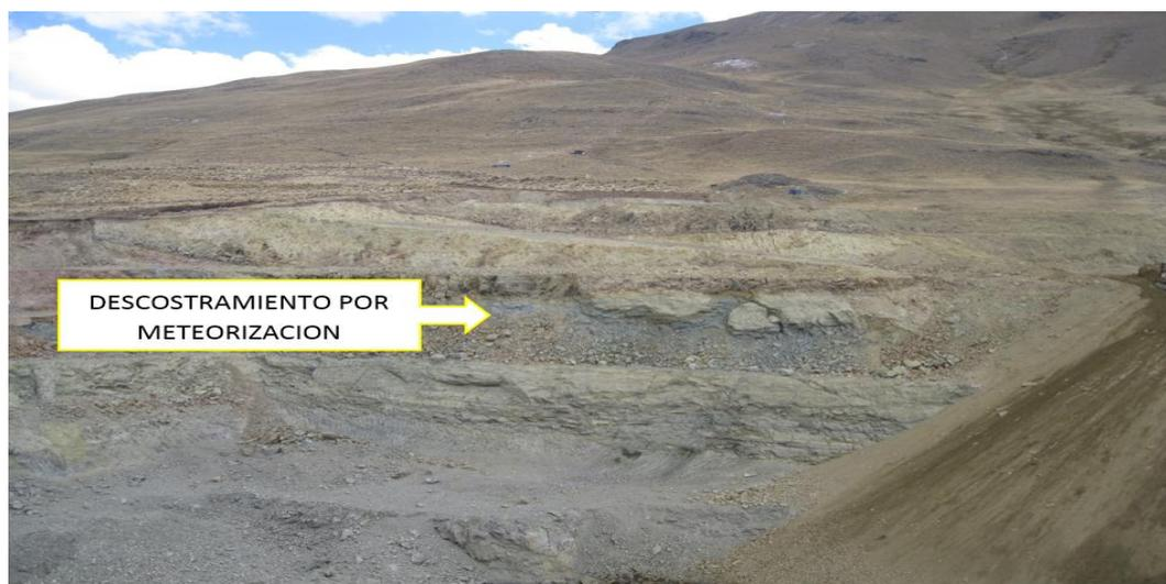
**Figura 75: Descostramiento por meteorización en banco de producción 4330S – 4325S**
