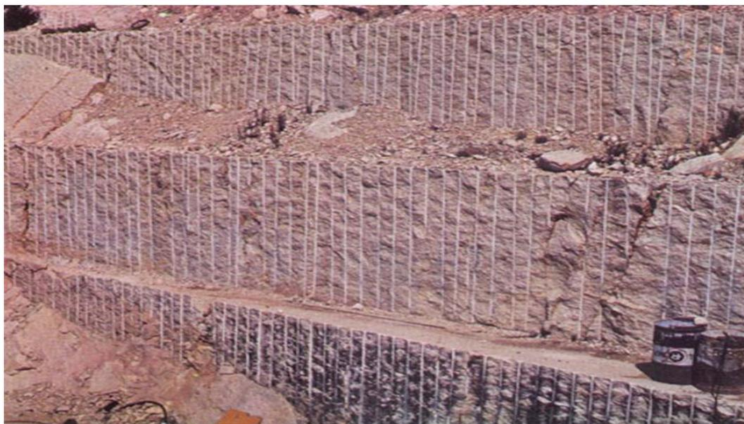
**Figura 6: Resultado de voladura controlada de contorno.**
