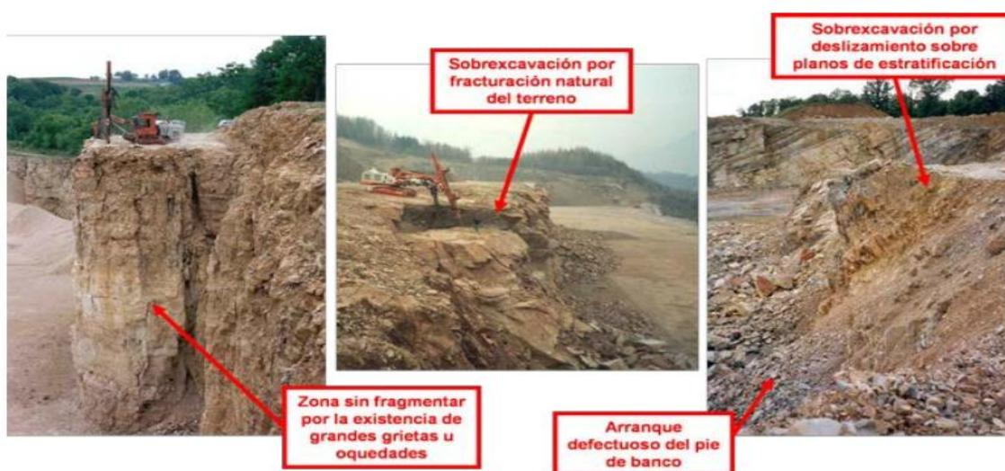
**Figura 8: Afecciones de las voladuras al macizo rocoso remanente.**
