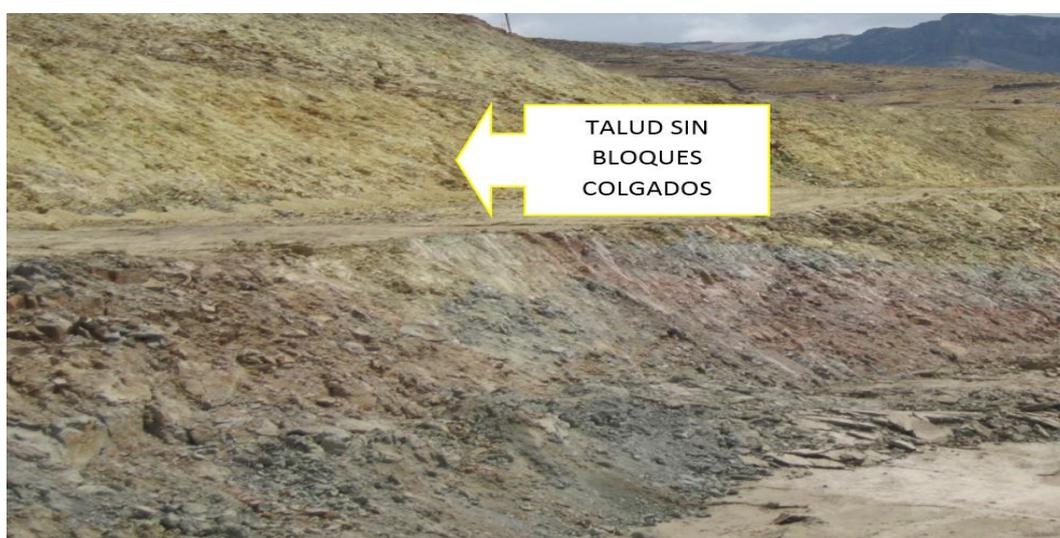
**Figura 98: Talud sin bloques colgados.**
