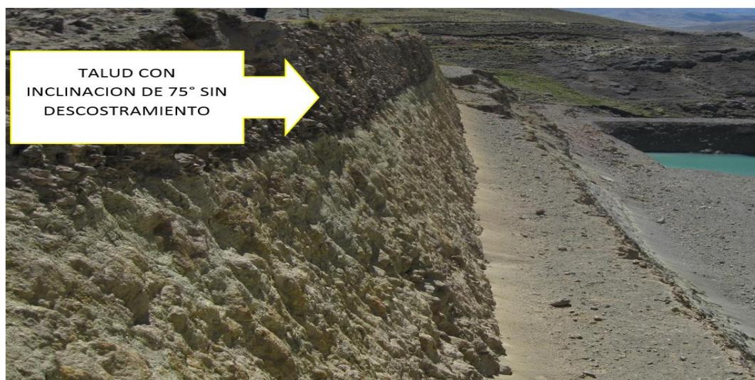
**Figura 99: Talud sin descostramiento.**
