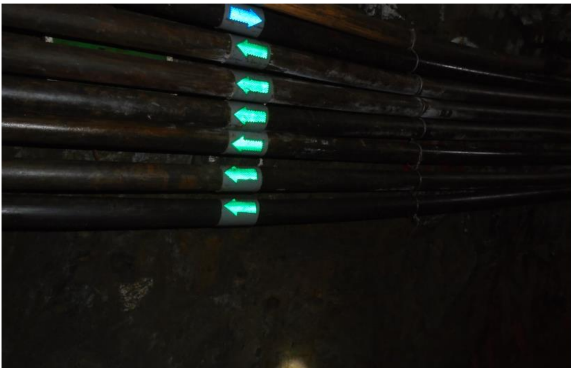
Fig. 3. Tuberías de descarga.
