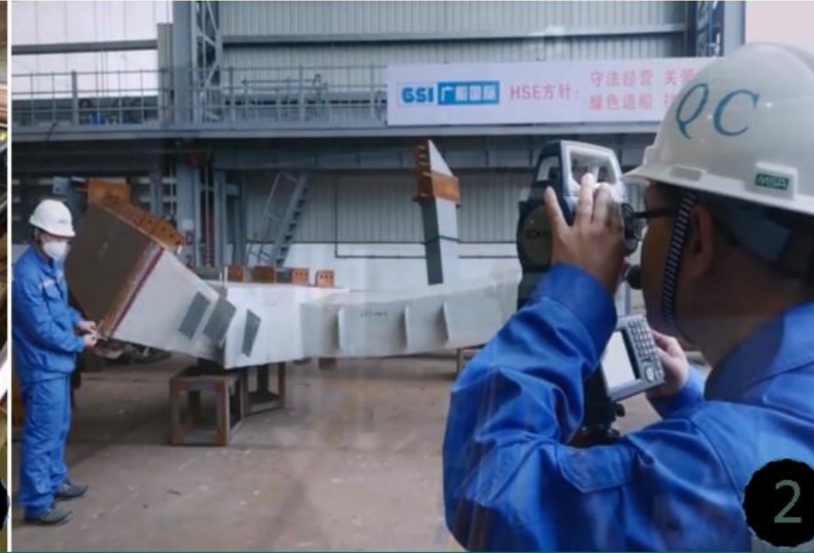
● CONTROL Y APROBACIÓN DE LOS PERFILES ANTES DE SER TRANSPORTADO E INSTALADOS
