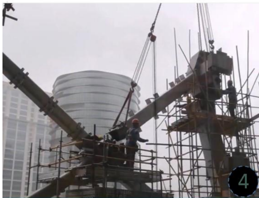
● MANIOBRA DE TRASLADO DEL PERFIL DE ACERO
