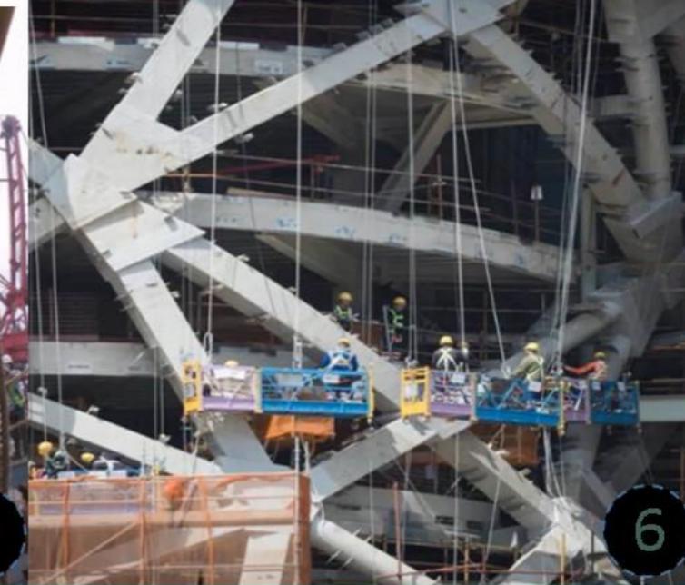
● INSTALACIÓN COMPLETA DEL EXOESQUELETO ESTRUCTURAL
