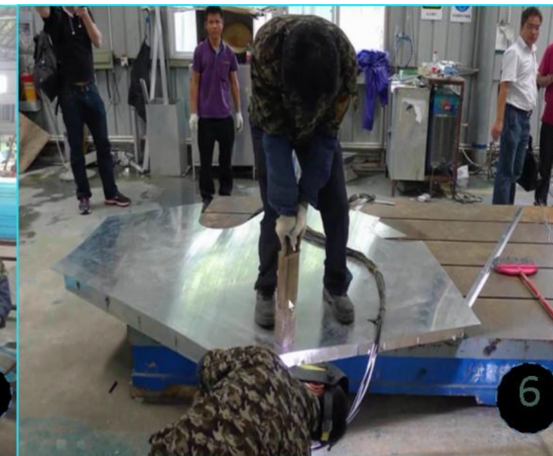
● SOLDADURA DEL MOLDE
