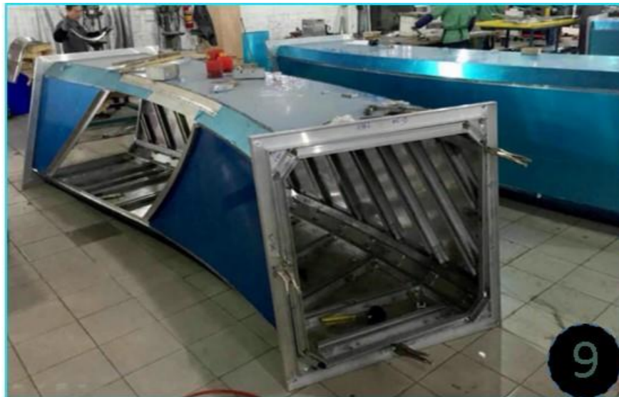
● PRE-MONTAJE EN FABRICA
