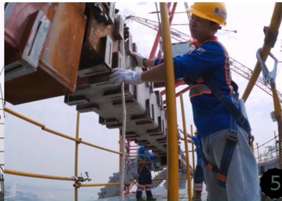
● COLOCACIÓN DEL PERFIL DE ACERO AL NODO CENTRAL
