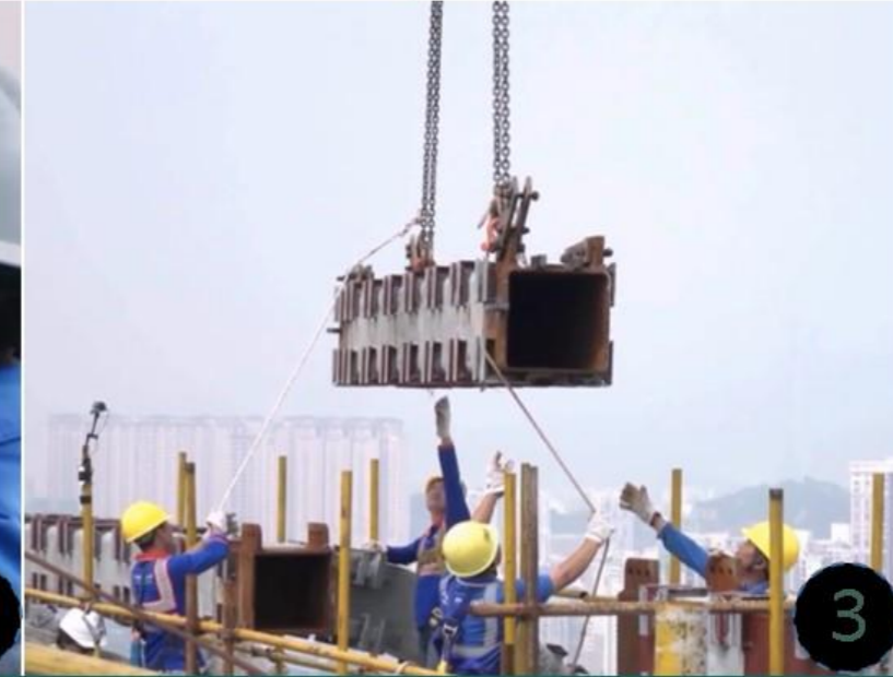
● INSTALACIÓN MEDIANTE GRUAS
