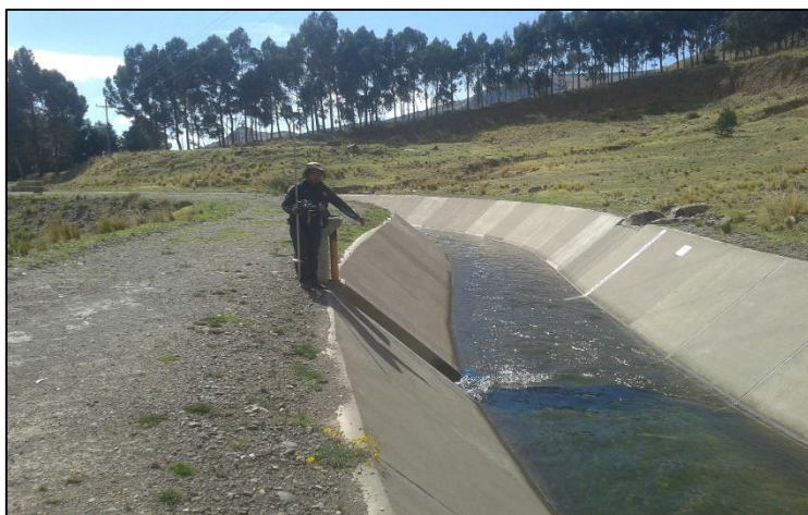
FIGURA 35:Canal de conducción
