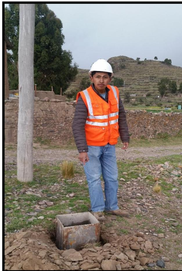
Figura 42: Encofrado y monumentación del punto geodésico EPITA-2.
