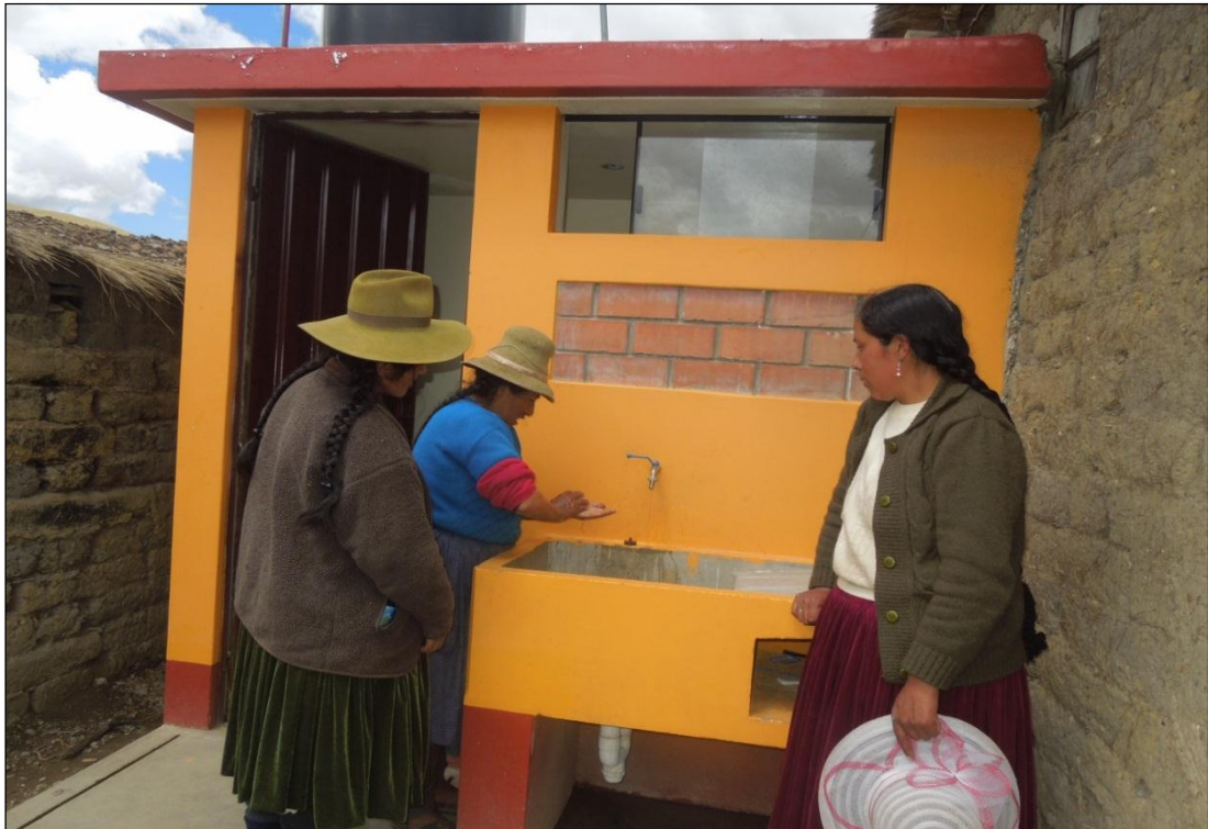
Foto 5. Instalación de agua a nivel domiciliario
