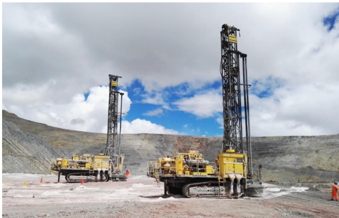
Figura 30. Equipos de perforación DML2 y DML3 en el Tajo Norte
