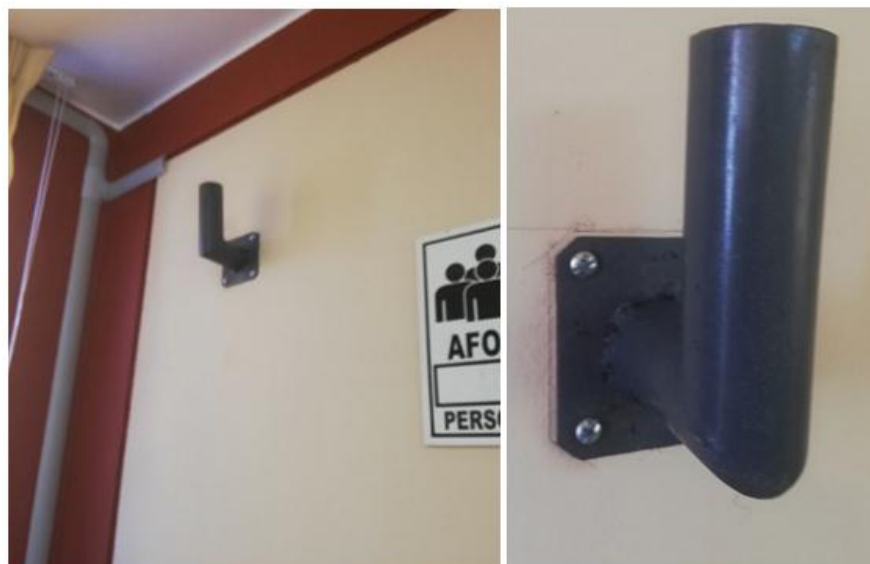
Figura 3 8 - Soporte empotrado en la pared
