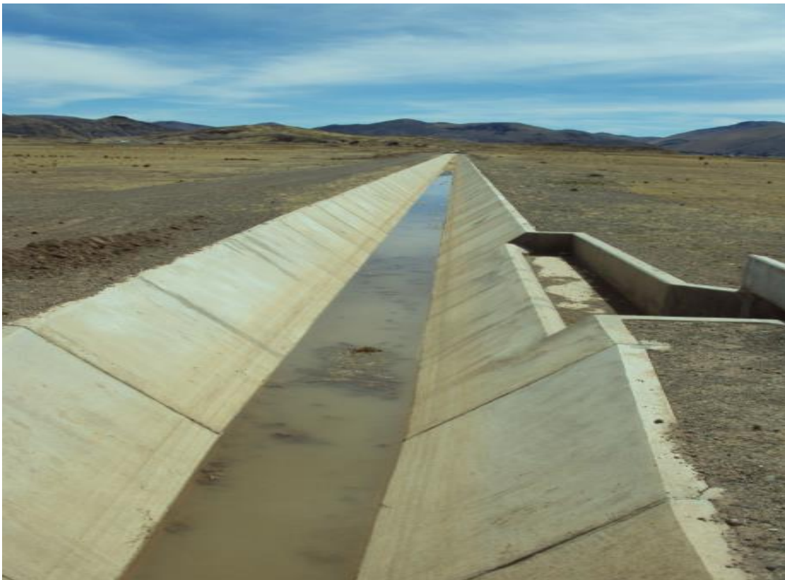
Figura 13. Sistema integral Lagunillas – modulo canal principal del distrito de Mañazo 2018
