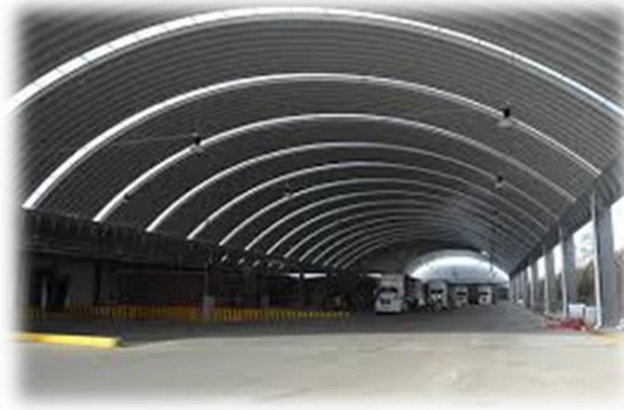
Figura 50: Sistema de techos autosoportantes
