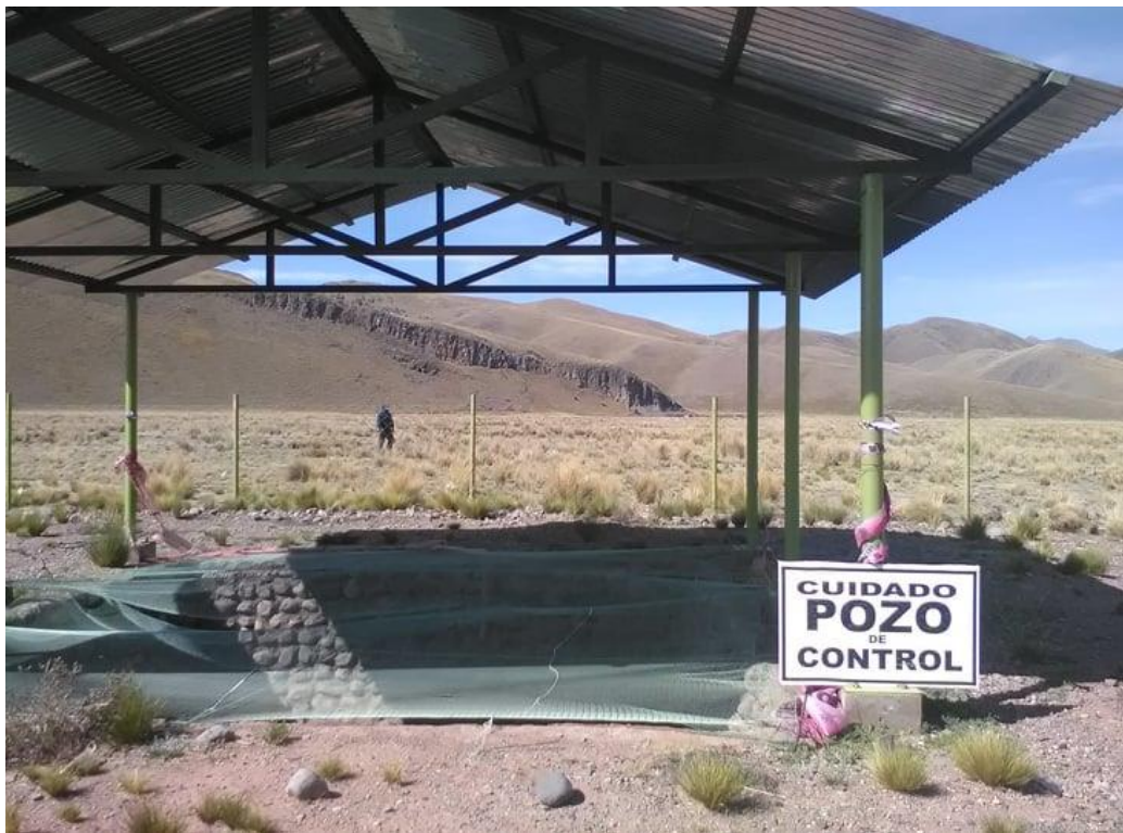
Estado Actual de la Poza de Lixiviación
