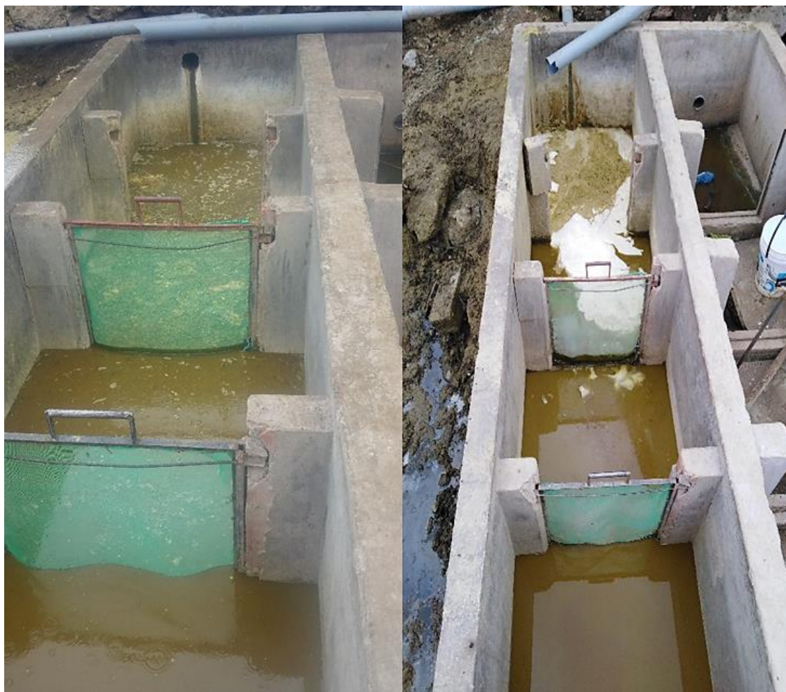
Figura 19. Operación del sistema de sedimentación del centro de beneficio animal Azoguini (noviembre 2018 a agosto 2019)
