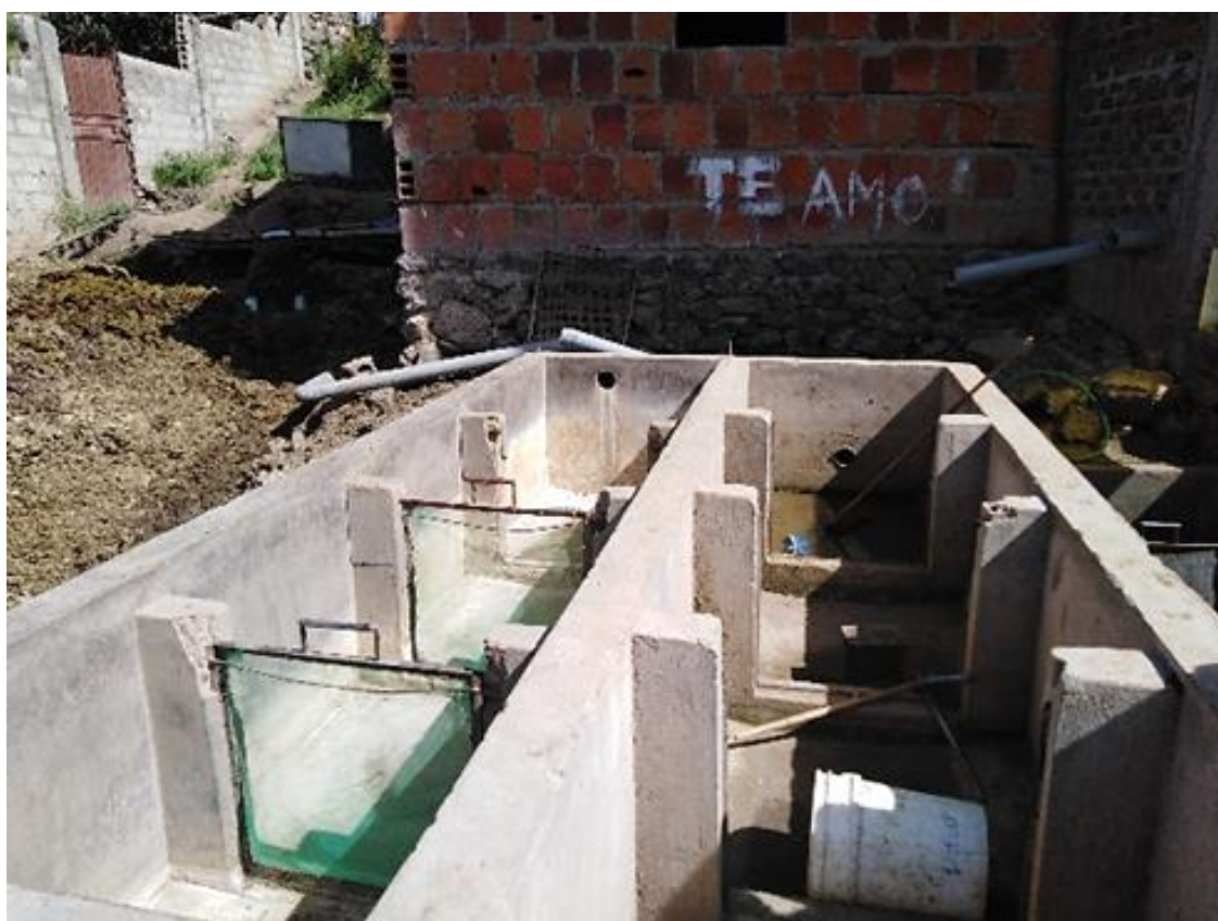
Figura 18. Preparación de poza de sedimentación Camal Azoguini, para la obtención de muestras de las aguas verdes del centro de beneficio animal Azoguini (noviembre 2018 a agosto 2019)
