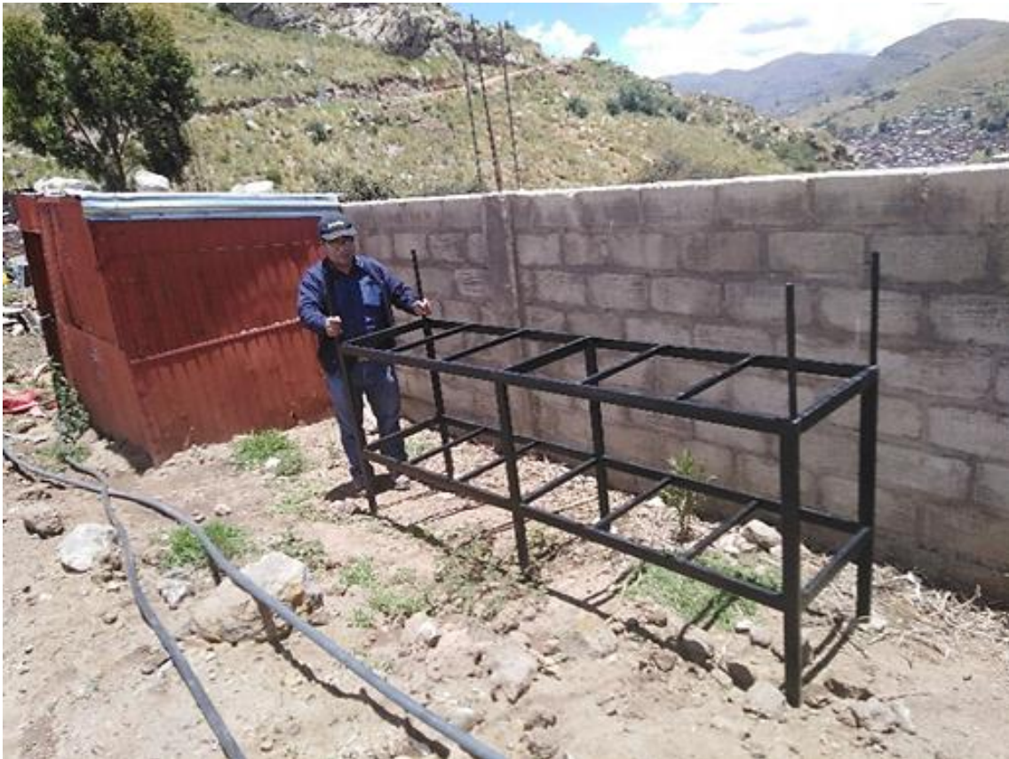
Figura 15. Proceso de instalación del sistema de tratamiento de aguas residuales verdes del centro de beneficio animal Azoguini (noviembre 2018 a agosto 2019)
