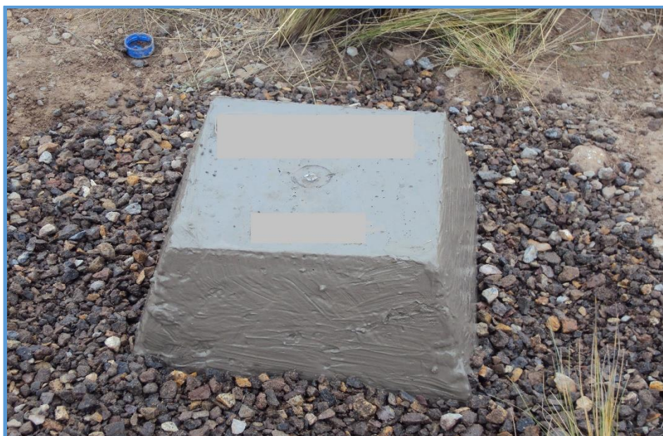
Figura XIII: Monumentación de los Puntos de control.
