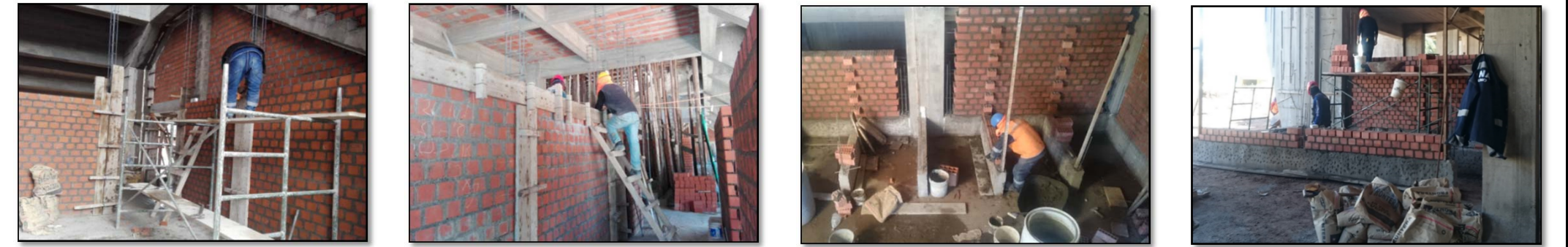
Fotografía 221. Seguimiento de partidas en obra (fuente propia) Fotografía 222. Seguimiento de partidas en obra (fuente propia) Fotografía 223. Seguimiento de partidas en obra (fuente propia) Fotografía 224. Seguimiento de partidas en obra (fuente propia)
