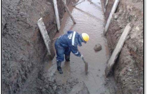
Fotografía 032. Seguimiento de partidas en obra (fuente propia)
