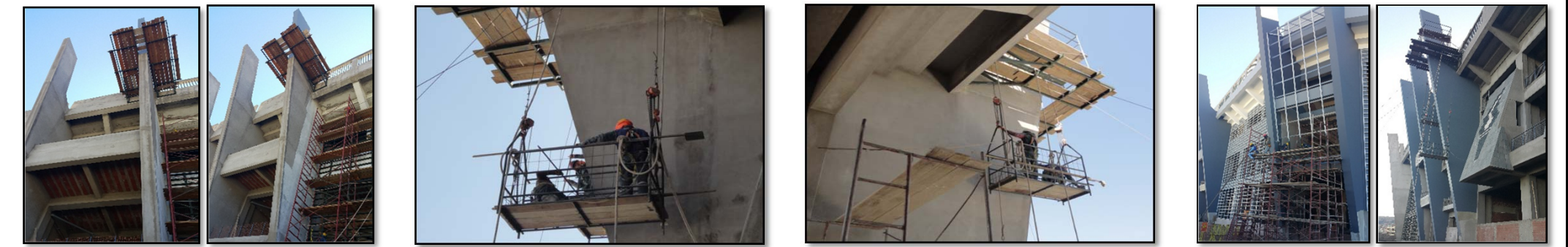
Fotografía 325. Seguimiento de partidas en obra (fuente propia) Fotografía 326. Seguimiento de partidas en obra (fuente propia) Fotografía 327. Seguimiento de partidas en obra (fuente propia) Fotografía 328. Seguimiento de partidas en obra (fuente propia)
