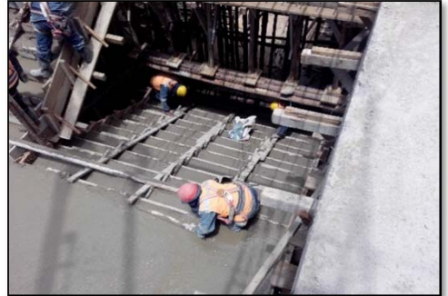
Fotografía 154. Seguimiento de partidas en obra (fuente propia)
