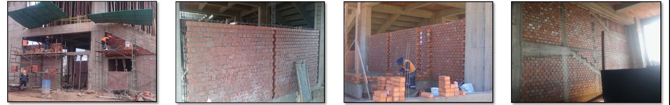
Fotografía 225. Seguimiento de partidas en obra (fuente propia) Fotografía 226. Seguimiento de partidas en obra (fuente propia) Fotografía 227. Seguimiento de partidas en obra (fuente propia) Fotografía 228. Seguimiento de partidas en obra (fuente propia)
