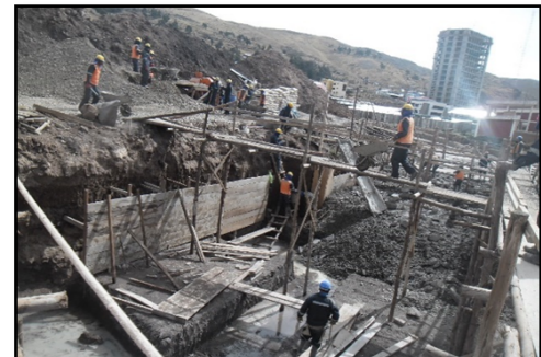
Fotografía 076. Seguimiento de partidas en obra (fuente propia)
