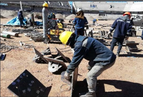
Fotografía 176. Seguimiento de partidas en obra (fuente propia)
