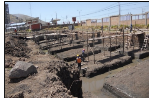
Fotografía 073. Seguimiento de partidas en obra (fuente propia)
