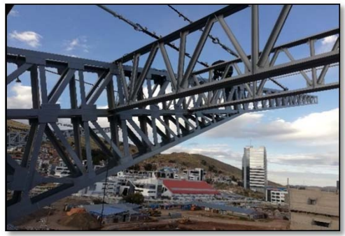
Fotografía 186. Seguimiento de partidas en obra (fuente propia)
