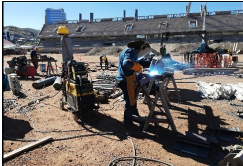
Fotografía 175. Seguimiento de partidas en obra (fuente propia)
