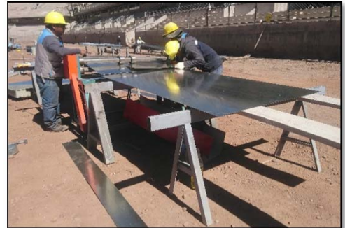
Fotografía 198. Seguimiento de partidas en obra (fuente propia)
