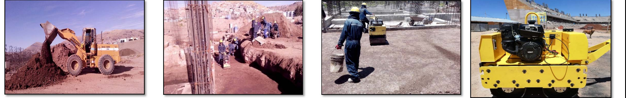
Fotografía 041. Seguimiento de partidas en obra (fuente propia) Fotografía 042. Seguimiento de partidas en obra (fuente propia) Fotografía 043. Seguimiento de partidas en obra (fuente propia) Fotografía 044. Seguimiento de partidas en obra (fuente propia)
