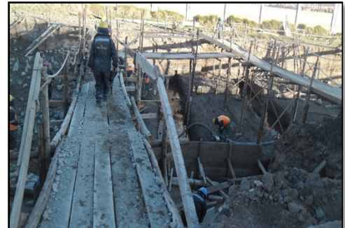
Fotografía 001. Seguimiento de partidas en obra (fuente propia)
