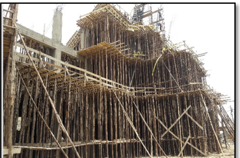
Fotografía 027. Seguimiento de partidas en obra (fuente propia)
