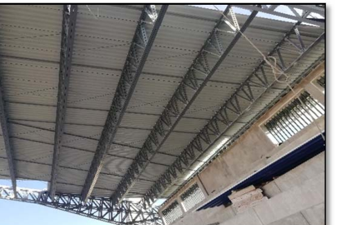
Fotografía 196. Seguimiento de partidas en obra (fuente propia)
