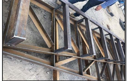
Fotografía 166. Seguimiento de partidas en obra (fuente propia)
