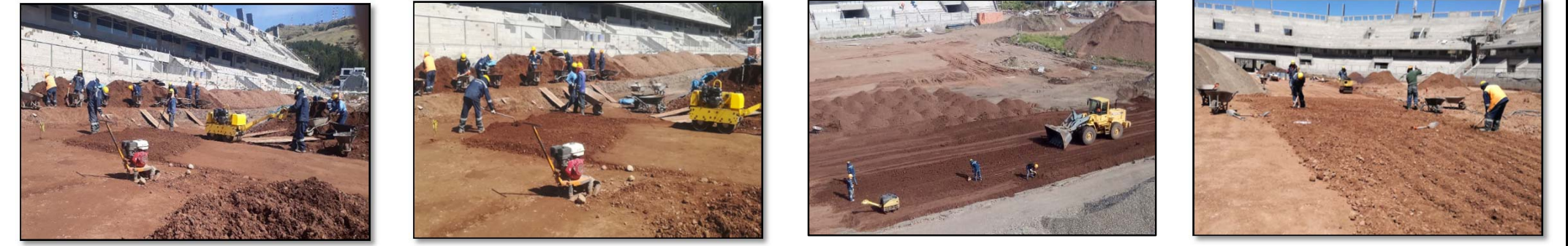
Fotografía 333. Seguimiento de partidas en obra (fuente propia) Fotografía 334. Seguimiento de partidas en obra (fuente propia) Fotografía 335. Seguimiento de partidas en obra (fuente propia) Fotografía 336. Seguimiento de partidas en obra (fuente propia)
