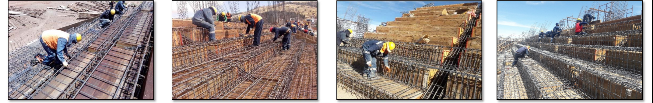
Fotografía 141. Seguimiento de partidas en obra (fuente propia) Fotografía 142. Seguimiento de partidas en obra (fuente propia) Fotografía 143. Seguimiento de partidas en obra (fuente propia) Fotografía 144. Seguimiento de partidas en obra (fuente propia)
