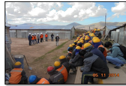
Fotografía 034. Seguimiento de partidas en obra (fuente propia)
