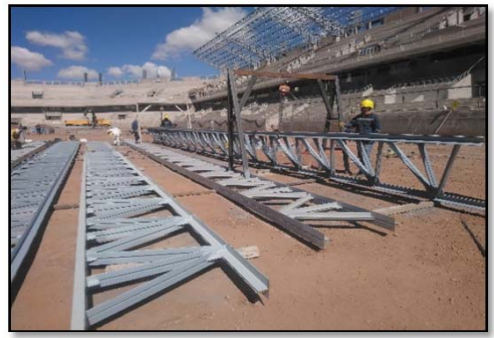
Fotografía 183. Seguimiento de partidas en obra (fuente propia)
