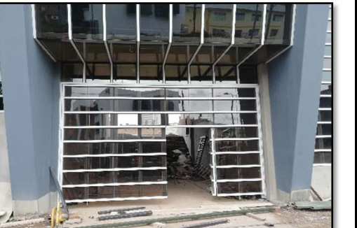
Fotografía 312. Seguimiento de partidas en obra (fuente propia)
