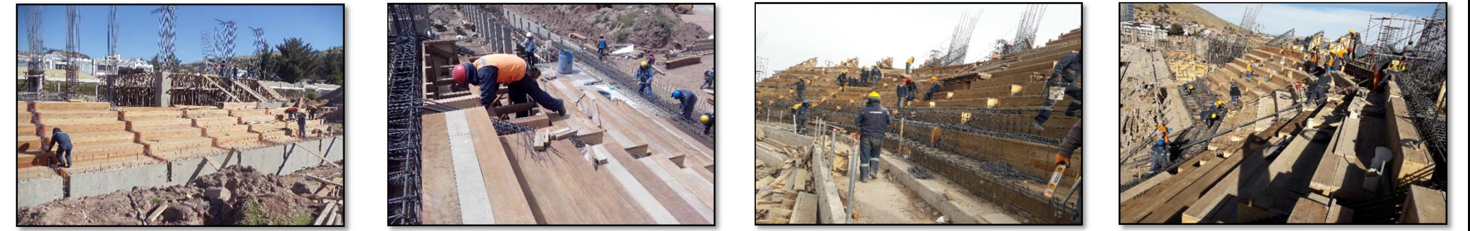
Fotografía 137. Seguimiento de partidas en obra (fuente propia) Fotografía 138. Seguimiento de partidas en obra (fuente propia) Fotografía 139. Seguimiento de partidas en obra (fuente propia) Fotografía 140. Seguimiento de partidas en obra (fuente propia)
