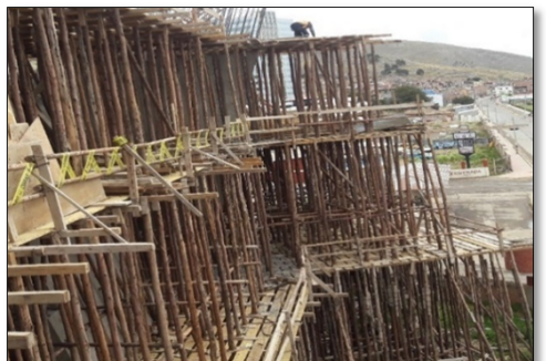
Fotografía 026. Seguimiento de partidas en obra (fuente propia)
