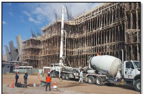
Fotografía 028. Seguimiento de partidas en obra (fuente propia)
