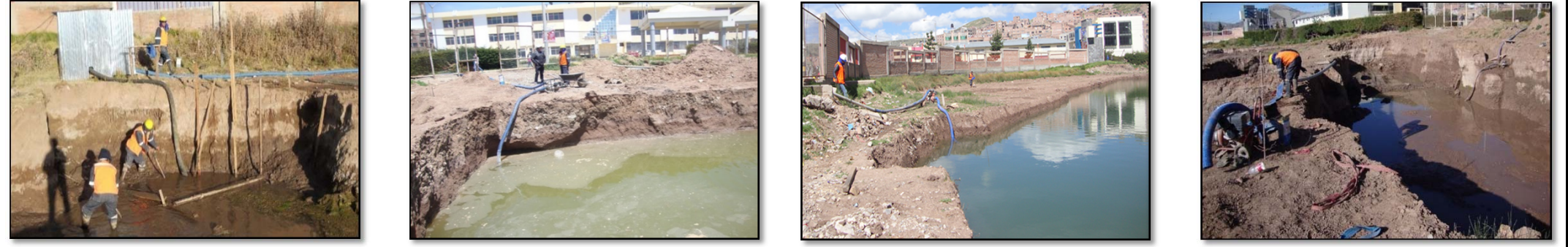
Fotografía 061. Seguimiento de partidas en obra (fuente propia) Fotografía 062. Seguimiento de partidas en obra (fuente propia) Fotografía 063. Seguimiento de partidas en obra (fuente propia) Fotografía 064. Seguimiento de partidas en obra (fuente propia)
