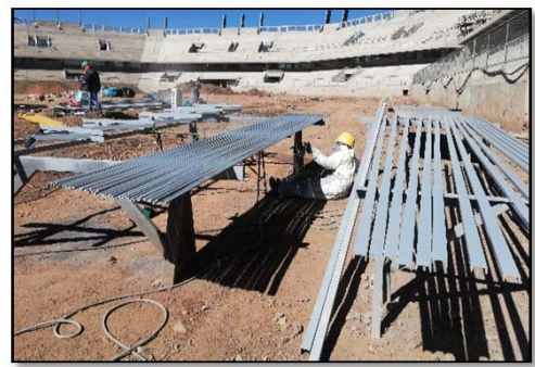
Fotografía 205. Seguimiento de partidas en obra (fuente propia)
