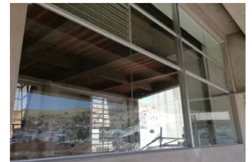
Fotografía 310. Seguimiento de partidas en obra (fuente propia)
