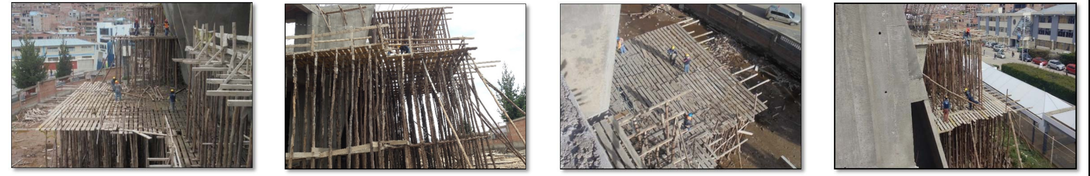
Fotografía 013. Seguimiento de partidas en obra (fuente propia) Fotografía 014. Seguimiento de partidas en obra (fuente propia) Fotografía 015. Seguimiento de partidas en obra (fuente propia) Fotografía 016. Seguimiento de partidas en obra (fuente propia)
