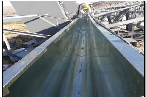
Fotografía 199. Seguimiento de partidas en obra (fuente propia)
