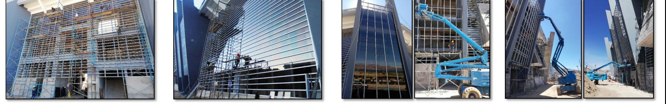
Fotografía 305. Seguimiento de partidas en obra (fuente propia) Fotografía 306. Seguimiento de partidas en obra (fuente propia) Fotografía 307. Seguimiento de partidas en obra (fuente propia) Fotografía 308. Seguimiento de partidas en obra (fuente propia)
