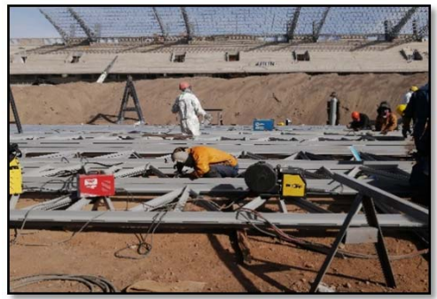
Fotografía 182. Seguimiento de partidas en obra (fuente propia)
