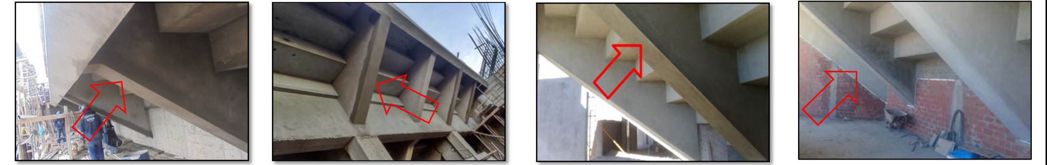
Fotografía 253. Seguimiento de partidas en obra (fuente propia) Fotografía 254. Seguimiento de partidas en obra (fuente propia) Fotografía 255. Seguimiento de partidas en obra (fuente propia) Fotografía 256. Seguimiento de partidas en obra (fuente propia)
