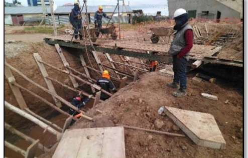
Fotografía 031. Seguimiento de partidas en obra (fuente propia)
