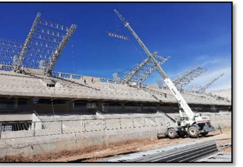
Fotografía 188. Seguimiento de partidas en obra (fuente propia)
