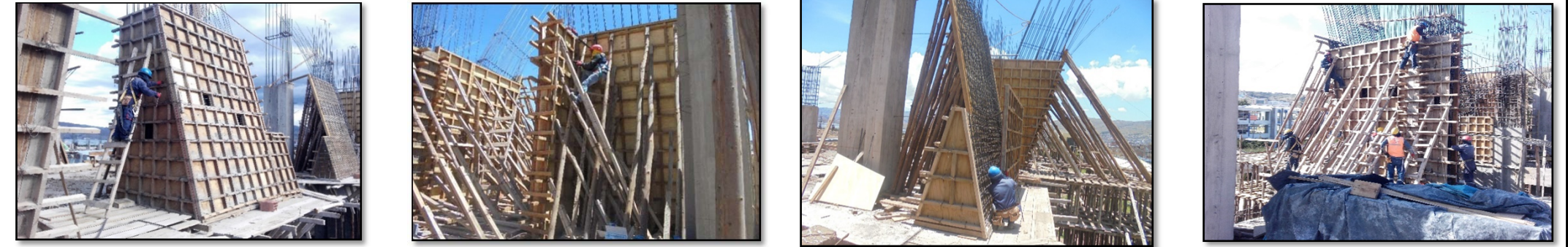
Fotografía 093. Seguimiento de partidas en obra (fuente propia) Fotografía 094. Seguimiento de partidas en obra (fuente propia) Fotografía 095. Seguimiento de partidas en obra (fuente propia) Fotografía 096. Seguimiento de partidas en obra (fuente propia)
