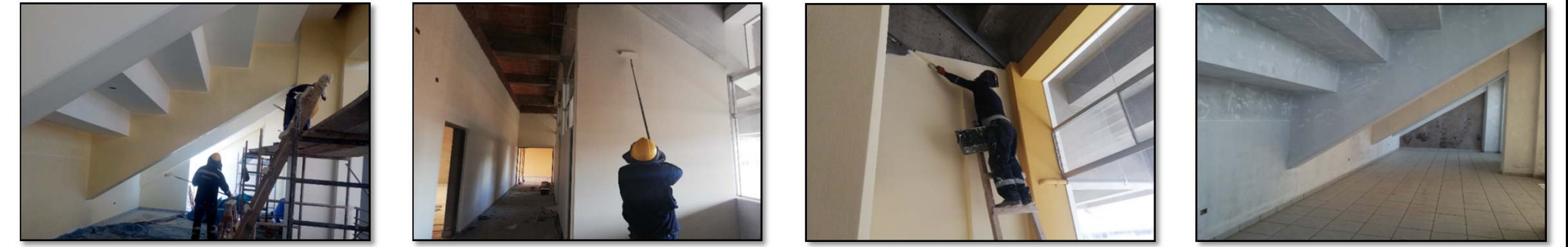
Fotografía 321. Seguimiento de partidas en obra (fuente propia) Fotografía 322. Seguimiento de partidas en obra (fuente propia) Fotografía 323. Seguimiento de partidas en obra (fuente propia) Fotografía 324. Seguimiento de partidas en obra (fuente propia)
