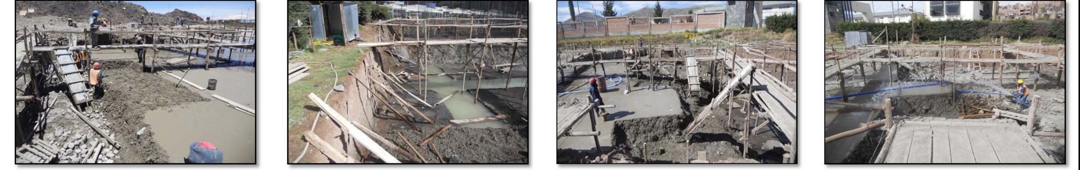
Fotografía 077. Seguimiento de partidas en obra (fuente propia) Fotografía 078. Seguimiento de partidas en obra (fuente propia) Fotografía 079. Seguimiento de partidas en obra (fuente propia) Fotografía 080. Seguimiento de partidas en obra (fuente propia)
