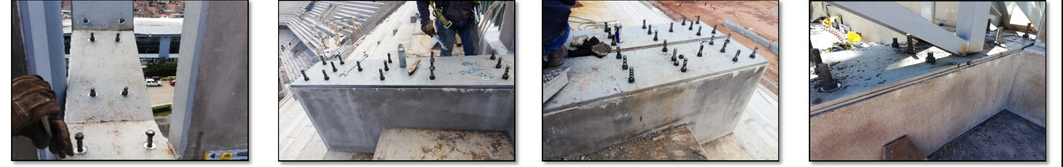
Fotografía 177. Seguimiento de partidas en obra (fuente propia) Fotografía 178. Seguimiento de partidas en obra (fuente propia) Fotografía 179. Seguimiento de partidas en obra (fuente propia) Fotografía 180. Seguimiento de partidas en obra (fuente propia)
