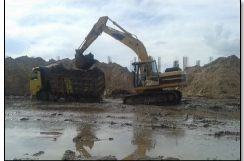
Fotografía 046. Seguimiento de partidas en obra (fuente propia)
