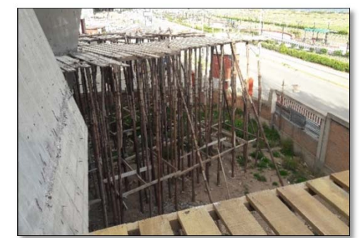
Fotografía 012. Seguimiento de partidas en obra (fuente propia)
