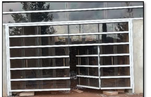
Fotografía 311. Seguimiento de partidas en obra (fuente propia)
