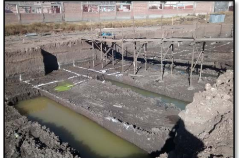
Fotografía 003. Seguimiento de partidas en obra (fuente propia)
