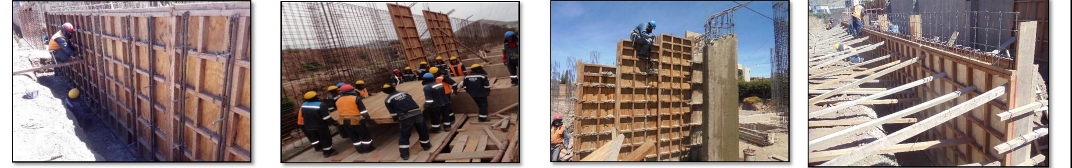
Fotografía 085. Seguimiento de partidas en obra (fuente propia) Fotografía 086. Seguimiento de partidas en obra (fuente propia) Fotografía 087. Seguimiento de partidas en obra (fuente propia) Fotografía 088. Seguimiento de partidas en obra (fuente propia)
