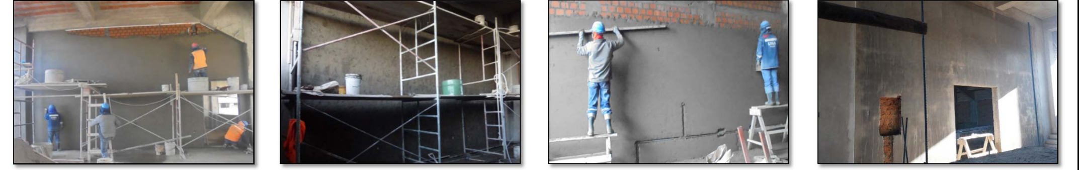
Fotografía 229. Seguimiento de partidas en obra (fuente propia) Fotografía 230. Seguimiento de partidas en obra (fuente propia) Fotografía 231. Seguimiento de partidas en obra (fuente propia) Fotografía 232. Seguimiento de partidas en obra (fuente propia)
