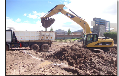
Fotografía 045. Seguimiento de partidas en obra (fuente propia)
