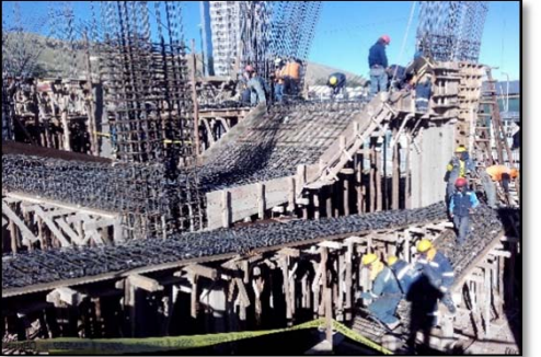
Fotografía 163. Seguimiento de partidas en obra (fuente propia)
