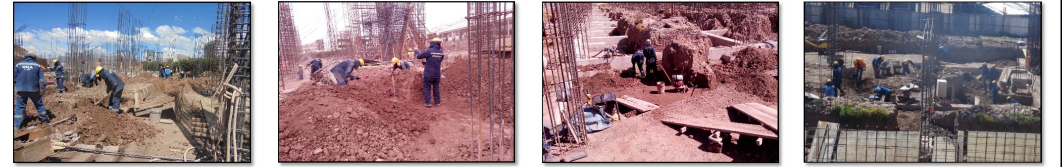
Fotografía 213. Seguimiento de partidas en obra (fuente propia) Fotografía 214. Seguimiento de partidas en obra (fuente propia) Fotografía 215. Seguimiento de partidas en obra (fuente propia) Fotografía 216. Seguimiento de partidas en obra (fuente propia)
