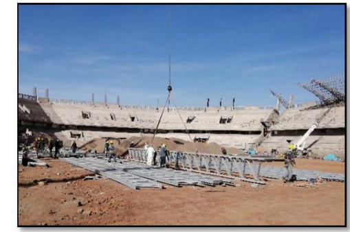
Fotografía 185. Seguimiento de partidas en obra (fuente propia)
