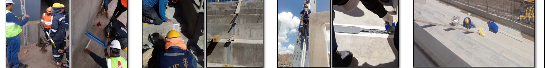
Fotografía 257. Seguimiento de partidas en obra (fuente propia) Fotografía 258. Seguimiento de partidas en obra (fuente propia) Fotografía 259. Seguimiento de partidas en obra (fuente propia) Fotografía 260. Seguimiento de partidas en obra (fuente propia)
