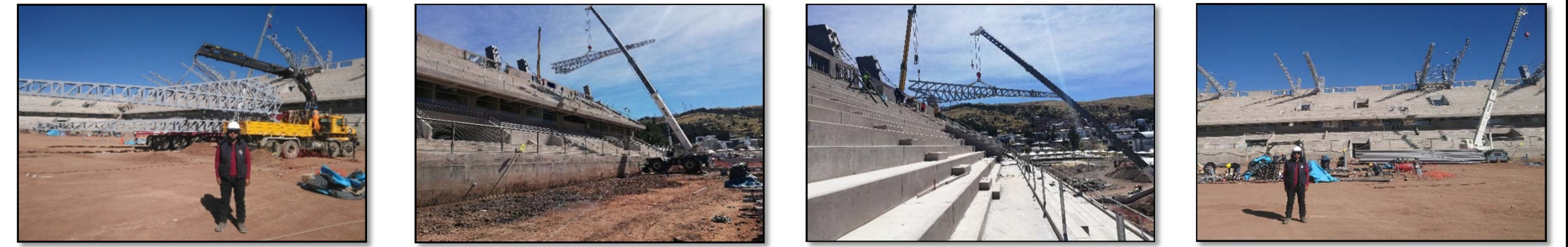
Fotografía 169. Seguimiento de partidas en obra (fuente propia) Fotografía 170. Seguimiento de partidas en obra (fuente propia) Fotografía 171. Seguimiento de partidas en obra (fuente propia) Fotografía 172. Seguimiento de partidas en obra (fuente propia)
