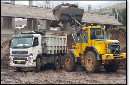
Fotografía 048. Seguimiento de partidas en obra (fuente propia)
