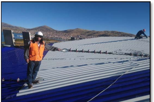
Fotografía 194. Seguimiento de partidas en obra (fuente propia)
