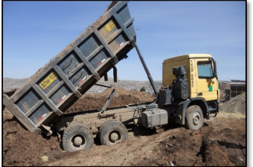
Fotografía 047. Seguimiento de partidas en obra (fuente propia)
