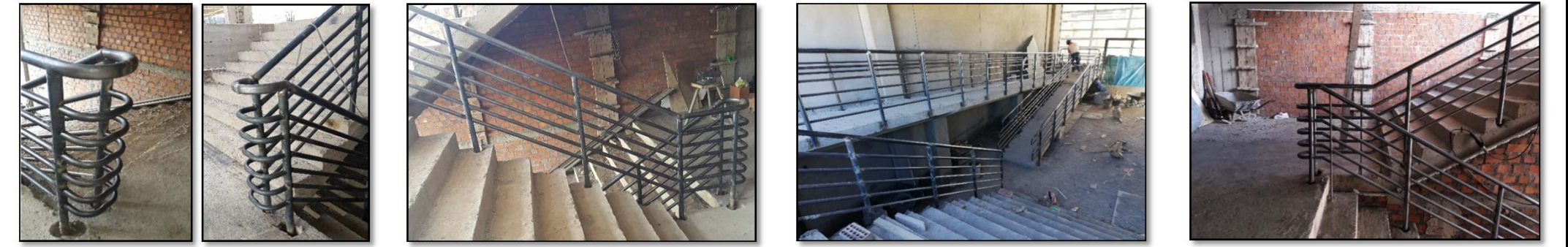
Fotografía 293. Seguimiento de partidas en obra (fuente propia) Fotografía 294. Seguimiento de partidas en obra (fuente propia) Fotografía 295. Seguimiento de partidas en obra (fuente propia) Fotografía 296. Seguimiento de partidas en obra (fuente propia)
