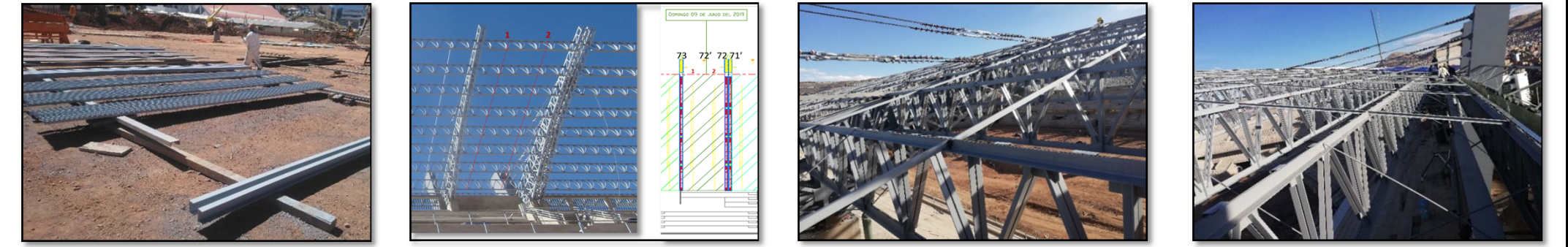
Fotografía 189. Seguimiento de partidas en obra (fuente propia) Fotografía 190. Seguimiento de partidas en obra (fuente propia) Fotografía 191. Seguimiento de partidas en obra (fuente propia) Fotografía 192. Seguimiento de partidas en obra (fuente propia)
