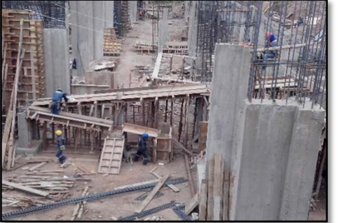
Fotografía 162. Seguimiento de partidas en obra (fuente propia)
