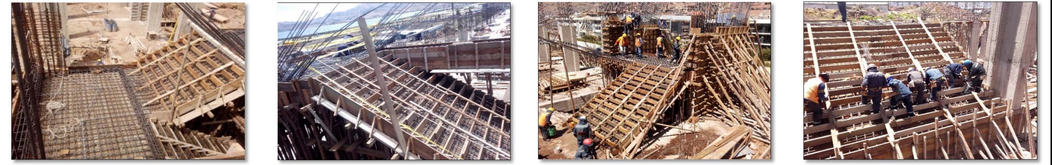
Fotografía 145. Seguimiento de partidas en obra (fuente propia) Fotografía 146. Seguimiento de partidas en obra (fuente propia) Fotografía 147. Seguimiento de partidas en obra (fuente propia) Fotografía 148. Seguimiento de partidas en obra (fuente propia)
