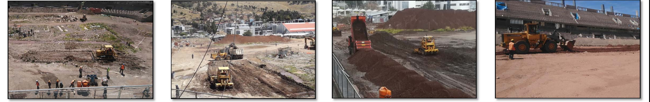
Fotografía 337. Seguimiento de partidas en obra (fuente propia) Fotografía 338. Seguimiento de partidas en obra (fuente propia) Fotografía 339. Seguimiento de partidas en obra (fuente propia) Fotografía 340. Seguimiento de partidas en obra (fuente propia)
