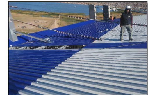
Fotografía 193. Seguimiento de partidas en obra (fuente propia)
