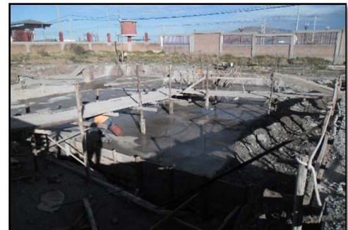
Fotografía 075. Seguimiento de partidas en obra (fuente propia)
