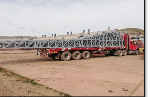
Fotografía 168. Seguimiento de partidas en obra (fuente propia)
