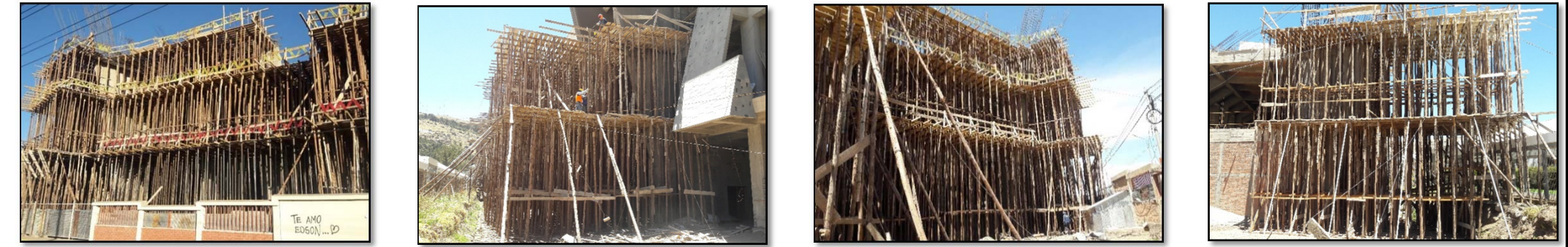
Fotografía 017. Seguimiento de partidas en obra (fuente propia) Fotografía 018. Seguimiento de partidas en obra (fuente propia) Fotografía 019. Seguimiento de partidas en obra (fuente propia) Fotografía 020. Seguimiento de partidas en obra (fuente propia)
