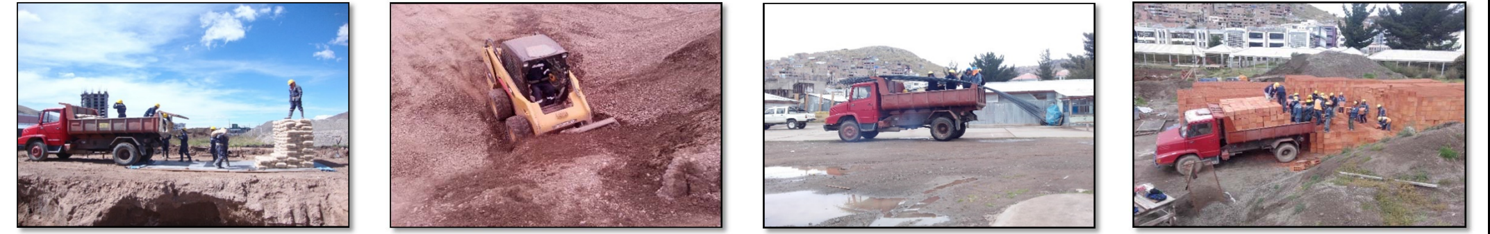
Fotografía 217. Seguimiento de partidas en obra (fuente propia) Fotografía 218. Seguimiento de partidas en obra (fuente propia) Fotografía 219. Seguimiento de partidas en obra (fuente propia) Fotografía 220. Seguimiento de partidas en obra (fuente propia)
