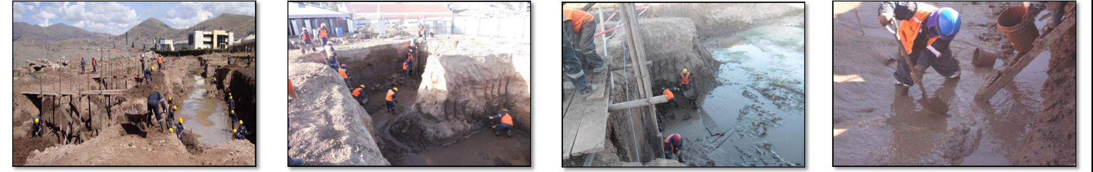
Fotografía 057. Seguimiento de partidas en obra (fuente propia) Fotografía 058. Seguimiento de partidas en obra (fuente propia) Fotografía 059. Seguimiento de partidas en obra (fuente propia) Fotografía 060. Seguimiento de partidas en obra (fuente propia)
