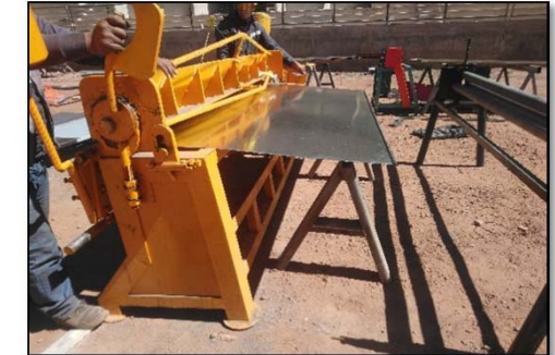
Fotografía 197. Seguimiento de partidas en obra (fuente propia)
