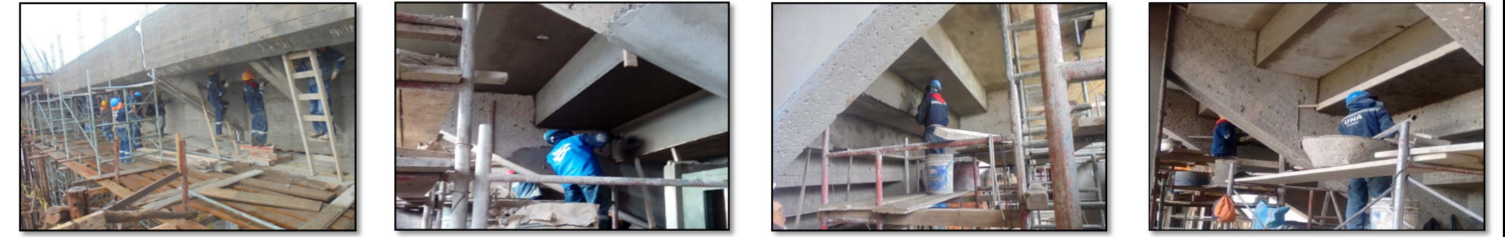
Fotografía 265. Seguimiento de partidas en obra (fuente propia) Fotografía 266. Seguimiento de partidas en obra (fuente propia) Fotografía 267. Seguimiento de partidas en obra (fuente propia) Fotografía 268. Seguimiento de partidas en obra (fuente propia)
