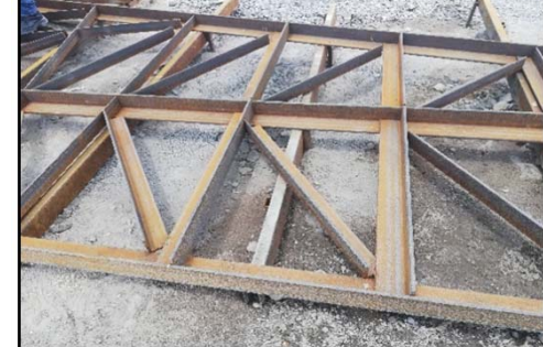
Fotografía 165. Seguimiento de partidas en obra (fuente propia)
