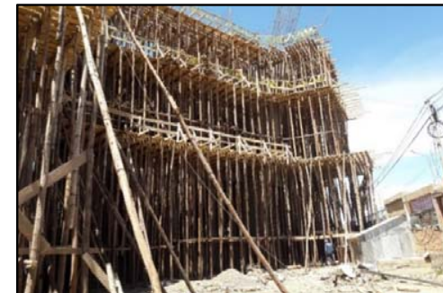
Fotografía 025. Seguimiento de partidas en obra (fuente propia)
