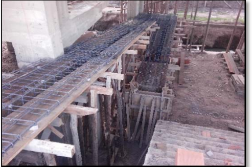
Fotografía 164. Seguimiento de partidas en obra (fuente propia)
