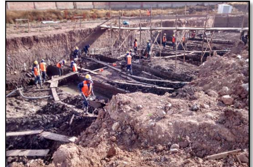
Fotografía 002. Seguimiento de partidas en obra (fuente propia)
