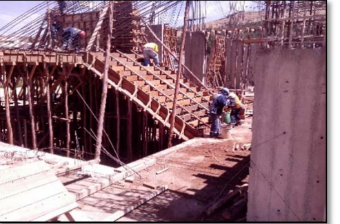
Fotografía 156. Seguimiento de partidas en obra (fuente propia)
