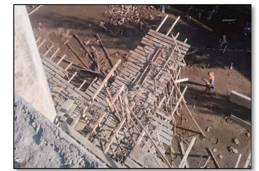
Fotografía 011. Seguimiento de partidas en obra (fuente propia)
