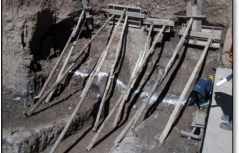
Fotografía 030. Seguimiento de partidas en obra (fuente propia)
