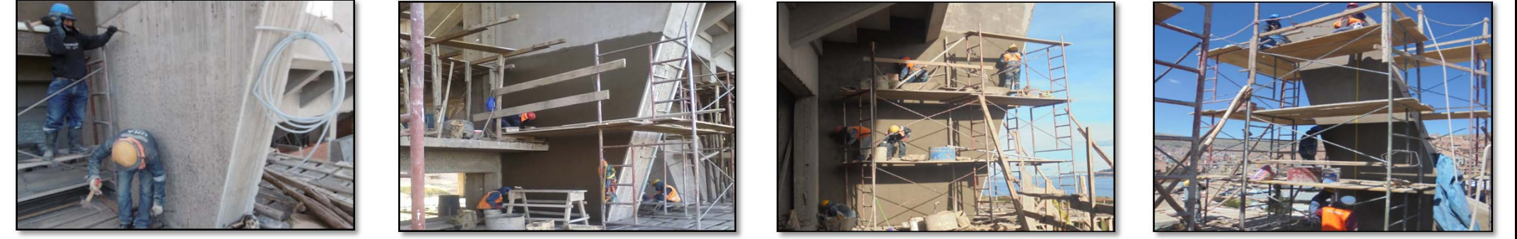
Fotografía 241. Seguimiento de partidas en obra (fuente propia) Fotografía 242. Seguimiento de partidas en obra (fuente propia) Fotografía 243. Seguimiento de partidas en obra (fuente propia) Fotografía 244. Seguimiento de partidas en obra (fuente propia)
