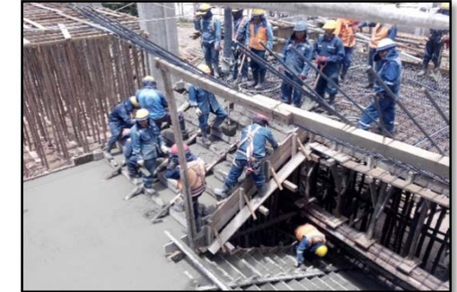
Fotografía 153. Seguimiento de partidas en obra (fuente propia)
