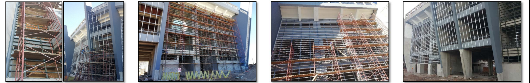
Fotografía 289. Seguimiento de partidas en obra (fuente propia) Fotografía 290. Seguimiento de partidas en obra (fuente propia) Fotografía 291. Seguimiento de partidas en obra (fuente propia) Fotografía 292. Seguimiento de partidas en obra (fuente propia)
