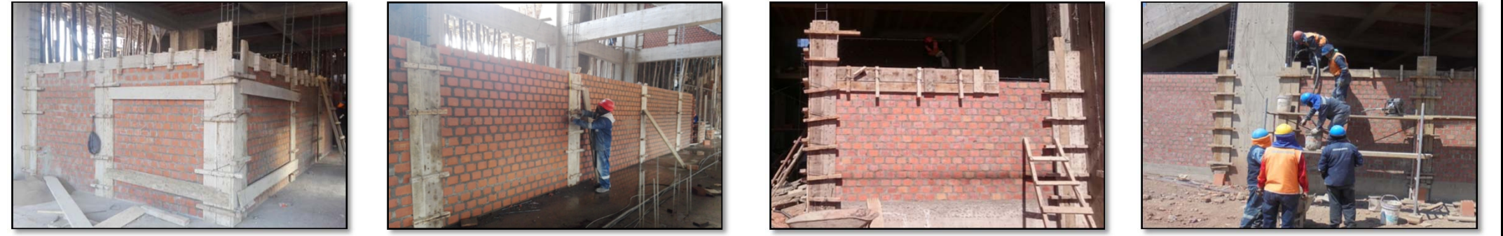
Fotografía 157. Seguimiento de partidas en obra (fuente propia) Fotografía 158. Seguimiento de partidas en obra (fuente propia) Fotografía 159. Seguimiento de partidas en obra (fuente propia) Fotografía 160. Seguimiento de partidas en obra (fuente propia)
