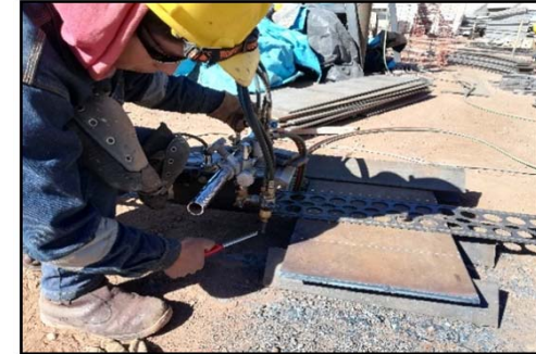
Fotografía 173. Seguimiento de partidas en obra (fuente propia)
