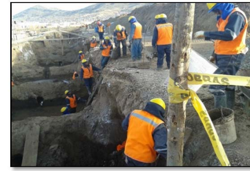
Fotografía 035. Seguimiento de partidas en obra (fuente propia)
