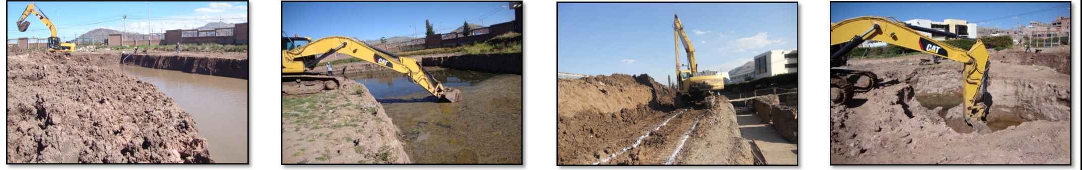
Fotografía 037. Seguimiento de partidas en obra (fuente propia) Fotografía 038. Seguimiento de partidas en obra (fuente propia) Fotografía 039. Seguimiento de partidas en obra (fuente propia) Fotografía 040. Seguimiento de partidas en obra (fuente propia)
