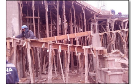
Fotografía 161. Seguimiento de partidas en obra (fuente propia)
