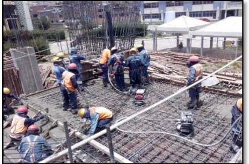
Fotografía 155. Seguimiento de partidas en obra (fuente propia)
