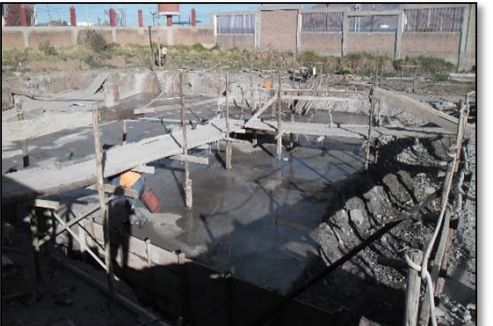
Fotografía 004. Seguimiento de partidas en obra (fuente propia)
