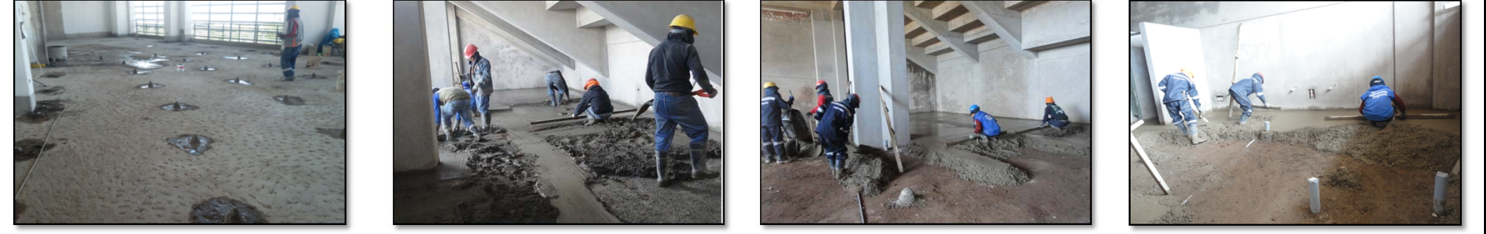
Fotografía 269. Seguimiento de partidas en obra (fuente propia) Fotografía 270. Seguimiento de partidas en obra (fuente propia) Fotografía 271. Seguimiento de partidas en obra (fuente propia) Fotografía 272. Seguimiento de partidas en obra (fuente propia)
