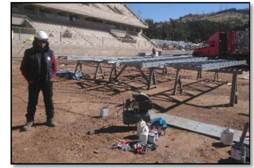
Fotografía 181. Seguimiento de partidas en obra (fuente propia)
