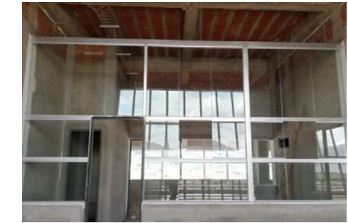
Fotografía 309. Seguimiento de partidas en obra (fuente propia)
