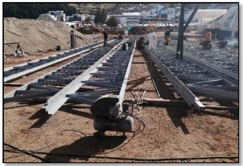
Fotografía 184. Seguimiento de partidas en obra (fuente propia)
