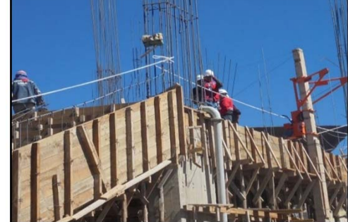
Fotografía 029. Seguimiento de partidas en obra (fuente propia)
