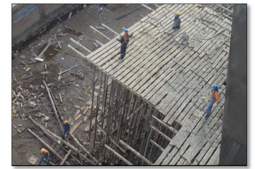
Fotografía 010. Seguimiento de partidas en obra (fuente propia)
