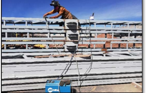
Fotografía 167. Seguimiento de partidas en obra (fuente propia)
