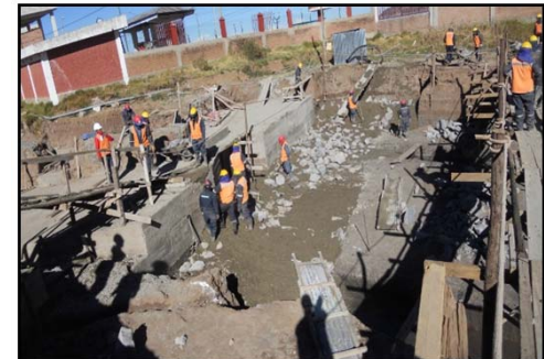
Fotografía 074. Seguimiento de partidas en obra (fuente propia)
