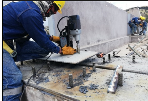
Fotografía 174. Seguimiento de partidas en obra (fuente propia)
