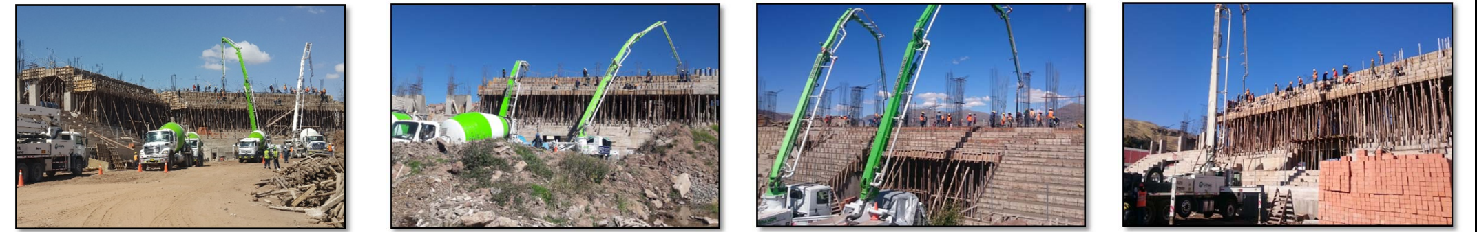
Fotografía 125. Seguimiento de partidas en obra (fuente propia) Fotografía 126. Seguimiento de partidas en obra (fuente propia) Fotografía 127. Seguimiento de partidas en obra (fuente propia) Fotografía 128. Seguimiento de partidas en obra (fuente propia)
