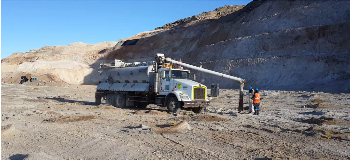
Foto 20. Carguío de taladros con Camión Fabrica. Fuente: Autor del informe de trabajo profesional.
