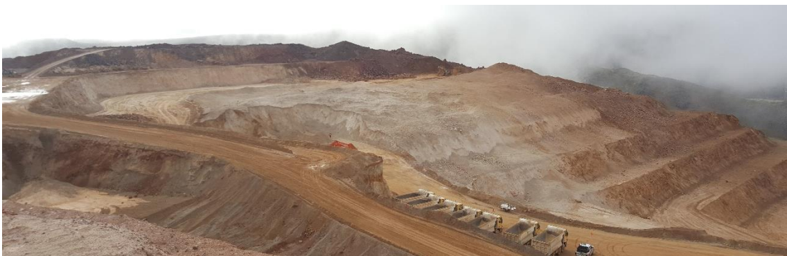
Foto 24. Después de la voladura. Fuente: Autor del informe de trabajo profesional.
