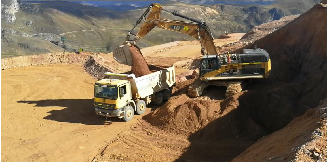
Foto 31. Después de la voladura SG. Fuente: Autor del informe de trabajo profesional.
