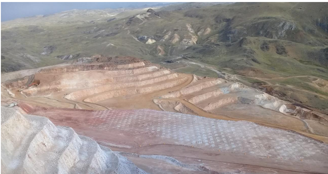
Foto 19. Plataforma antes de la voladura. Fuente: Autor del informe de trabajo profesional.
