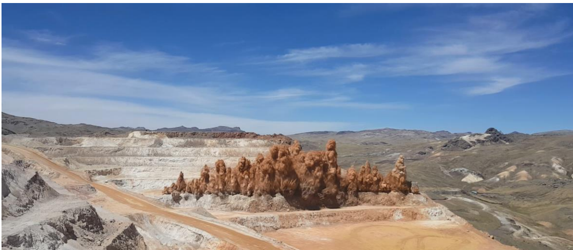
Foto 23. Voladura. Fuente: Autor del informe de trabajo profesional.
