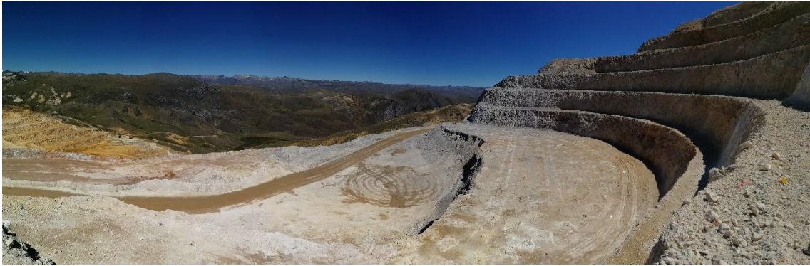
Foto 25. Antes de la voladura. Fuente: Autor del informe de trabajo profesional.
