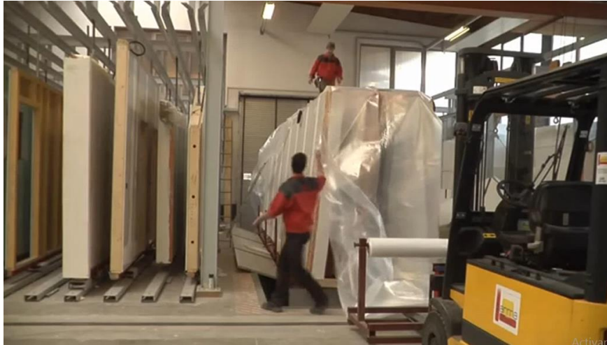
FIGURA 149. Almacenamiento de paneles prefabricados:
