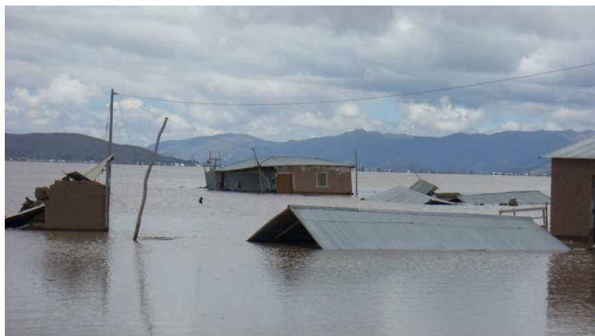
FIGURA 20. Viviendas en totalmente colapsadas:
