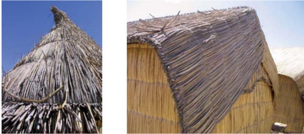
FIGURA 31. El tratamiento de la totora para cubiertas:
