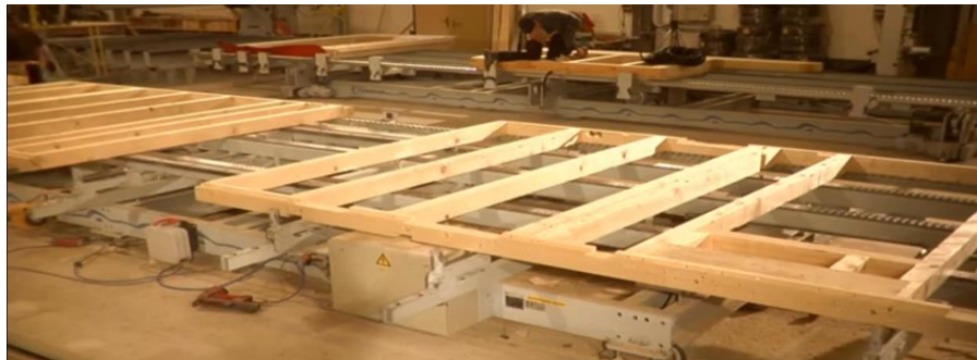
FIGURA 126. Prefabricación del panel techo:
