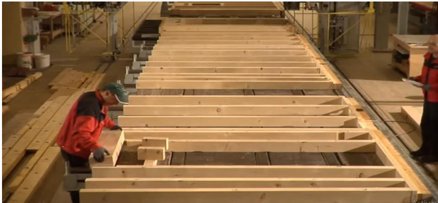
FIGURA 63. Prefabricación de los paneles de muro:
