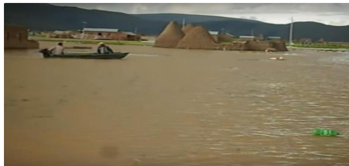
FIGURA 16. Viviendas completamente colapsadas:
