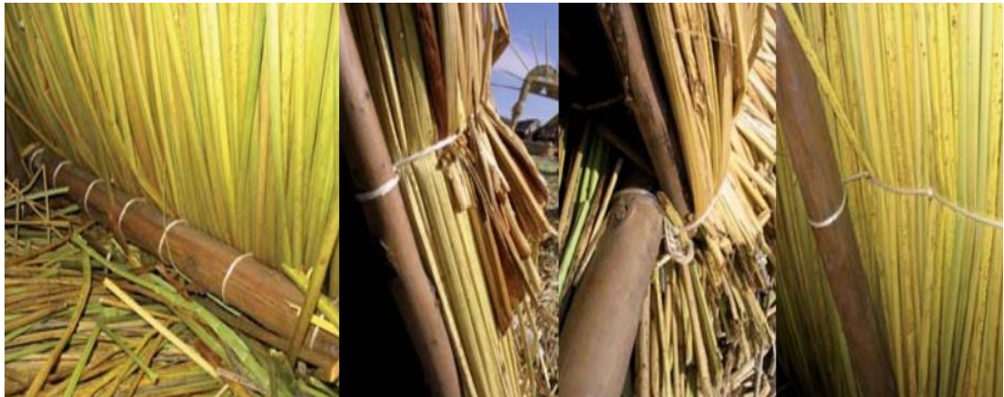
FIGURA 33. Armazón de la k'esana y madera en viviendas:
