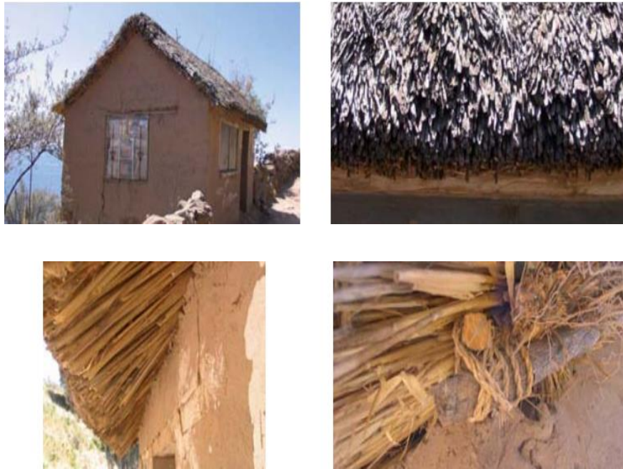
FIGURA 34. La totora en las viviendas ancestrales usada en techos:
