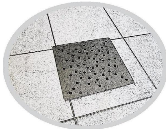
Imagen 5. Sumidero de agua recomendado en piso de planta de quesos
