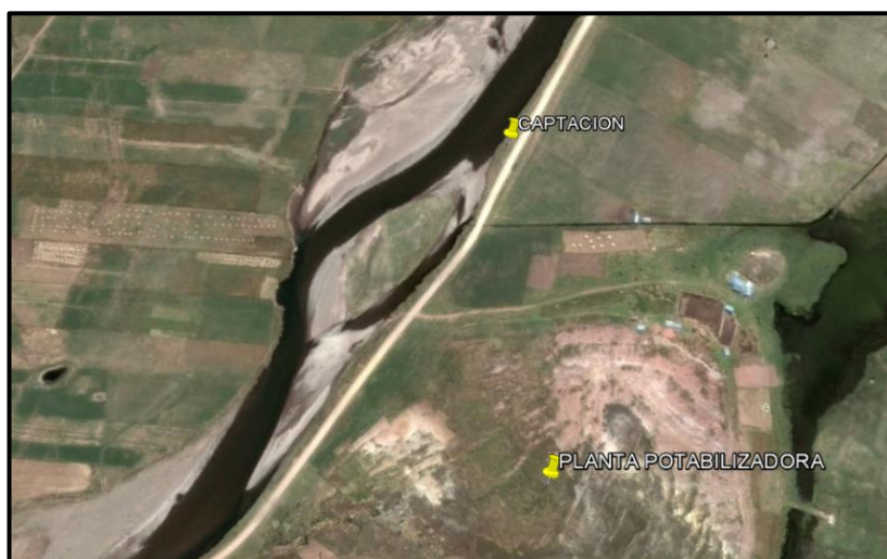
Figura N° 14: ubicación de la captación
