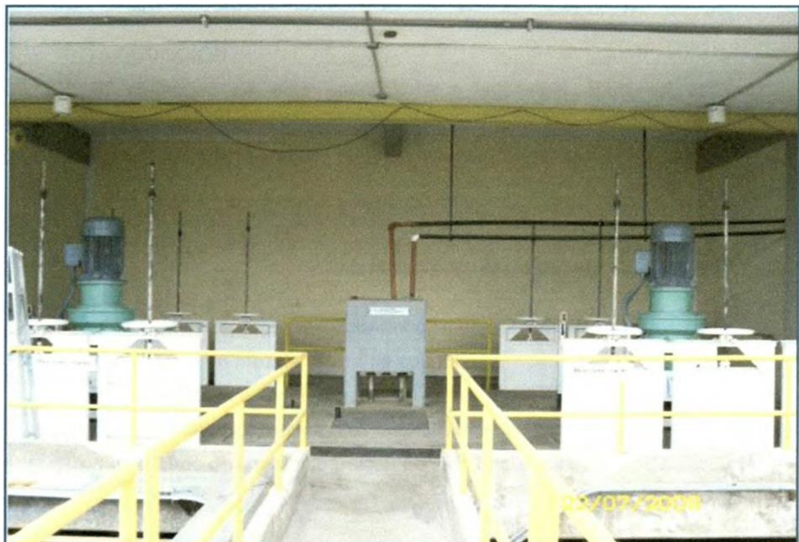
Figura N° 08: Planta patentada - Mezcladores rápidos mecánicos. Fuente: OPS/CEPIS
