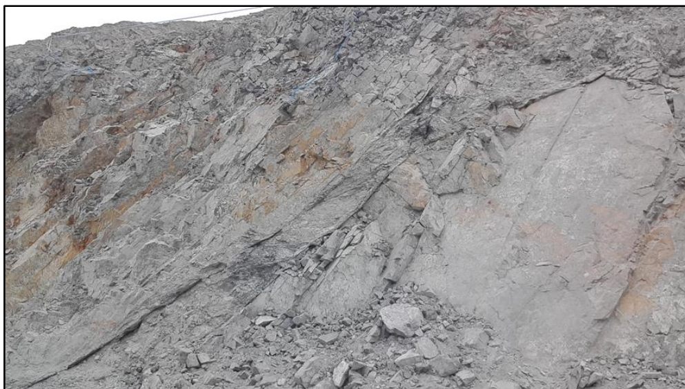
Figura 22. Fracturamiento, monitoreo después de la voladura, se debe diferenciar las fracturas naturales de las artificiales.
