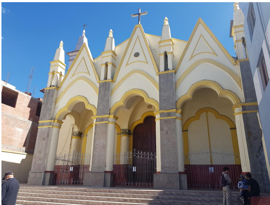
Figura N° 4.23: Iglesia San Juan
