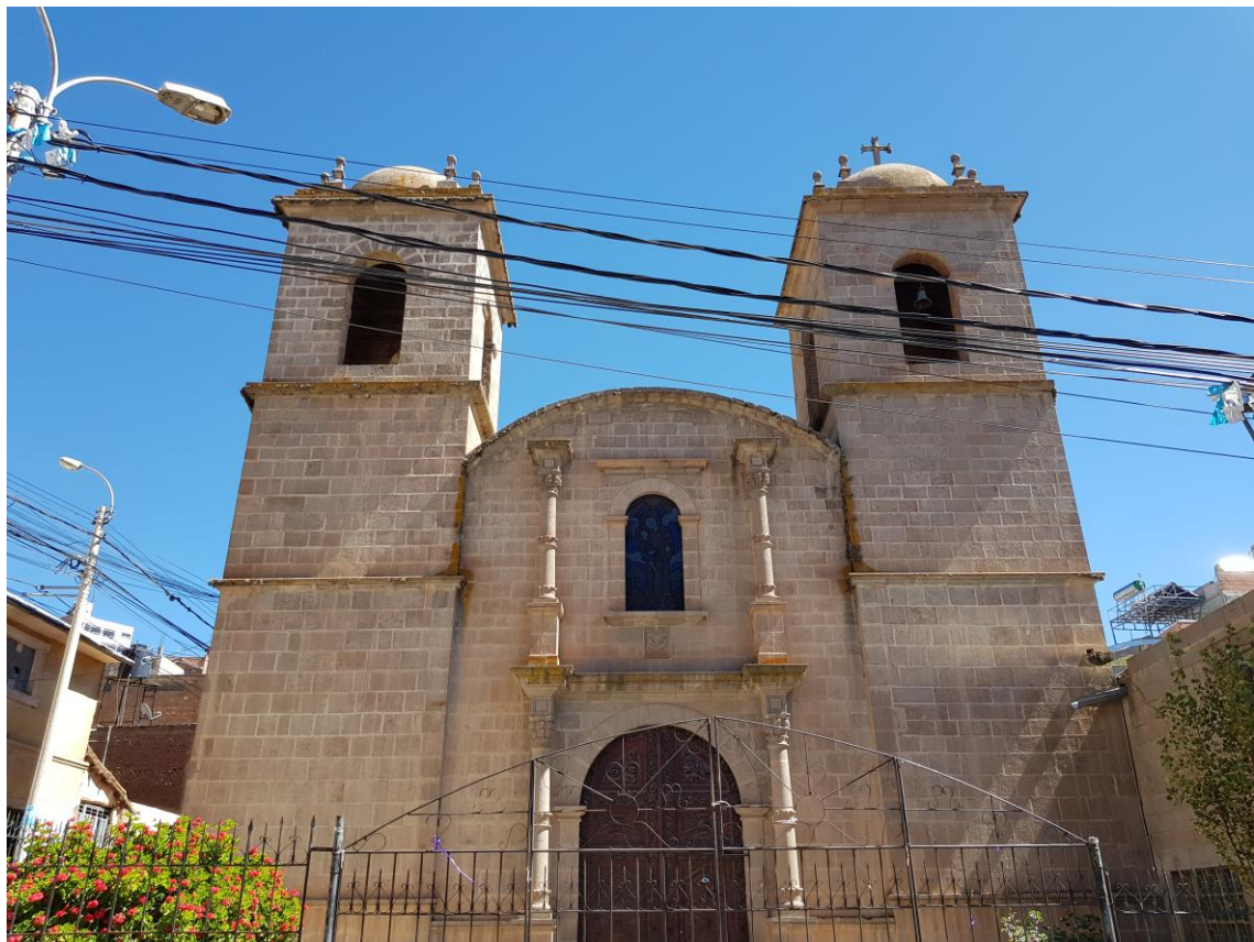
Figura N° 4.28: Iglesia San Antonio
