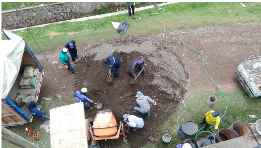
Fotografía 82: Vista horizontal del sistema de abastecimiento y mezclado de los materiales.
