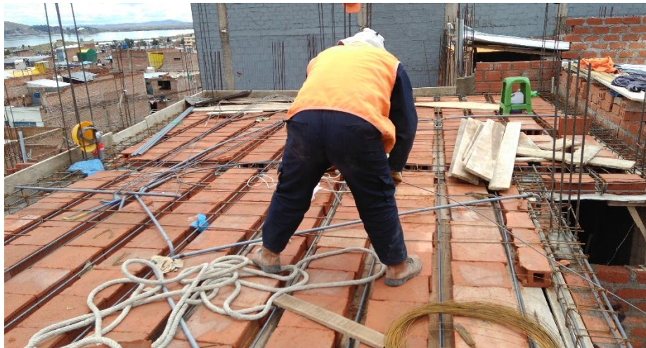
Fotografía 58: Vista de la parte superior de la losa aligerada en construcción.
