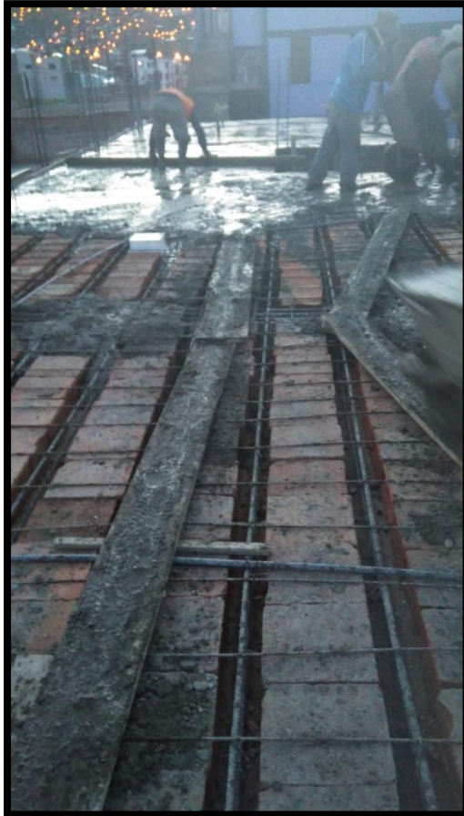
Fotografía 112 y Fotografía 113: A la izquierda procedimientos de colocación del concreto. A la derecha se aprecia trabajos de colocación del concreto en horario nocturno.
