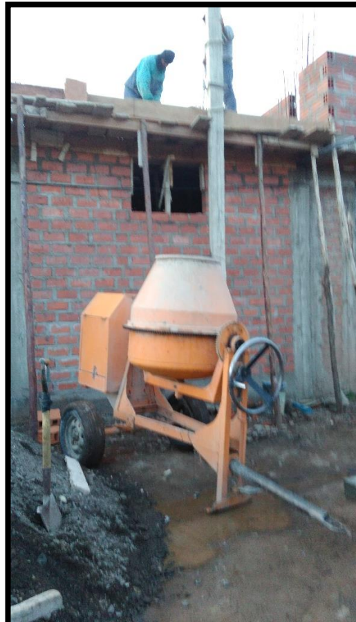
Fotografía 62 y Fotografía 63: A la izquierda el encofrado, se aprecia puntales muy esbeltas. A la derecha el armado del winche eléctrico y posicionamiento de la mezcladora de concreto.
