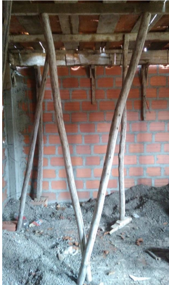
Fotografía14: Se puede apreciar puntales inclinados colocados en el encofrado.
