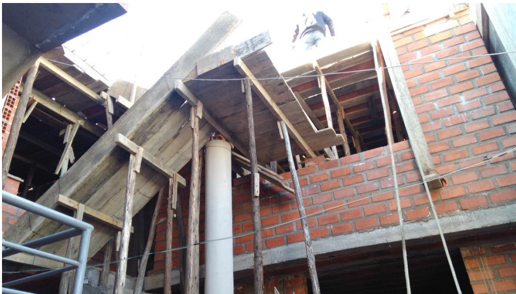
Fotografía 43: Vista frontal de la construcción, vivienda número 09.
