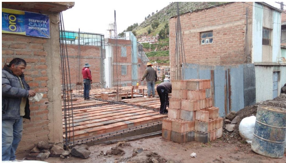
Fotografía 103: Toma frontal de la vivienda número 19.
