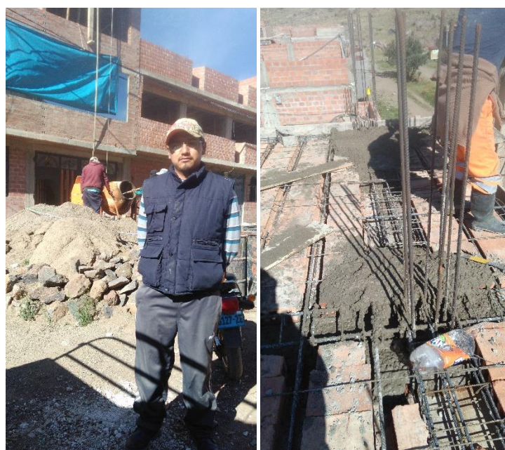
Fotografía05: En la fotografía izquierda se aprecia la fachada del vivienda, en la fotografía derecha la colocación del concreto, colocando primero las vigas.
