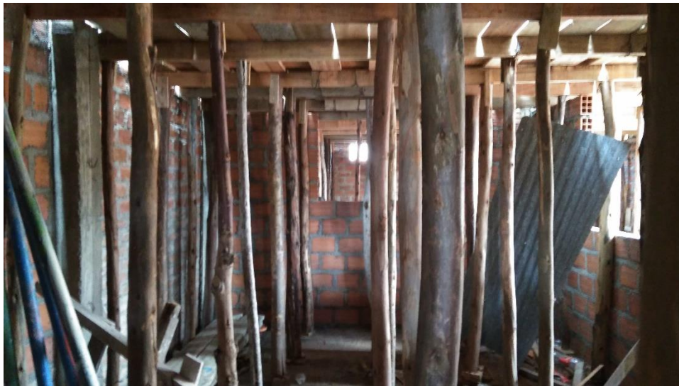
Fotografía 77: Vista general del encofrado.
