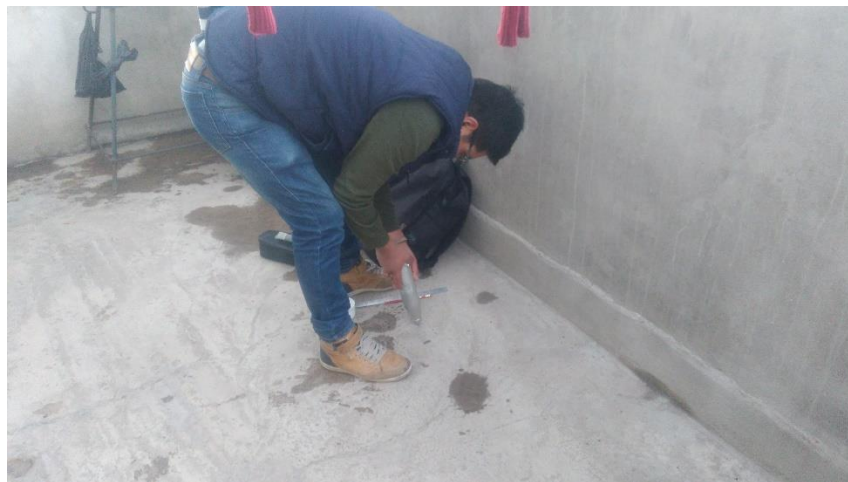
Fotografía 120: Se aprecia momento del proceso del ensayo del esclerómetro.
