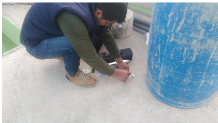
Fotografía 117: Se prepara la superficie trazando un cuadro a 2 pulgadas de distancia para efectuar el golpe con el esclerómetro.
