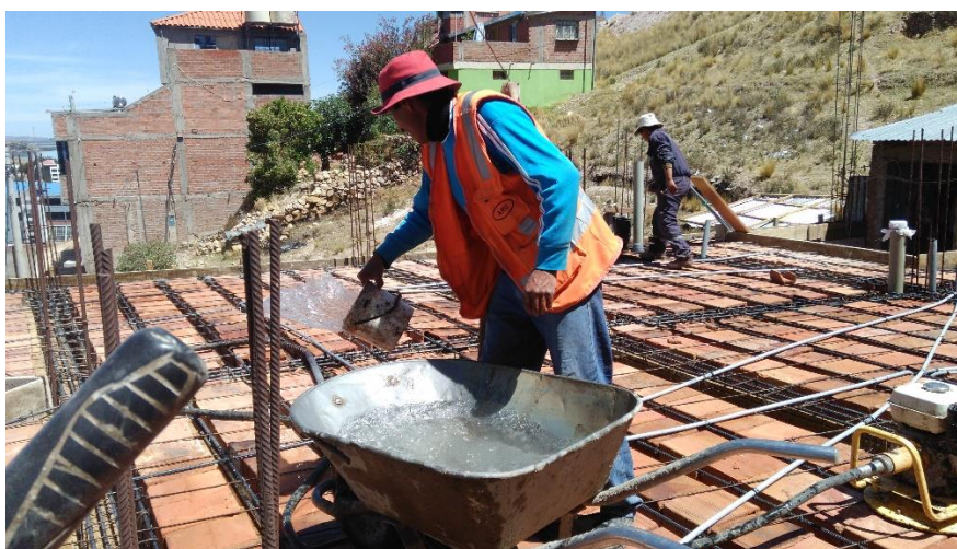
Fotografía 20: Se muestra el proceso de humedecimiento de las unidades de albañilería.
