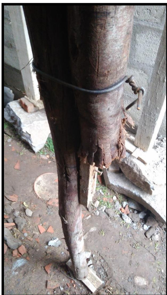
Fotografía 68 y Fotografía 69: A la izquierda un empalme de puntales para cumplir la función de soporte del peso del encofrado y materiales. A la derecha el sistema sanitario.
