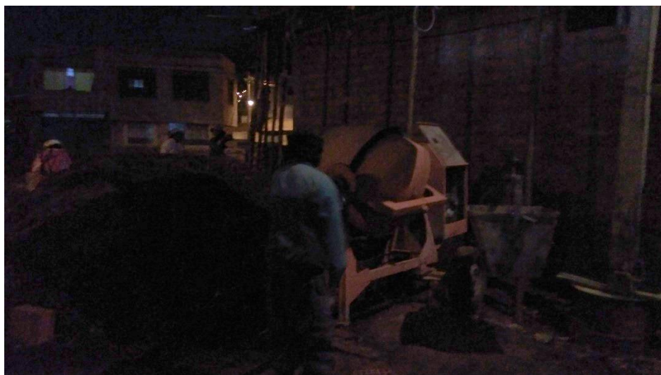
Fotografía 66: Se muestra trabajos de mezclado del concreto en equipo correspondiente y la baja luminosidad pues esta acción se realiza en horas de la noche.
