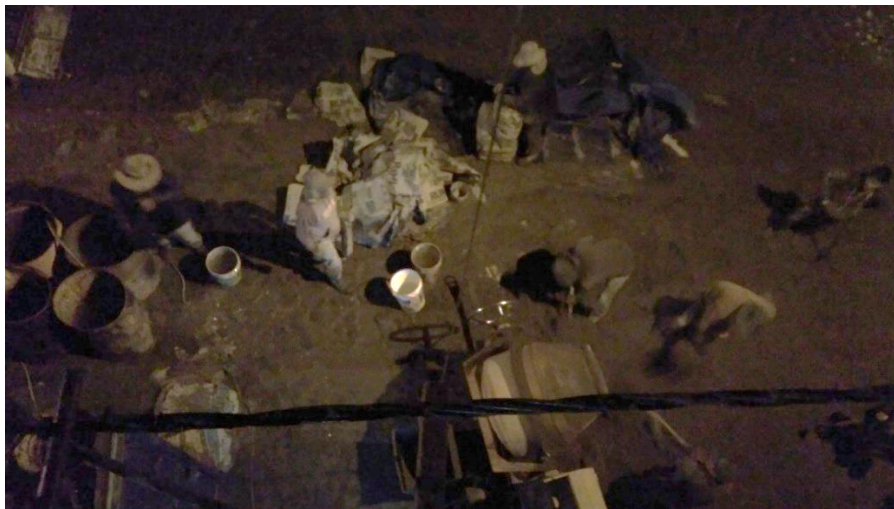
Fotografía 95: Se muestra trabajos de mezclado de los materiales en horas nocturnas.
