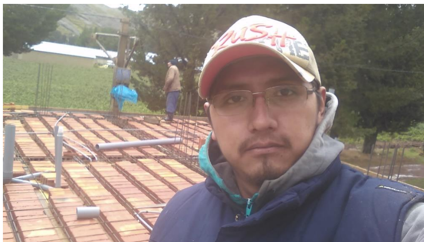
Fotografía 70: Vista semihorizontal de la colocación de las unidades de albañilería y el acero de refuerzo.
