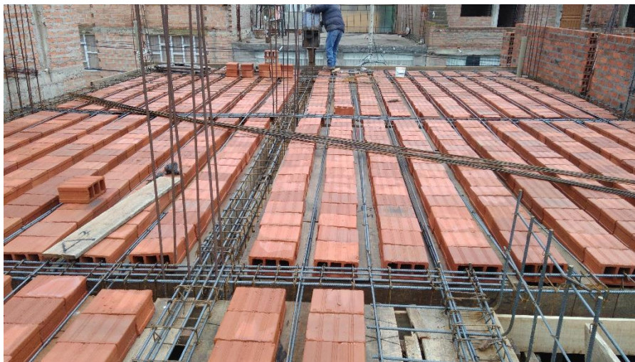
Fotografía 86: Vista de la losa preparada para la colocación del concreto.
