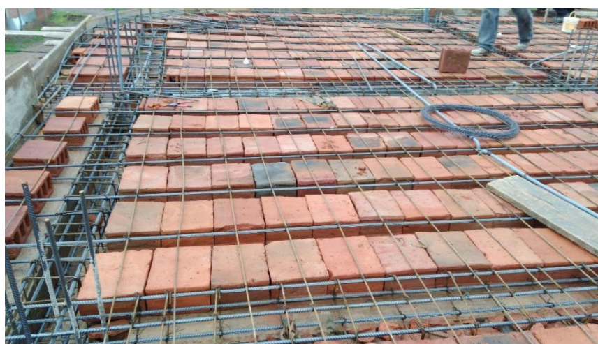
Fotografía 93: Vista terminada de la colocación del acero de temperatura.
