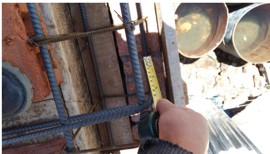
Fotografía 28: Se muestra trabajos de medición de los ganchos del refuerzo y los estribos.
