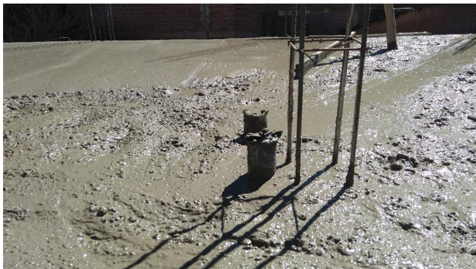
Fotografía 54: Se muestra el concreto colocado en el encofrado.
