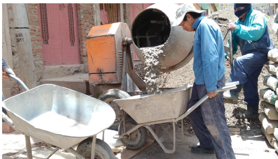
Fotografía 48: Se muestra el proceso de transporte del concreto en carretillas tipo buggy.
