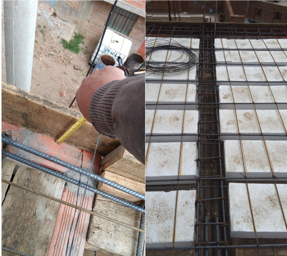
Fotografía 40 y 41: A la izquierda vista de medición de los frisos, a la derecha vista de una viga principal.
