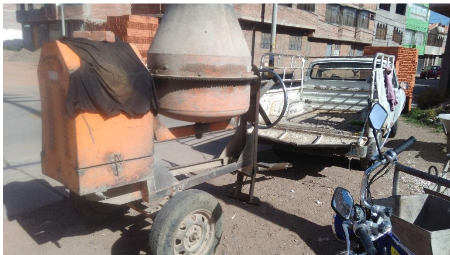
Fotografía02: Maquinaria a utilizar en el vaciado de losa aligerada
