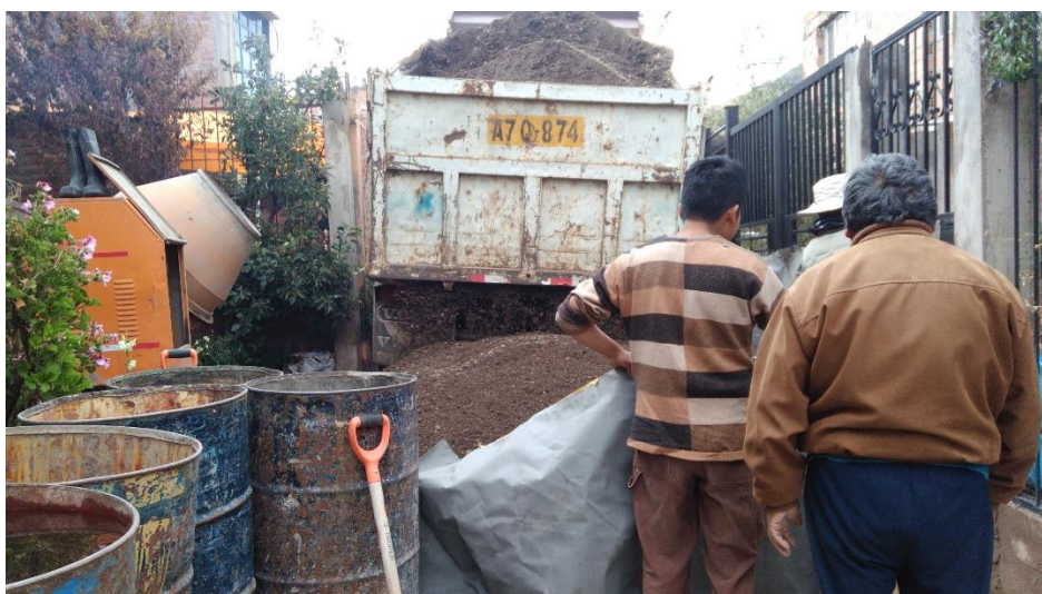
Fotografía 87: Se muestra el proceso de descargado del hormigón como material de agregado.
