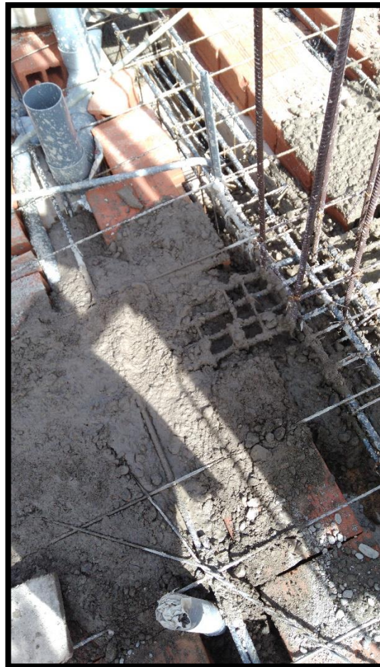
Fotografía 88 y Fotografía 89: A la izquierda colocación del sistema sanitario, se aprecia tubería en medio de vigas principales. A la derecha se muestra concreto mal dosificado notándose visualmente.
