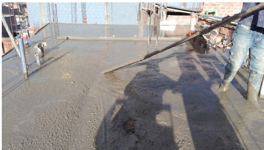
Fotografía 60: Vista del concreto colocado en el encofrado con trabajos de nivelación.
