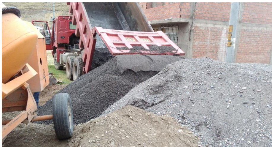
Fotografía12: Se aprecia el descargo del hormigón que se utilizara en el mezclado del concreto. Se observa también tres diferentes tipos de agregados por el color.
