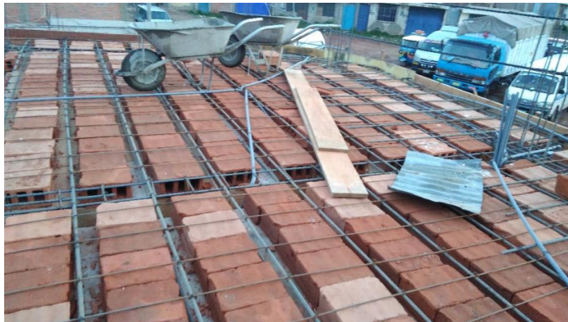
Fotografía 64: Vista de la colocación de las unidades de albañilería y el acero de refuerzo.
