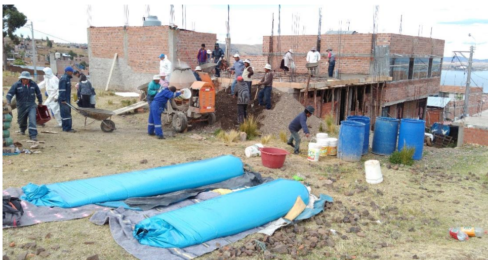
Fotografía 32: Se muestra un panorama de los trabajos de colocación del concreto así como el mezclado y transporte del mismo.
