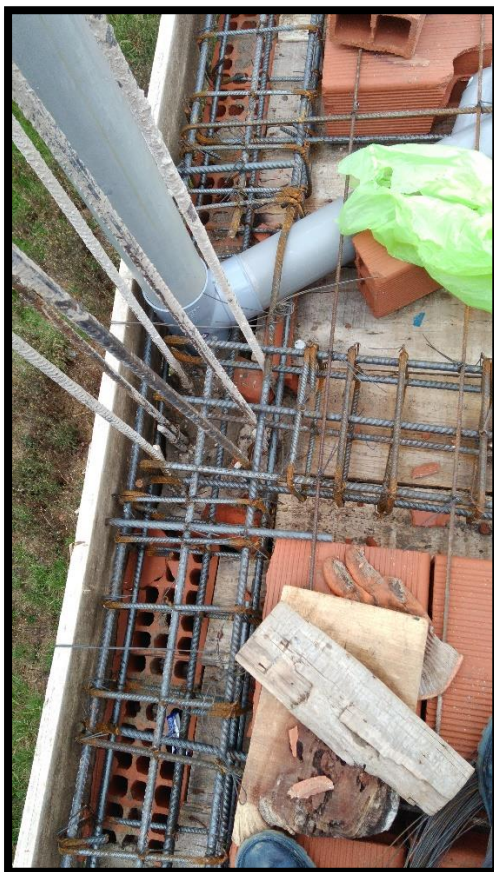
Fotografía 80 y Fotografía 81: A la izquierda colocación del acero de refuerzo. A la derecha se aprecia el sistema de transporte del concreto.
