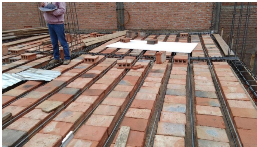
Fotografía 104: Vista terminada de la colocación de las unidades de albañilería y acero en viguetas.
