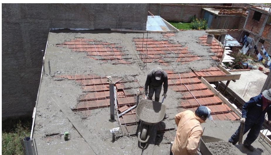
Fotografía 84: Vista de la colocación del concreto.
