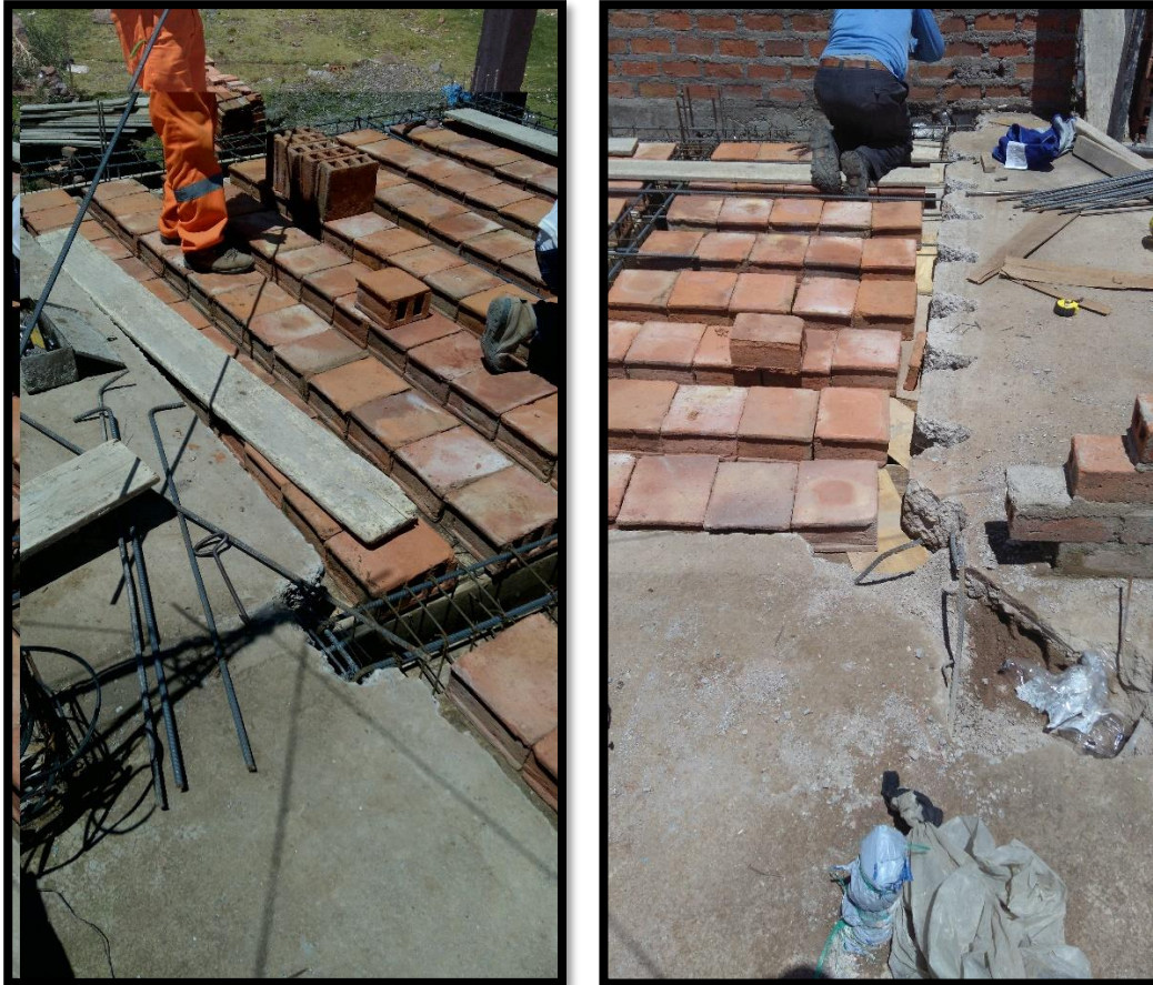
Fotografía 30: En las fotografías se aprecia empalme de una losa construida anteriormente con una nueva losa a vaciar, a la izquierda la viga empalmada a la antigua, a la derecha el empalme de las viguetas.
