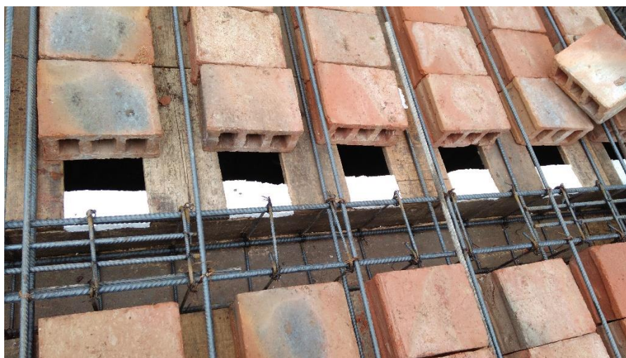
Fotografía 105: Vista de trabajos de hermeticidad del encofrado.
