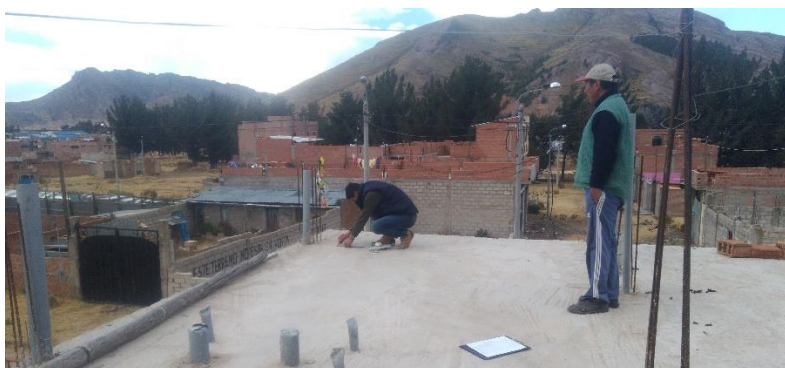
Fotografía 116: Se prepara la superficie con autorización del propietario de la vivienda.
