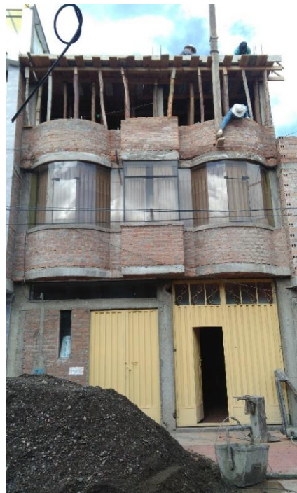
Fotografía 73: Vista frontal de la vivienda número 14.
