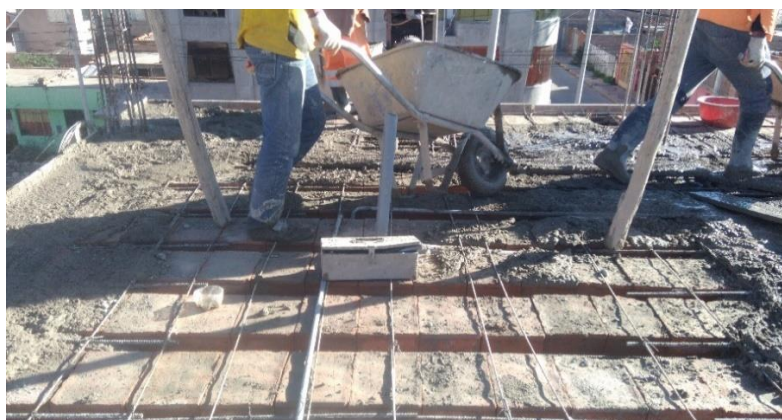
Fotografía06: Se muestra la colocación de concreto en el encofrado.
