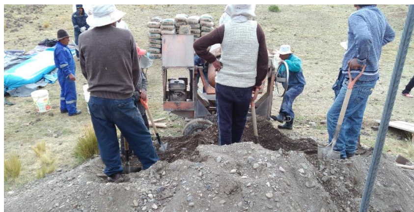
Fotografía 34: Se observa el sistema de alimentación a la mezcladora tipo trompo.
