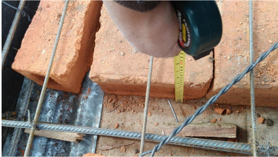
Fotografía 76: Vista de la medida de la altura de las unidades de albañilería.
