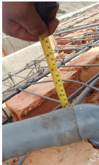
Fotografía 25: Se aprecia medición de la altura de las tuberías de desagüe y su posterior espesor de recubrimiento que tendrá la tubería.
