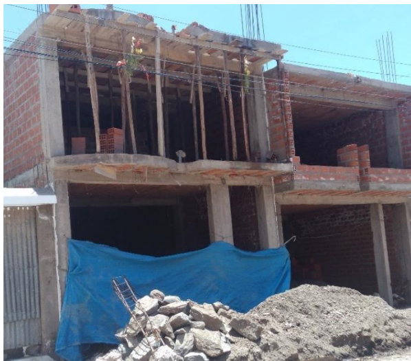
Fotografía 109: Vista de la fachada de la vivienda número 20.
