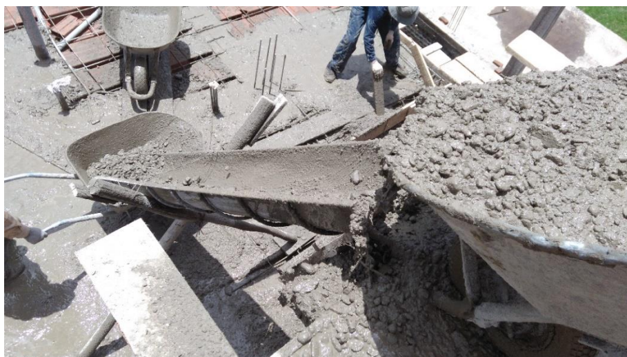
Fotografía 83: Se muestra el transporte del concreto mediante rampas.
