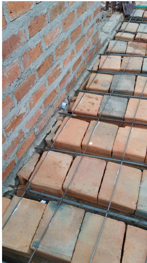
Fotografía 35: Se observa un empalme en las viguetas con construcción antigua.
