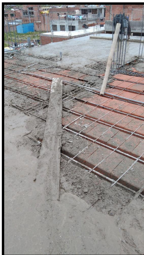
Fotografía 100 y Fotografía 101: A la izquierda momentos iniciales de la colocación del concreto. A la izquierda el concreto colocado con diferentes ubicaciones iniciales.
