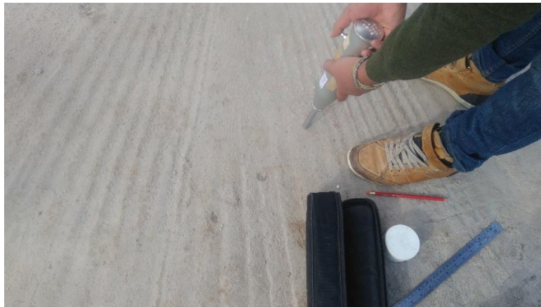
Fotografía 118: Se aprecia la operación del esclerómetro en la losa aligerada.
