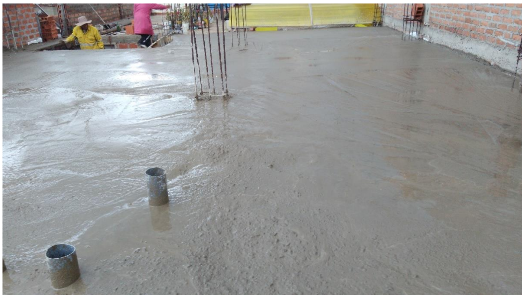
Fotografía 90: Vista casi terminada de la colocación del concreto.
