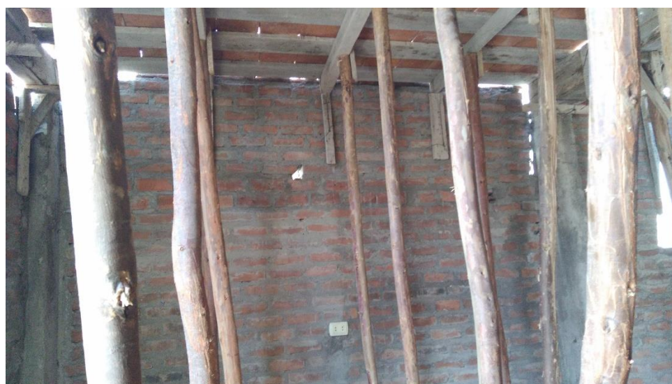
Fotografía 51: Se muestra el encofrado con la ubicación de los puntales.
