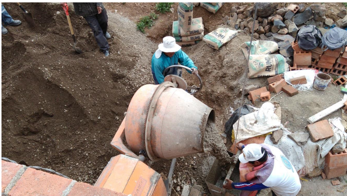
Fotografía 31: Se muestra proceso de transporte del concreto mediante el winche eléctrico.
