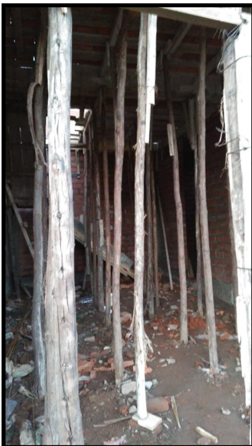
Fotografía 62 y Fotografía 63: A la izquierda el encofrado, se aprecia puntales muy esbeltas. A la derecha el armado del winche eléctrico y posicionamiento de la mezcladora de concreto.
