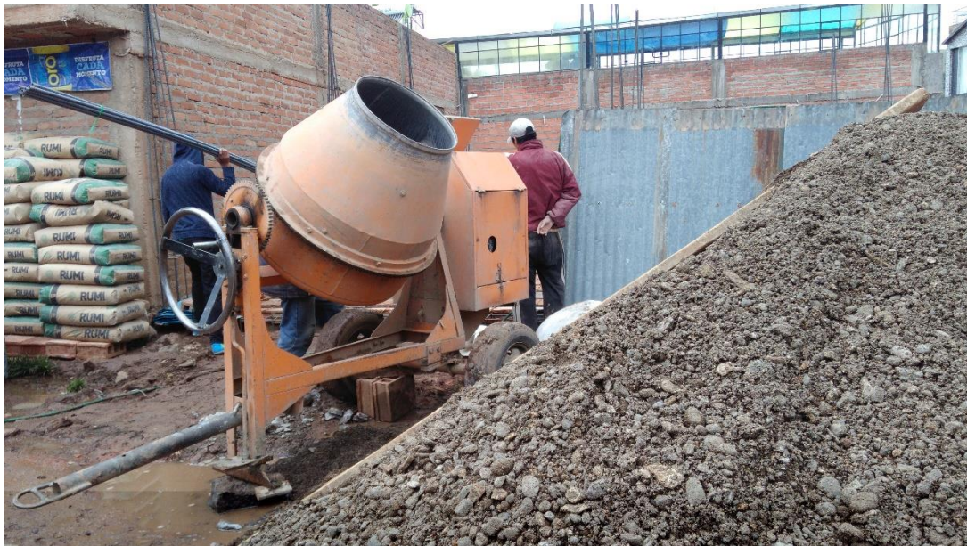
Fotografía 106: Vista del agregado, maquinaria de mezclado y bolsas de cemento.
