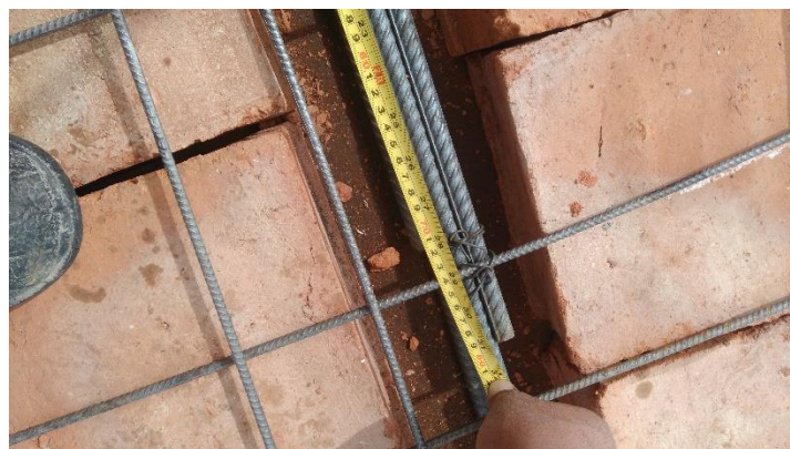
Fotografía13: Se aprecia la medición del traslape que de varillas en viguetas.
