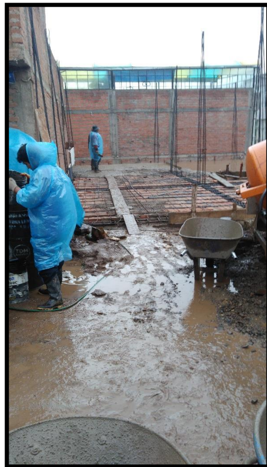
Fotografía 107 y Fotografía 108: A la izquierda procedimiento de transporte del concreto. A la derecha presencia de lluvia en la colocación del concreto.
