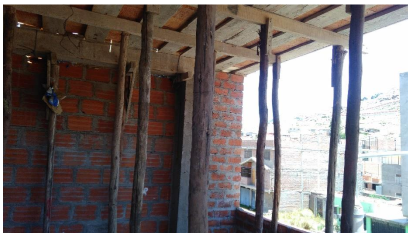
Fotografía03: Se muestra el encofrado para el vaciado de losa.
