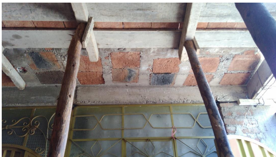
Fotografía 29: Se aprecia el encofrado contiguo a una losa construida anteriormente.
