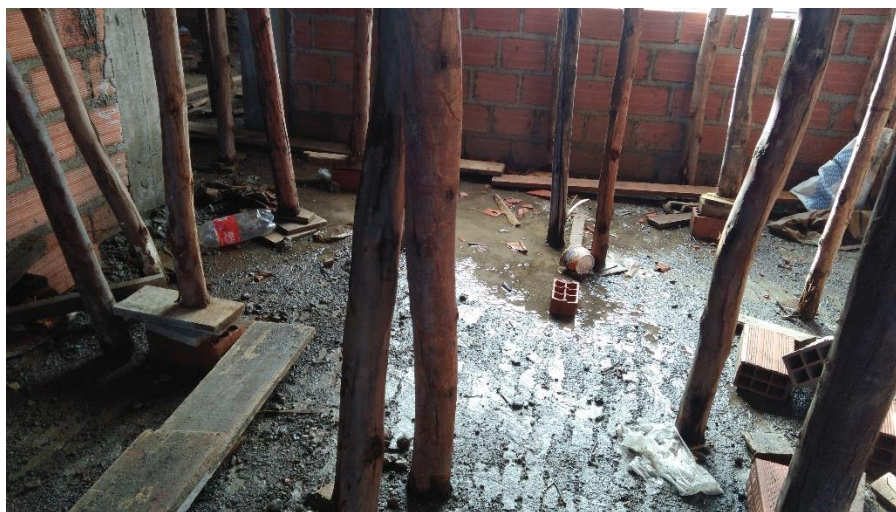
Fotografía 99: Se muestra la ubicación de los puntales con mala distribución en su ubicación.
