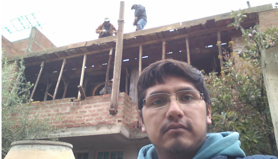
Fotografía 85: Vista de la fachada de la vivienda número 16.
