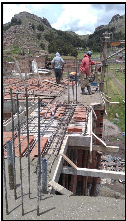
Fotografía 100 y Fotografía 101: A la izquierda momentos iniciales de la colocación del concreto. A la izquierda el concreto colocado con diferentes ubicaciones iniciales.
