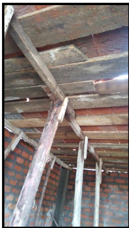
Fotografía 56 y Fotografía 57: A la izquierda vista del encofrado parte superior, se aprecia madera en mal estado. A la derecha vista de la medición del diámetro transversal de los puntales.
