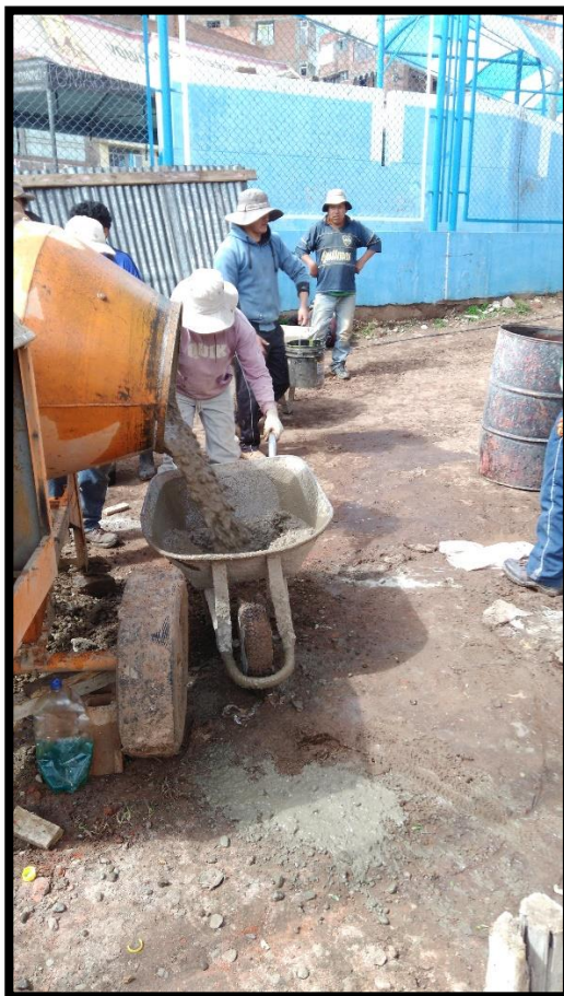
Fotografía 107 y Fotografía 108: A la izquierda procedimiento de transporte del concreto. A la derecha presencia de lluvia en la colocación del concreto.
