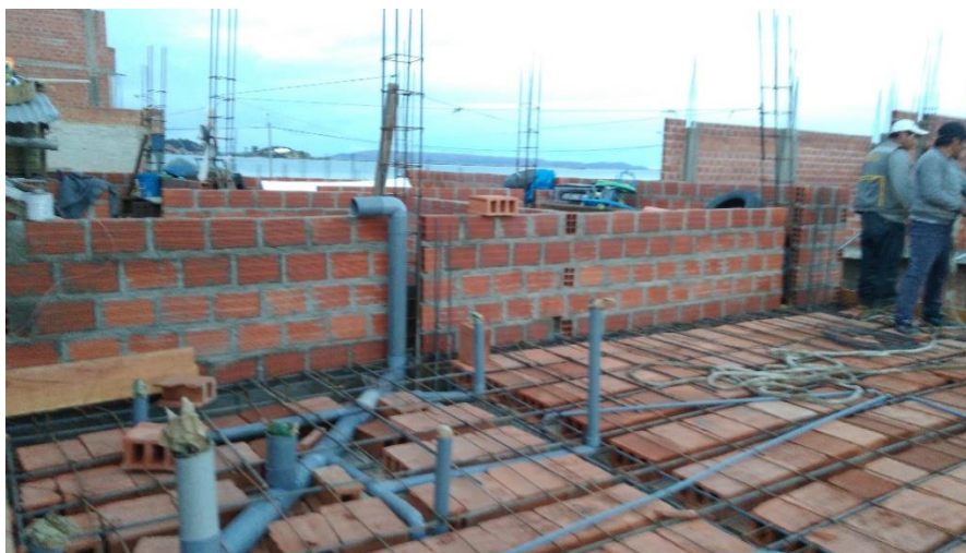
Fotografía 65: Vista de la colocación del sistema sanitario.
