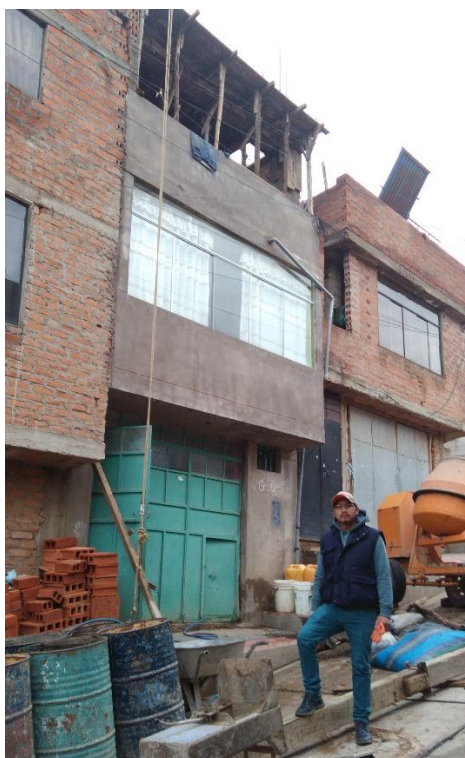
Fotografía 55: Vista de la vivienda objeto de estudio, con la tercera planta en ejecución.
