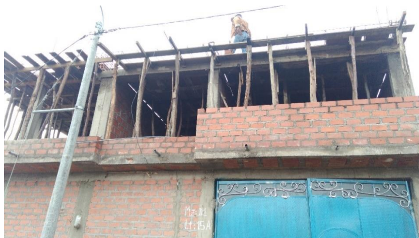
Fotografía 91: Vista de la fachada de la vivienda número 17, antes de la colocación de los frisos.
