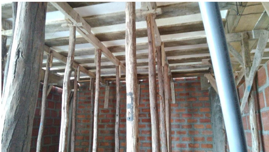
Fotografía 38: Encofrado visto del piso anterior.
