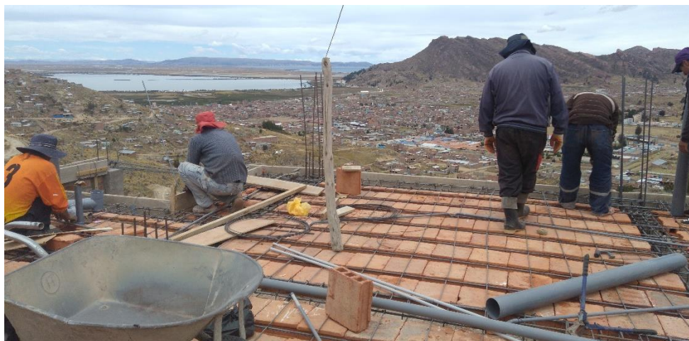
Fotografía 22: Se aprecia ultimando trabajos para el posterior vaciado del concreto.
