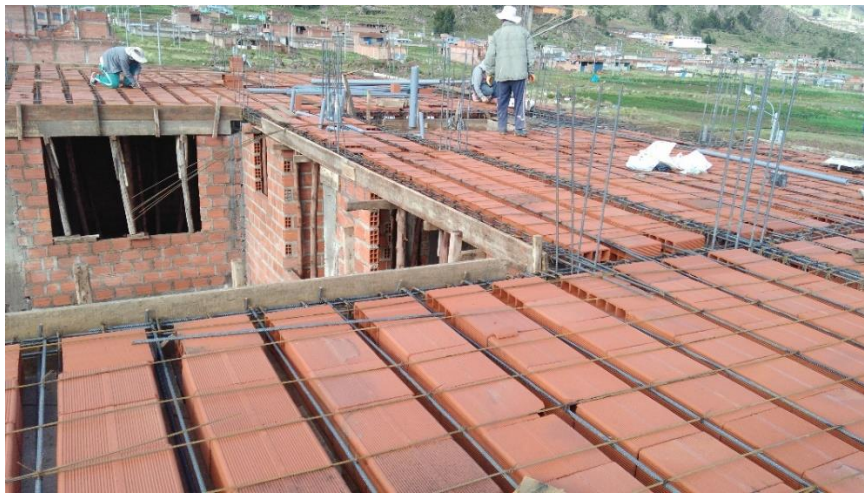
Fotografía 98: Vista superior de la losa aligerada antes con preparación antes de la colocación del concreto.
