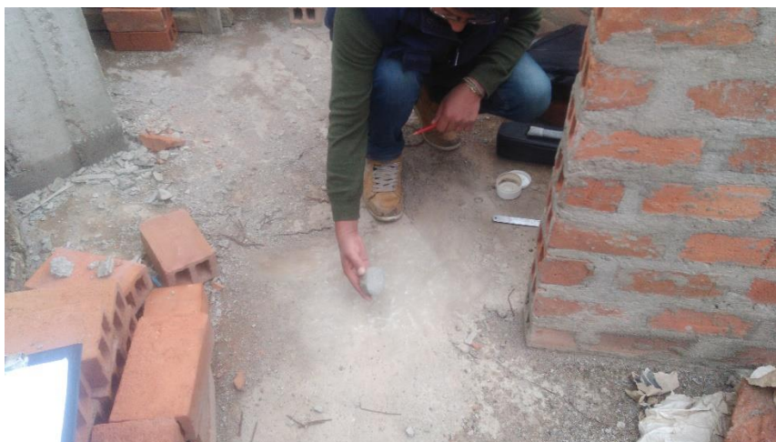
Fotografía 115: Se muestra la preparación de la superficie donde se va realizar el ensayo con la piedra abrasiva
