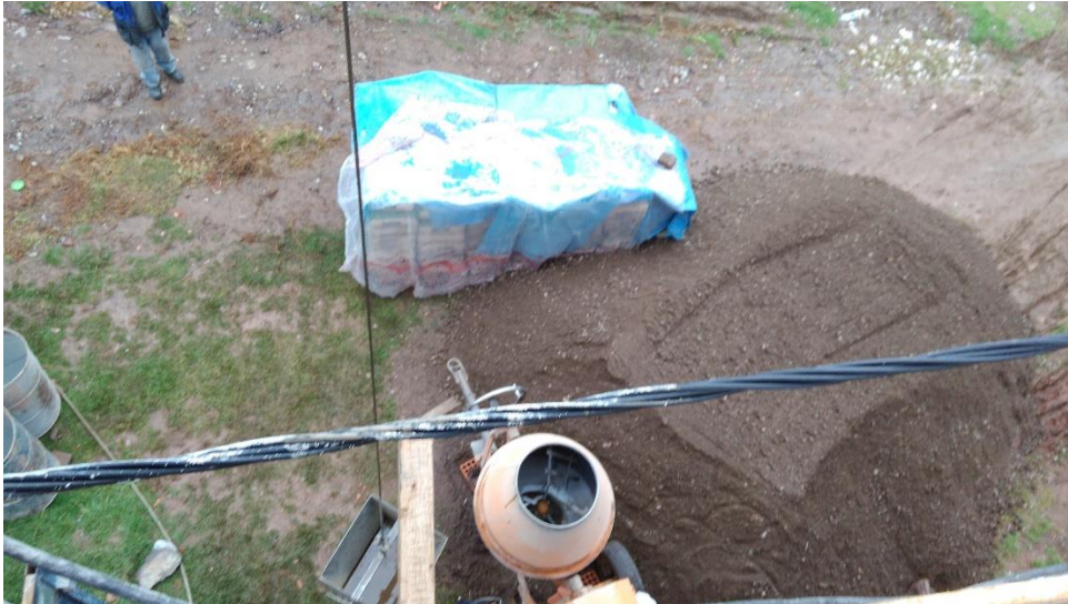
Fotografía 94: Se muestra protección de las bolsas de cemento por presencia de lluvias.
