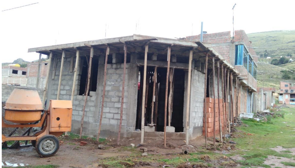
Fotografía 67: Vista frontal de la vivienda número 13 ubicado en Salcedo.
