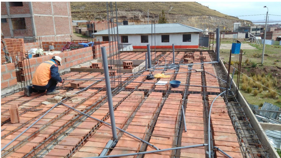
Fotografía07: Se aprecia el armado del acero del refuerzo y la albañilería para su posterior colocación del concreto.
