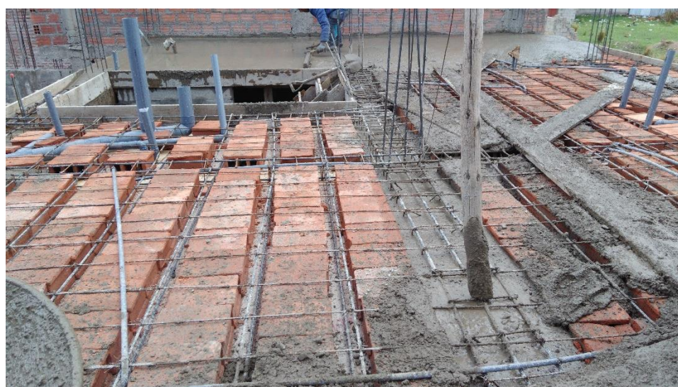
Fotografía 72: Se aprecia la colocación del concreto.
