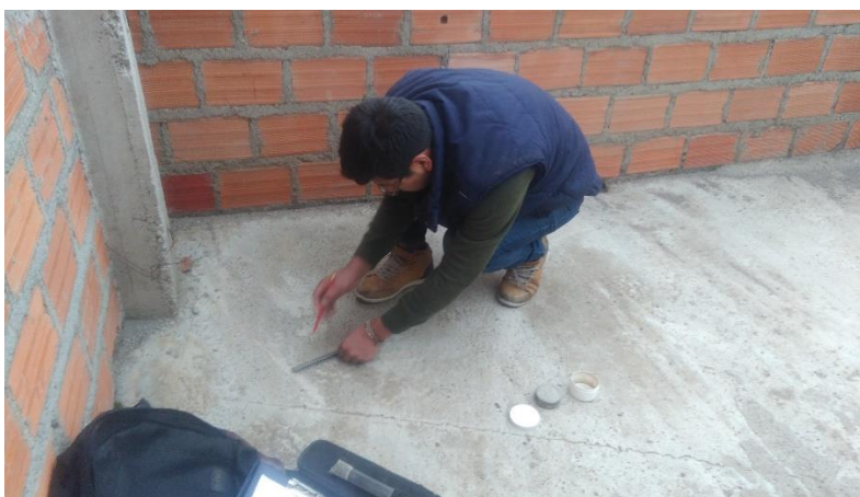
Fotografía 119: Se muestra preparación de la superficie en otra vivienda evaluada.
