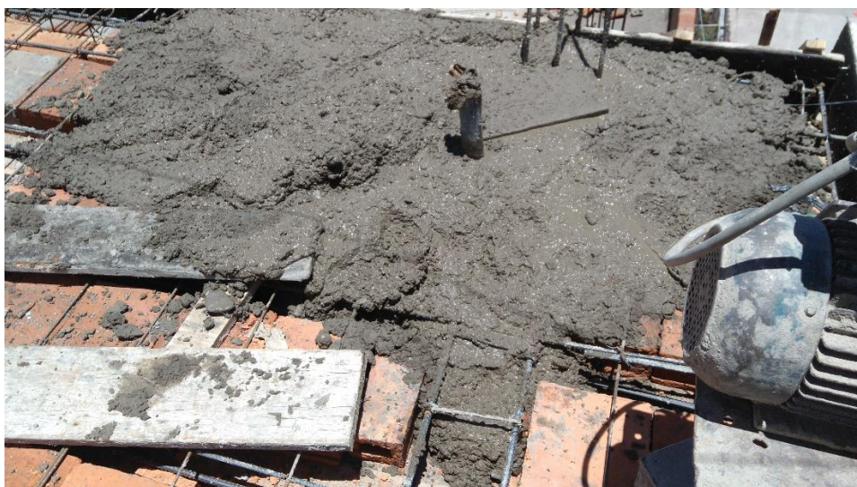
Fotografía 78: Vista de la colocación del concreto.
