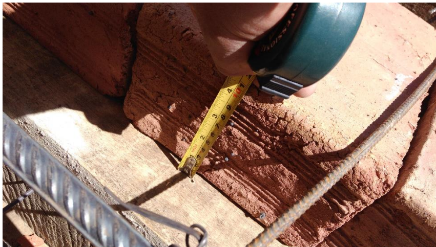
Fotografía17: Se observa la medición de las unidades de albañilería.
