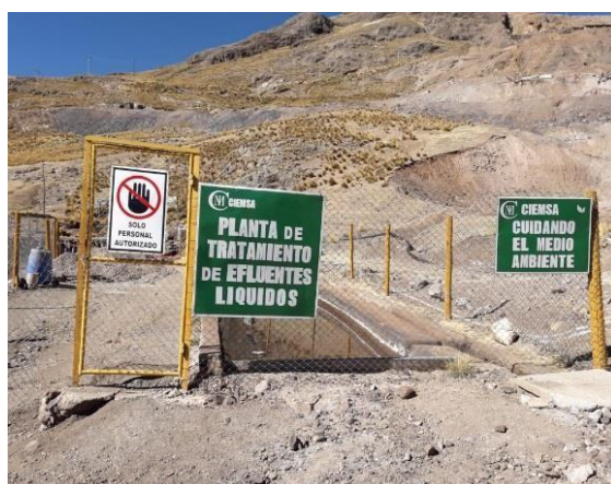
Foto 2. Planta de tratamiento de efluentes
