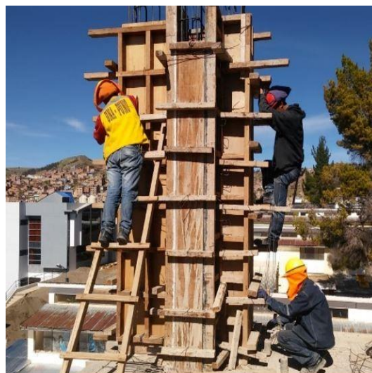
(b) Encofrado de columnas
