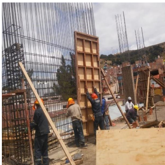
(a) Encofrado de placas
