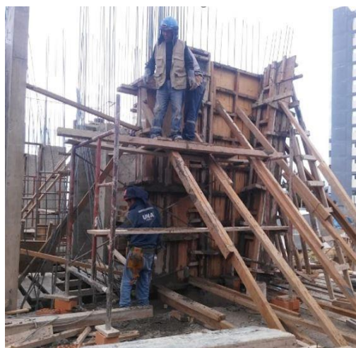
(b) Vaciado de concreto en placas
