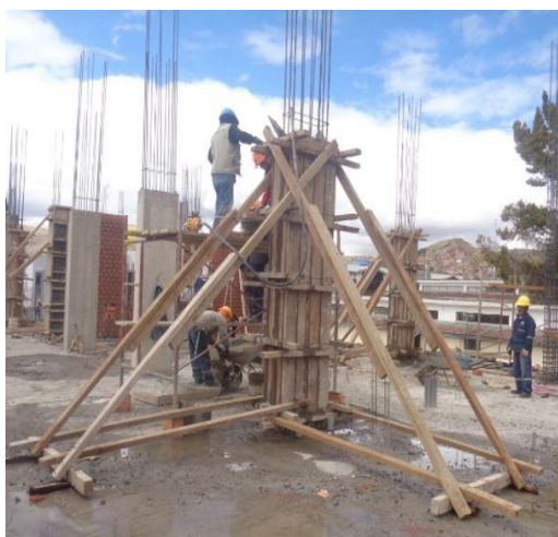
(a) Vaciado de concreto en columnas
