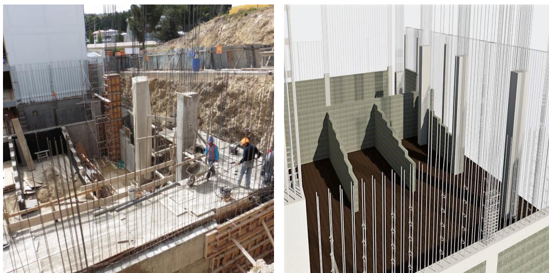
(a) Ejecución de la parte estructural
