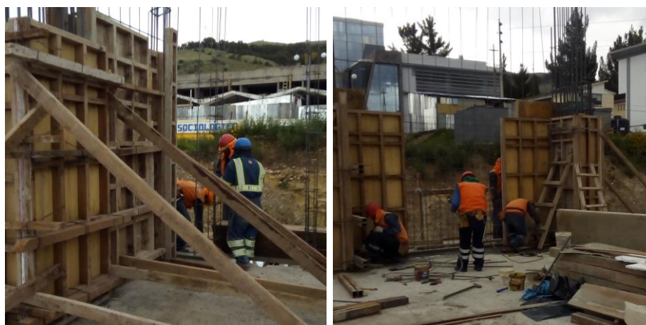
(a) Encofrado de placas
