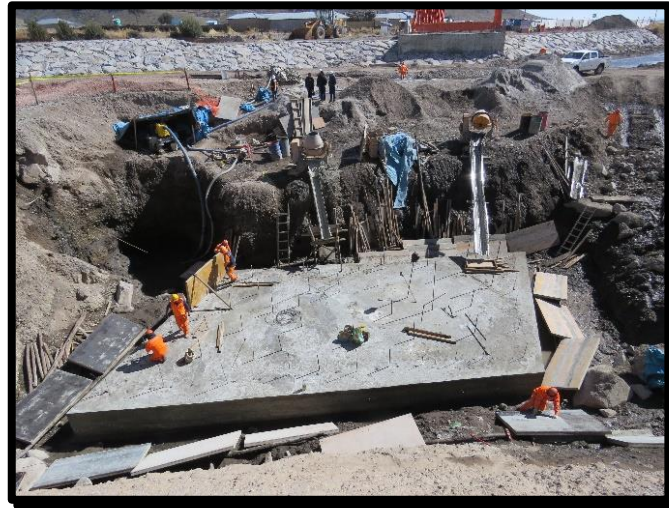
Imagen 5. Proceso constructivo deficiente, Mano de obra sin EPP, falta de limpieza de trabajo.
