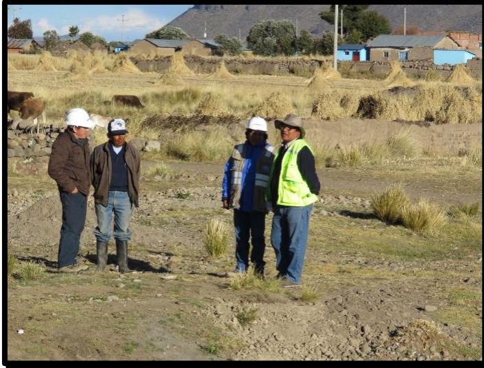
Imagen 7. Conflictos sociales, indisponibilidad de terrenos para la construcción de los accesos del puente Tanana.
