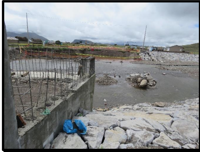
Imagen 1. Paralización de la obra por crecidas del Rio Tanana, precipitaciones pluviales; retrasos en la ejecución del estribo derecho.
