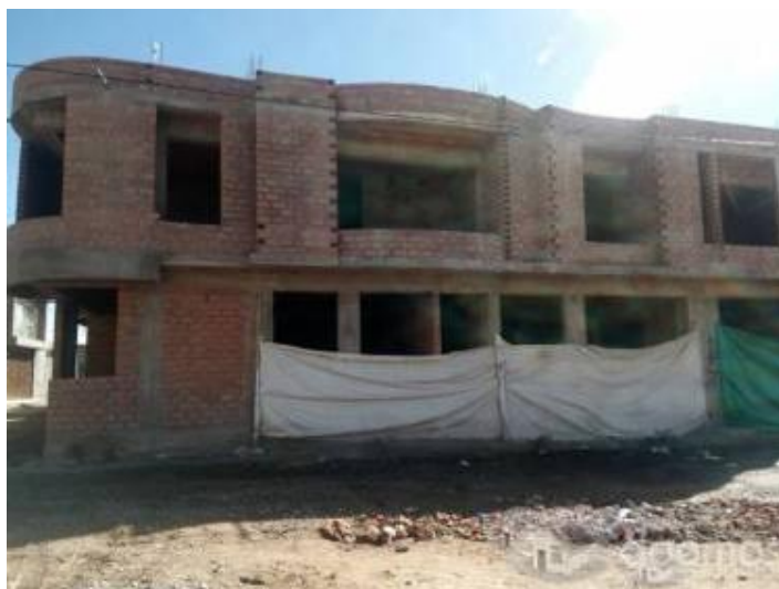
Figura 33: Vivienda en etapa de construcción (sin revestimiento en muros interiores).
