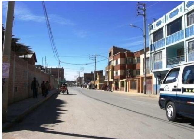
Figura 29: Edificaciones de concreto en Av. Principal.
