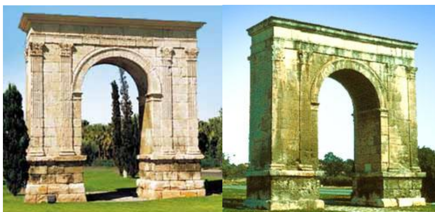
Figura 2: Las dos fachadas principales del Arco romano de Bará.
