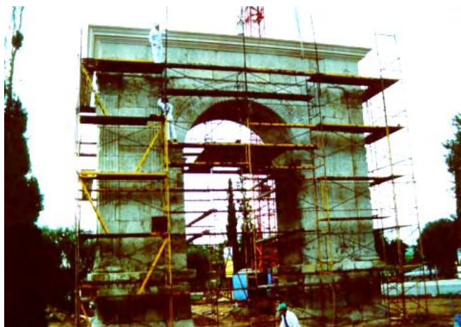
Figura 7: Imagen del procedimiento de restauración del arco de Bará.
