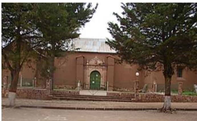
Figura 10: Vista exterior del templo Santa Cruz de Orurillo Julio 2015. Fuente: Proyecto de restauración y puesta en valor definitivo y ampliada.
