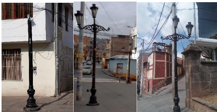
Figura 72: Luminarias en mal estado en el Arco Deustua. Fuente: Foto tomada por el equipo de trabajo.
