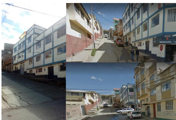
Figura 66: Vía secundaria Jr. Pardo Fuente: Foto tomada por el equipo de trabajo.
