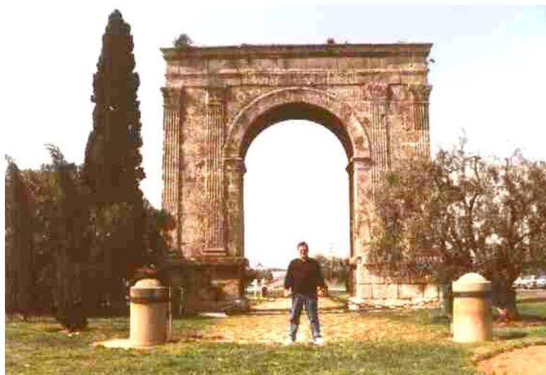
Figura 6: Arco de Bará en 2008 tras la restauración de 1994 a 1998.
