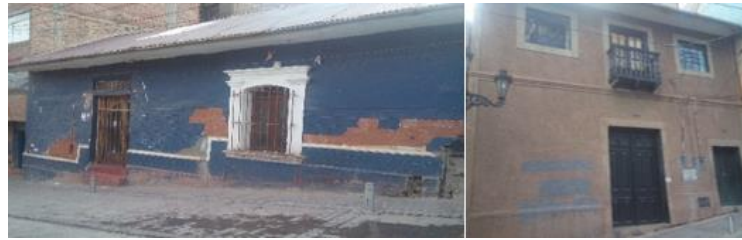
Figura 56: Viviendas antiguas. Fuente: fotografía tomada por el equipo de trabajo.
