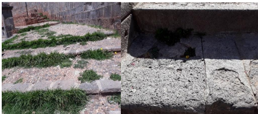
Figura 158: Pátinas y organismos en los pisos de la media glorieta oeste Fuente: Foto tomada por el equipo de trabajo.
