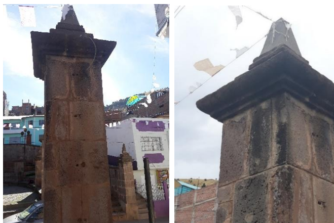
Figura 131: Pátinas negras en el pilar de la media glorieta este Fuente: Foto tomada por el equipo de trabajo.
