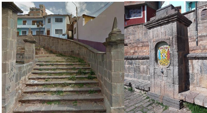
Figura 157: Patinas biológicas en graderíos y muros. Fuente: Elaborado por el equipo de trabajo.
