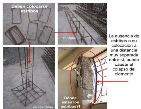
Figura N° 37: Colocación de estribos en vigas y columnas
