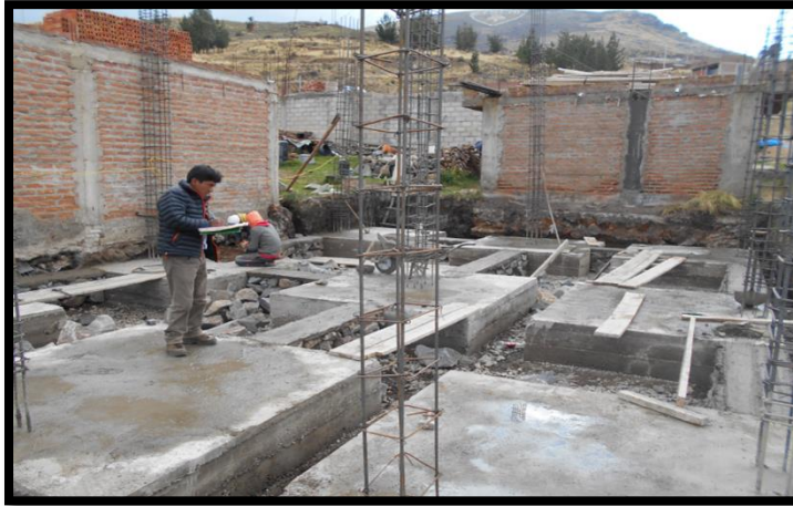
Figura N° 79: Viviendas con zapatas aisladas en zonas bofedales H.U. Flor de Sankayo.
