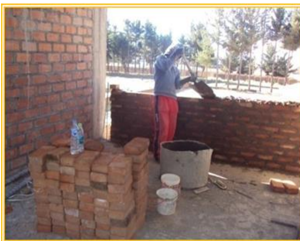
Figura N° 84: Construcción de muros sin cordel y control de plomadas.
