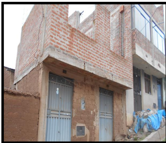
Figura N° 66: Viviendas construidas con adobe y ladrillos, Barrio Ricardo Palma.
