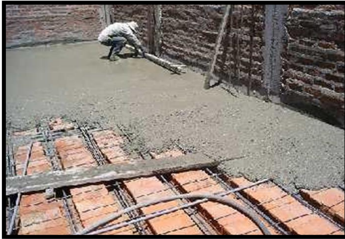
Figura N° 121: Regleado del concreto en la losa.
