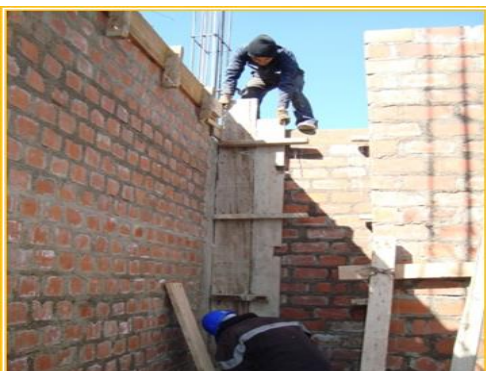
Figura N° 107: Los encofrados bien hermetizados.
