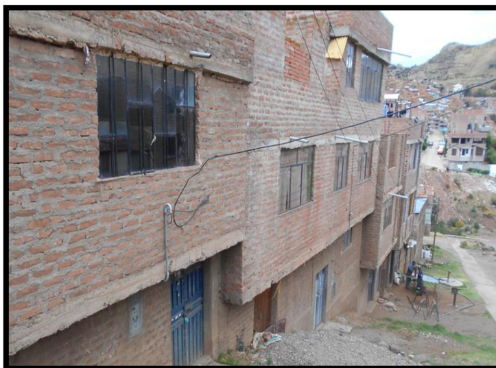
Figura N° 10: Albañilería de ladrillo en los Barrios
