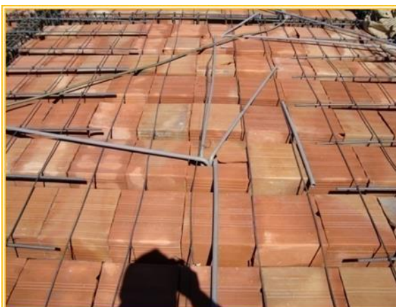
Figura N° 104: Construcción de losas y viguetas.
