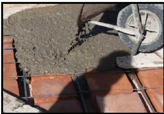
Figura N° 119: Preparación y colocación del concreto en situ.
