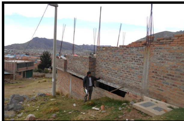
Figura N° 61: Viviendas construidas con unidades de albañilería crudo.
