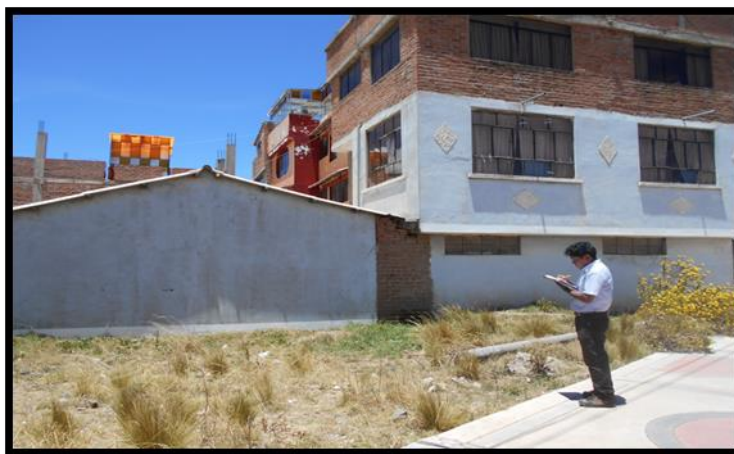
Figura N° 11: Mampostería de ladrillo en los barrios.
