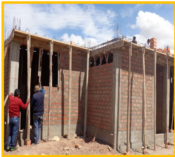
Figura N° 108: Habilitado de ventanas.
