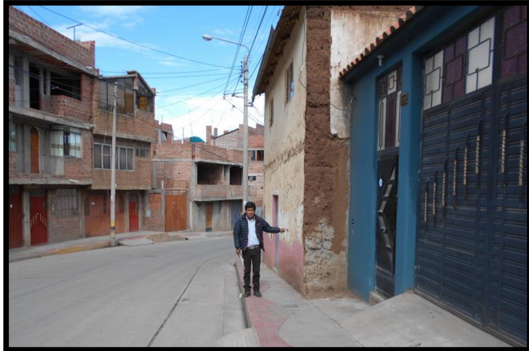
Figura N° 9: Albañilería de Adobe, Barrio Pacha.
