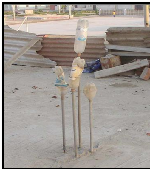
Figura N° 54: Acero de columna protegido con botellas de plástico y tubos de PVC.
