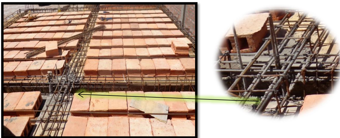
Figura N° 120: Colocación del concreto en viviendas.
