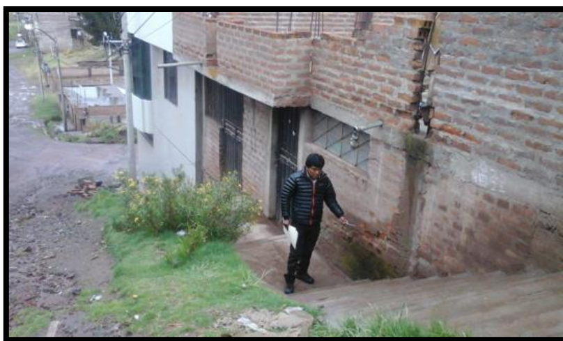
Figura N° 126: Vivienda ubicada en el Barrio San José
