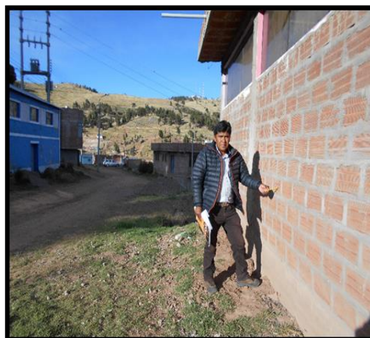
Figura N° 64: Viviendas sin junta sísmica y losas a desnivel
