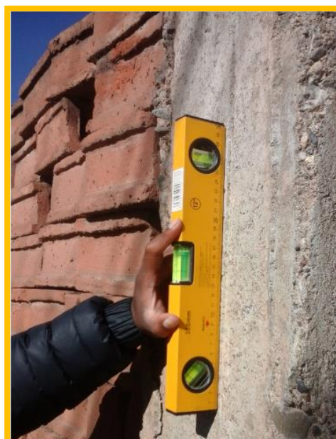
Figura N° 109: Verticalidad de los encofrados en columnas.
