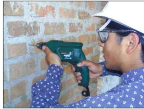
Fig. 08 Perforaciones con el taladro
