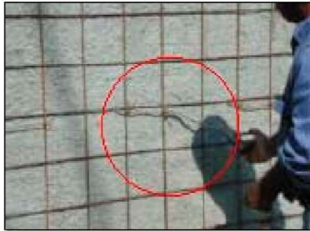
Fig. 49 Fijado de la malla electrosoldada
