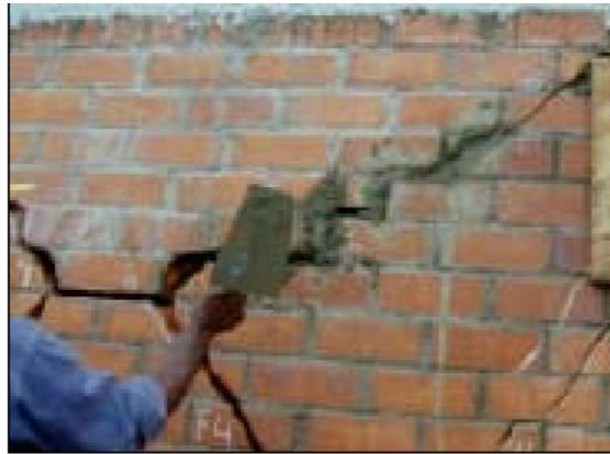
Fig. 45 Reparación de grietas gruesas
