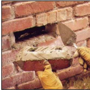
Fig. 20 Colocación de nuevo ladrillo (Black & Decker 2000)
