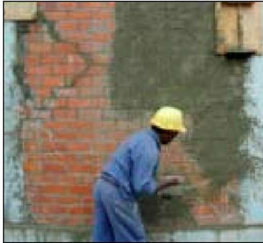
Fig. 47 Pañeteo del muro
