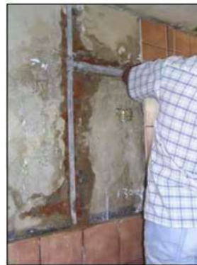
Fig. 39 Picado de muro
