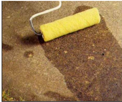
Fig. 36 Aplicación de solución limpiadora (Black & Decker 2000)
