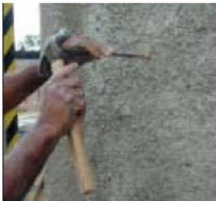
Fig. 48 Perforación del muro
