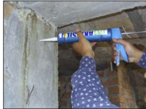
Fig. 23 Inyección de grietas con resina epóxica
