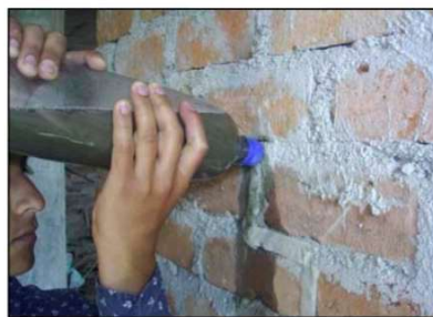
Fig. 12 Inyección de grietas con lechada de cemento
