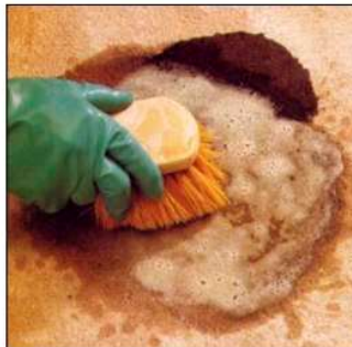
Fig. 35 Lavado de la zona afectada (Black & Decker 2000)
