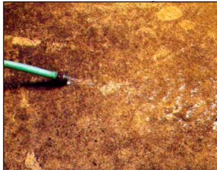
Fig. 37 Enjuague de la superficie con agua (Black & Decker 2000)
