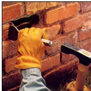
Fig. 18 Extracción de ladrillo (Black & Decker 2000)
