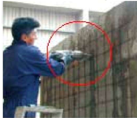
Fig. 50 Inyección de perforaciones
