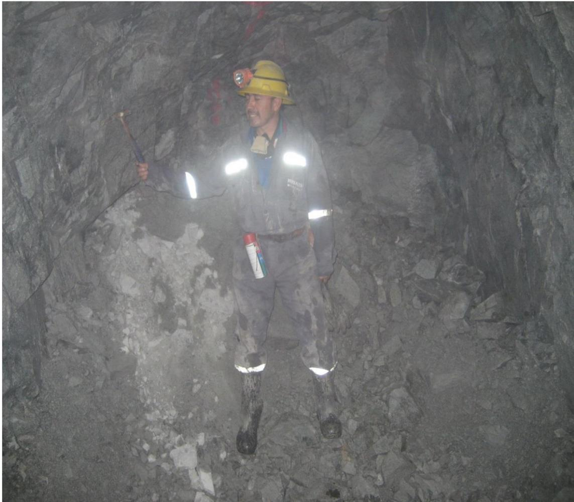
Figura 4.5 Resultados de descaje de hastiales en tajeo de explotación Carlota
