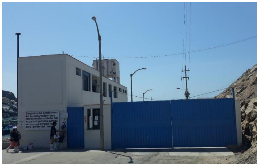
Figura 3. 4: Imagen externa de la entrada vehicular y de peatones.
