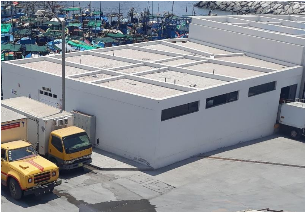
Figura 3. 10: Imagen del área de almacenamiento de pescados.
