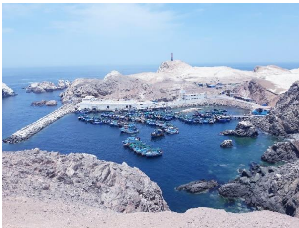
Figura 3. 1: Imagen panorámica del puerto marítimo ‘El Faro Matarani’.
