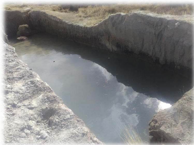
Figura N° 4.2. Captación de agua para la impulsión.
