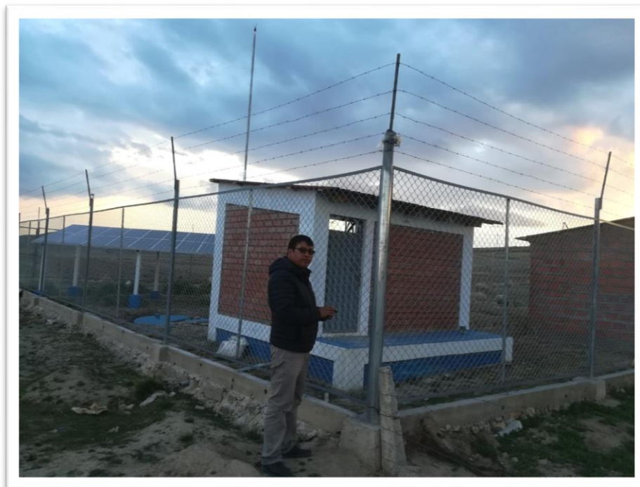
Foto N° 02: Instalaciones de paneles fotovoltaicos en la captación del Centro Poblado de Piñutani de la Provincia el Collao –ilave
