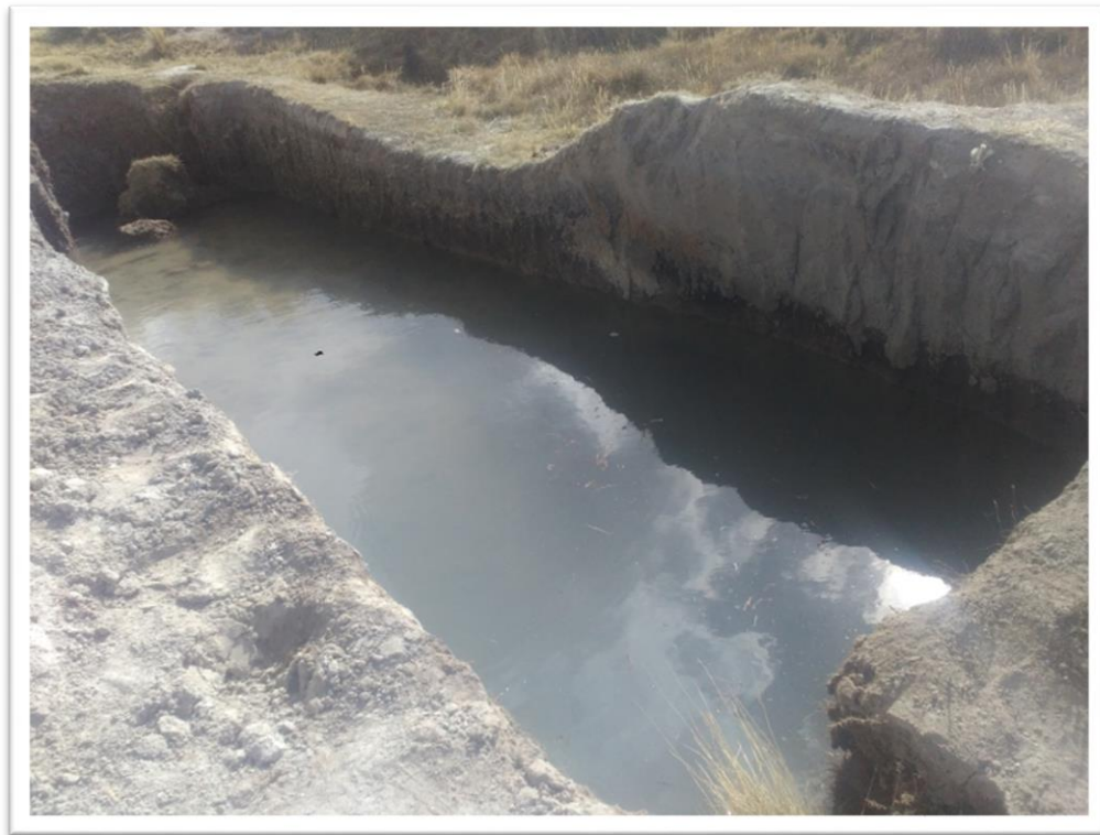
Foto N° 01: Captación de agua
