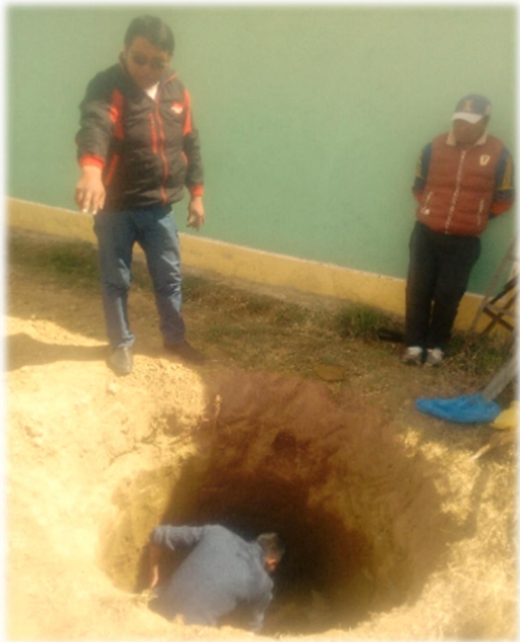
Figura N° 4.24. Excavación de la calicata P-01. Fuente: Elaboración propia.
