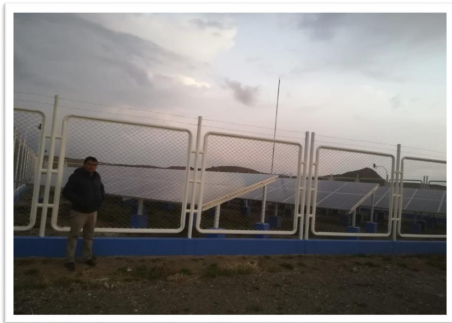
Foto N° 01: Instalaciones de paneles fotovoltaicos en la zona norte de captación de provincia El Collao- Ilave
