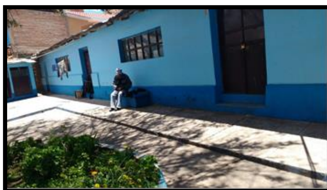
FIGURA 1 Estado Actual Del Albergue De Juliaca
