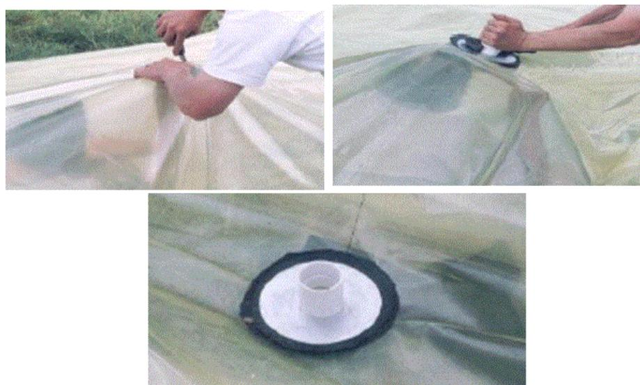
**FIGURA. 63. Conexión para gas y politubo.**
