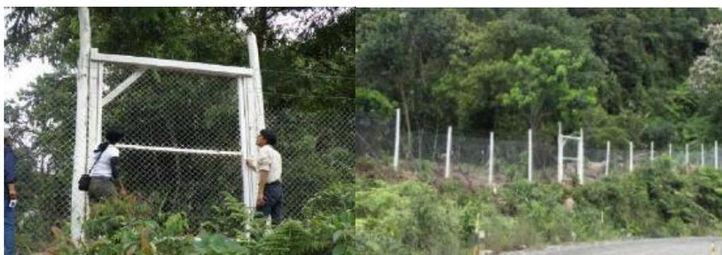
**FIGURA. 4. Cerco metálico con portón, colocado a lo largo de la terraza por el consorcio Intersur, fines del 2008(N. Román, Intersur)**
