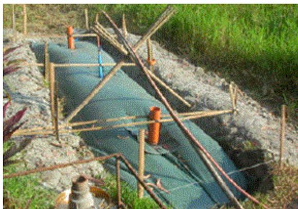
**FIGURA. 60. Instalación de Biodigestor.**
