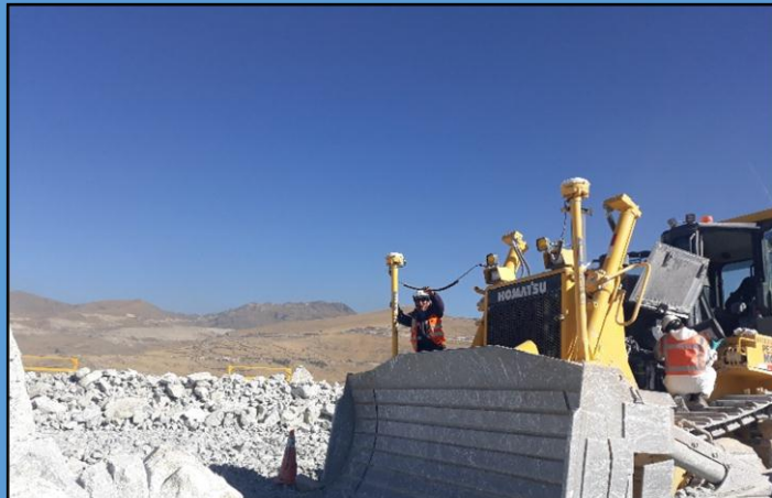
Foto N° 04: Implementando el sistema GNSS a tractores KOMATSU, para la conformación del material tipo 2 en la Presa de Relaves Minera las Bambas Fase III
