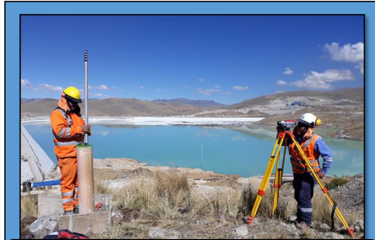
Foto N° 01: Nivelación de puntos de control en la Presa de Relaves Minera las Bambas Fase III
