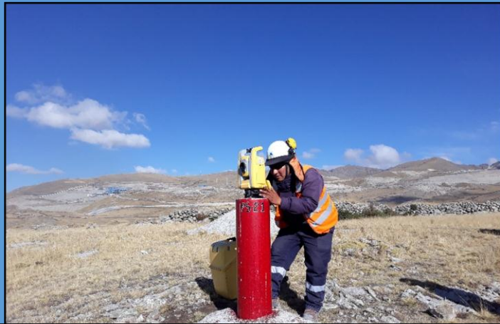
Foto N° 04: Tomando lectura de ángulos para el cálculo de la poligonal en la Presa de Relaves Minera las Bambas Fase III
