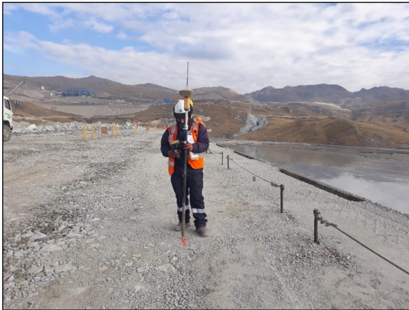
Figura 30: Ing. Topógrafo realizando el replanteo y levantamiento topográfico del material 1B.
