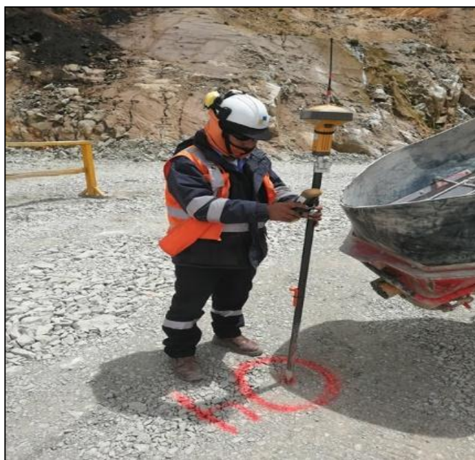
Figura 33: Ingeniero Topógrafo realizando el replanteo de puntos entre el límite de material 2A y 1B.
