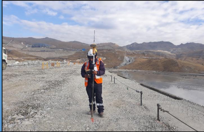
Foto N° 05: Replanteando limite entre material tipo 1b y 2A, previo al levantamiento topográfico en la Presa Relaves Minera las Bambas Fase III.
