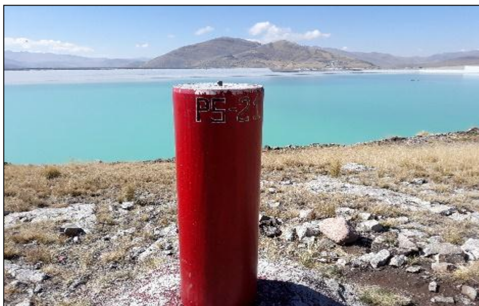
Figura 12: Monumentación del puntos de control.
