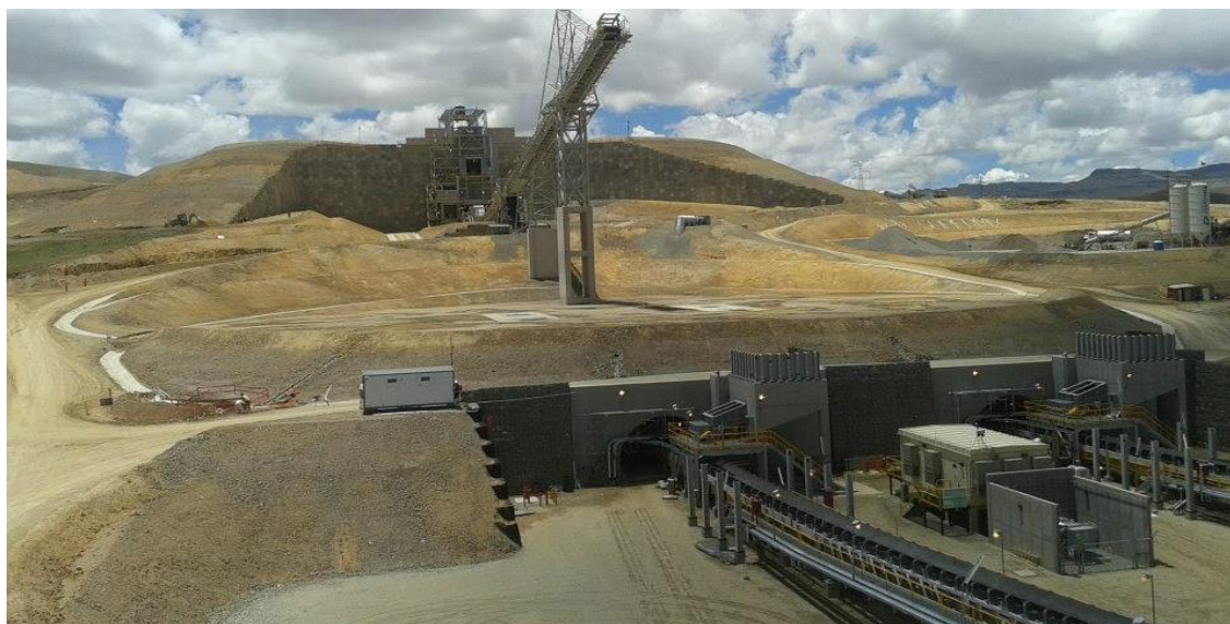
Figura 2.21: Vista del complejo de la chancadora secundaria con sus fajas transportadoras.
