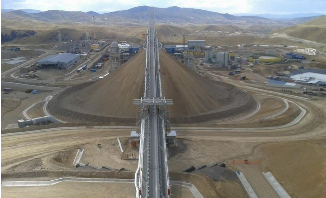
Figura 2.20: Vista del transporte por fajas hacia una pila de mineral.
