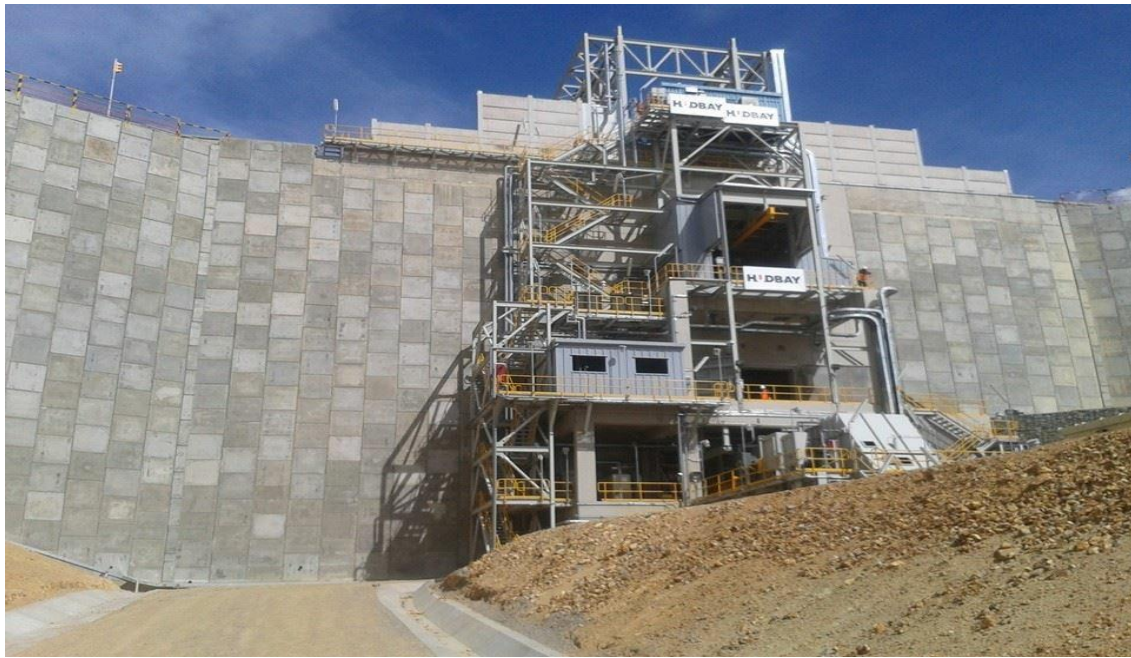
Figura 2.19: Vista del complejo de chancado primario.
