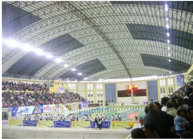
Figura 26: Elemento estructural, piscina de CENARD
