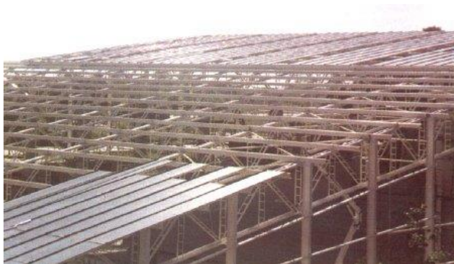
Figura 25: Detalle estructura metálica de CENARD
