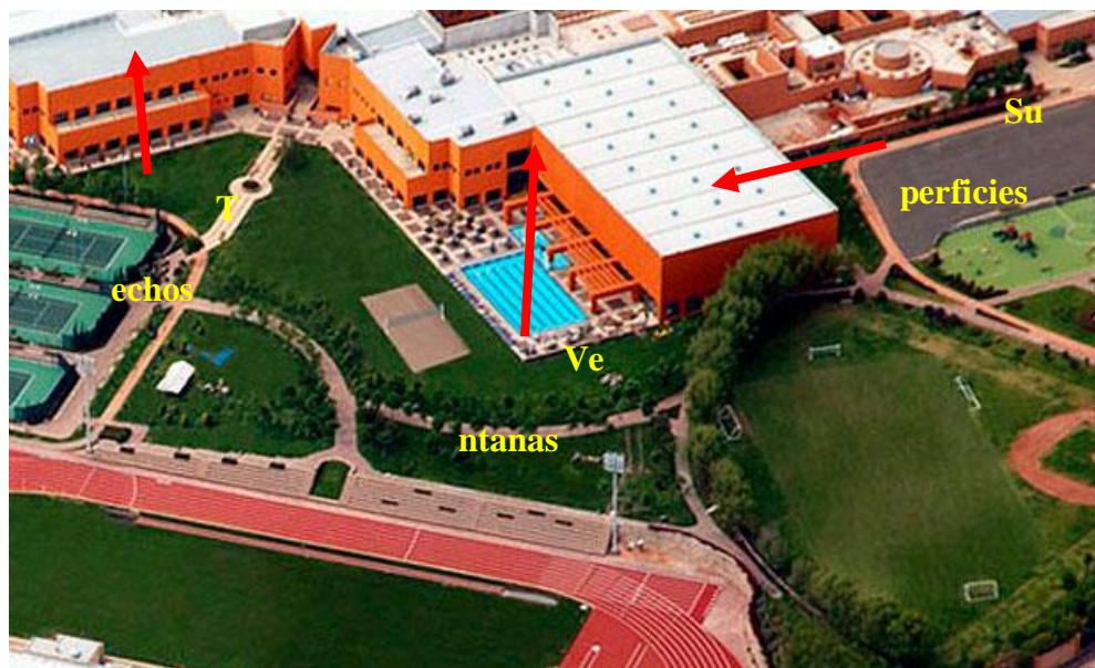
Figura 3 Volumen central del Centro de Alto Rendimiento "La Loma"
