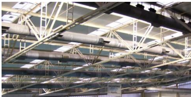
Figura 33: Estructura metálica - ventilación de CENARD
