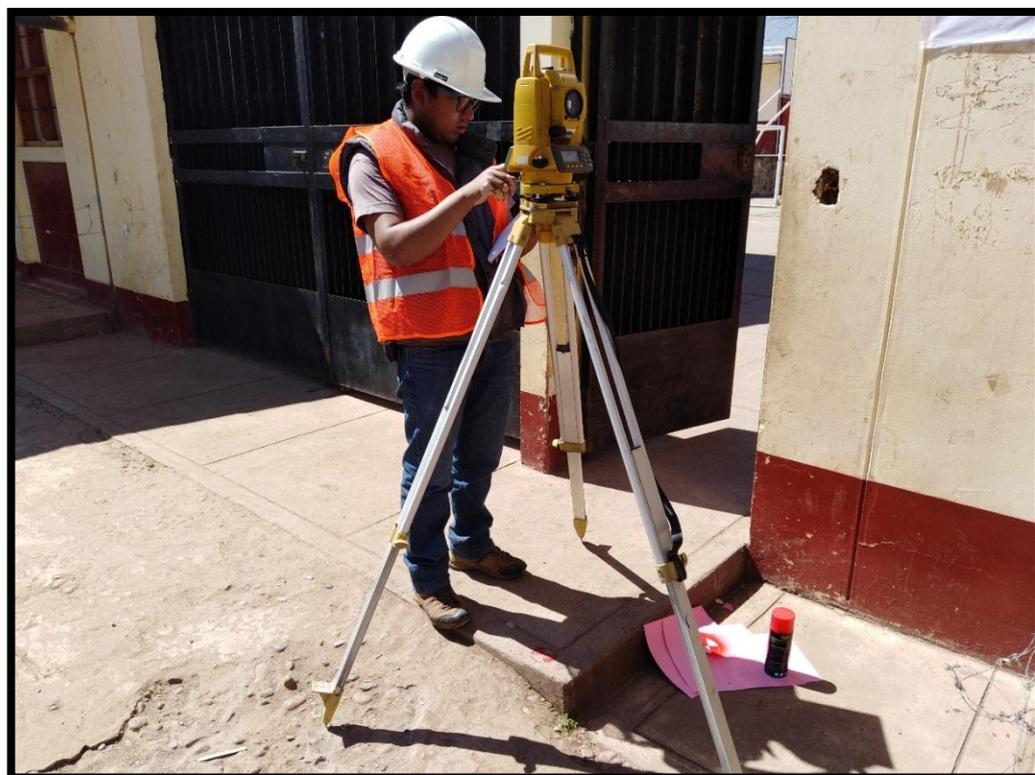
**Figura 19:** Trabajos con Estación Total.
