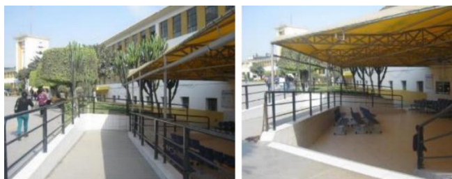
Figura 14. Ingreso a la sala de operaciones del Hospital Hipólito UNANUE. Fuente: (Ministerio de Salud & UNI, 2013)
