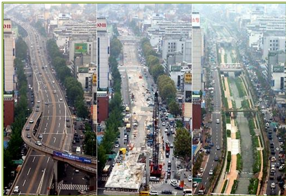
Figura 9: La gran renovación urbana del eje del Cheong Gye Cheon: de autopista a río. Fuente: web, http://urban-networks.blogspot.pe/2015/12/la-recuperacion-del-rio-perdido-de-seul.html
