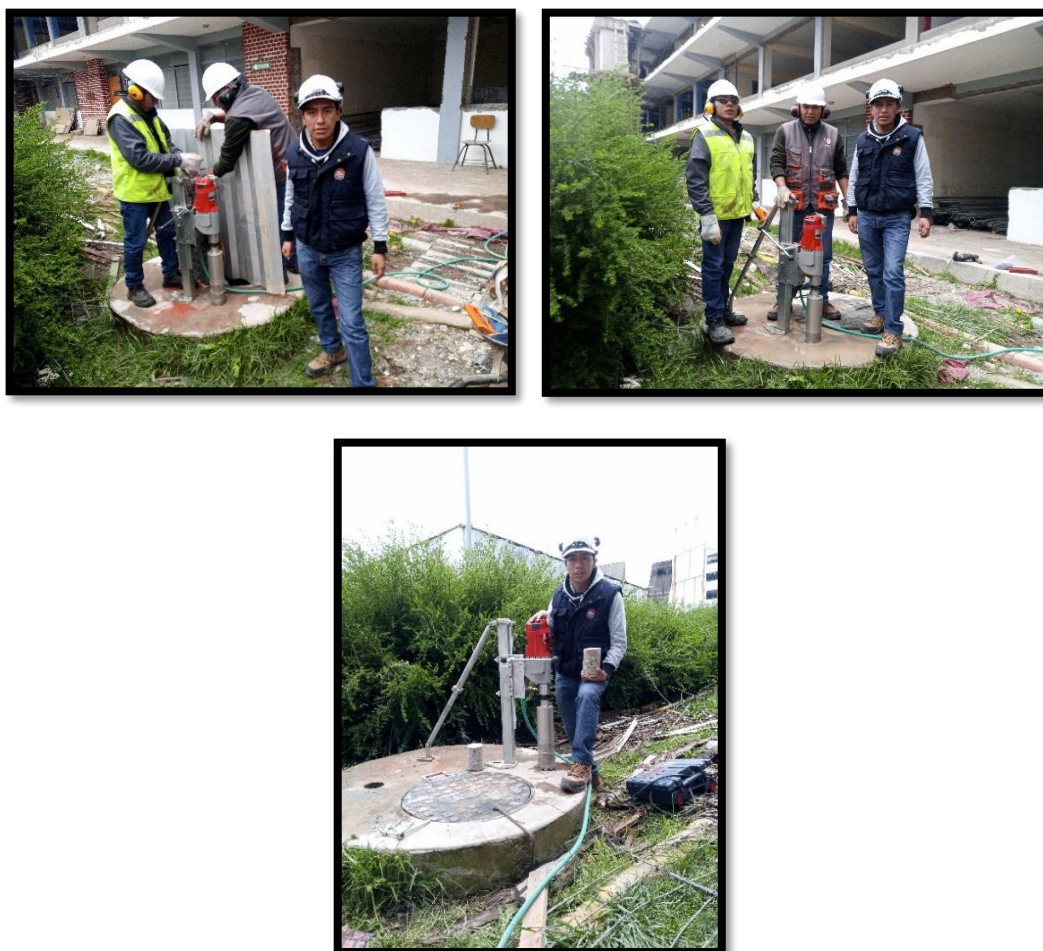
Figura 23: Extracción de muestras con perforadora diamantina Fuente: Elaboración por el equipo de trabajo
