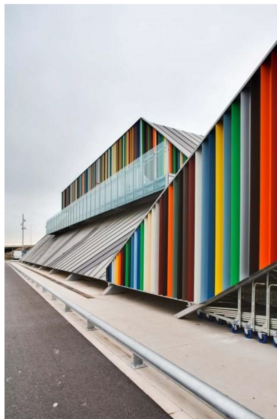
Figura 13: Cubierta con placas de zinc
