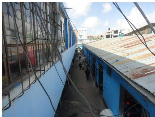
Contaminación visual, interior de la plataforma comercial.
