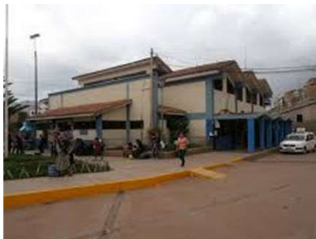
Figura 13 INGRESO DE TERMINAL TERRESTRE DE CUSCO
