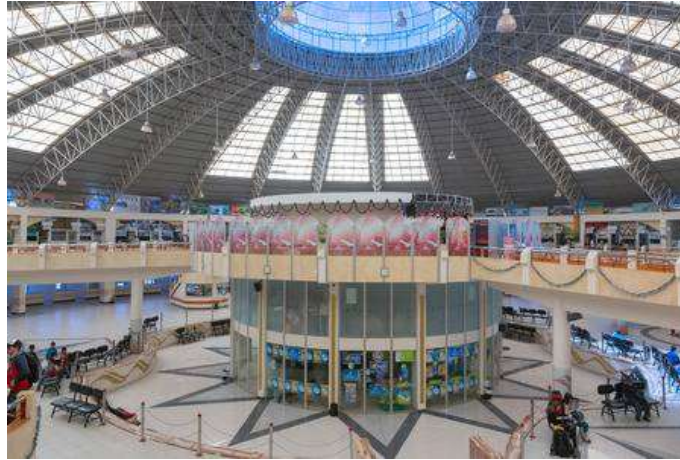
Figura 8 TECHO DE TERMINAL DE POTOSI
