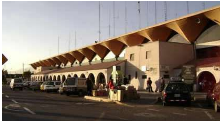
Figura 15 TERMINAL TERRESTRE DE AREQUIPA
