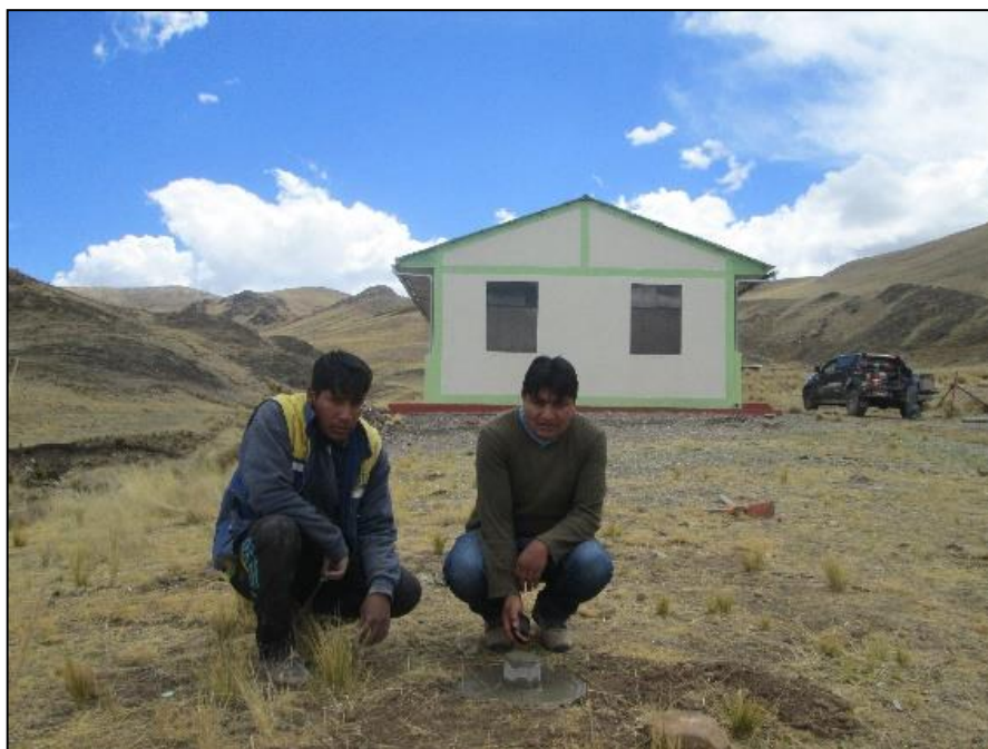
IMAGEN 1. Se muestra la monumentación para control de geodésico de orden "C" en sector Altura
