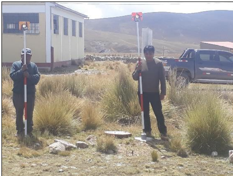
IMAGEN 6. Se muestra el levantamiento topográfico de punto de control geodésico puesto con GPSD.
